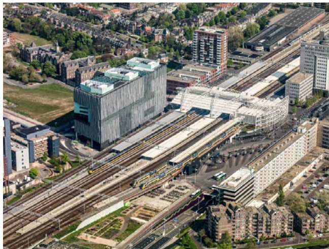
42 Boven: Ingang van Leiden Centraal aan noordelijke zijde van het station.
