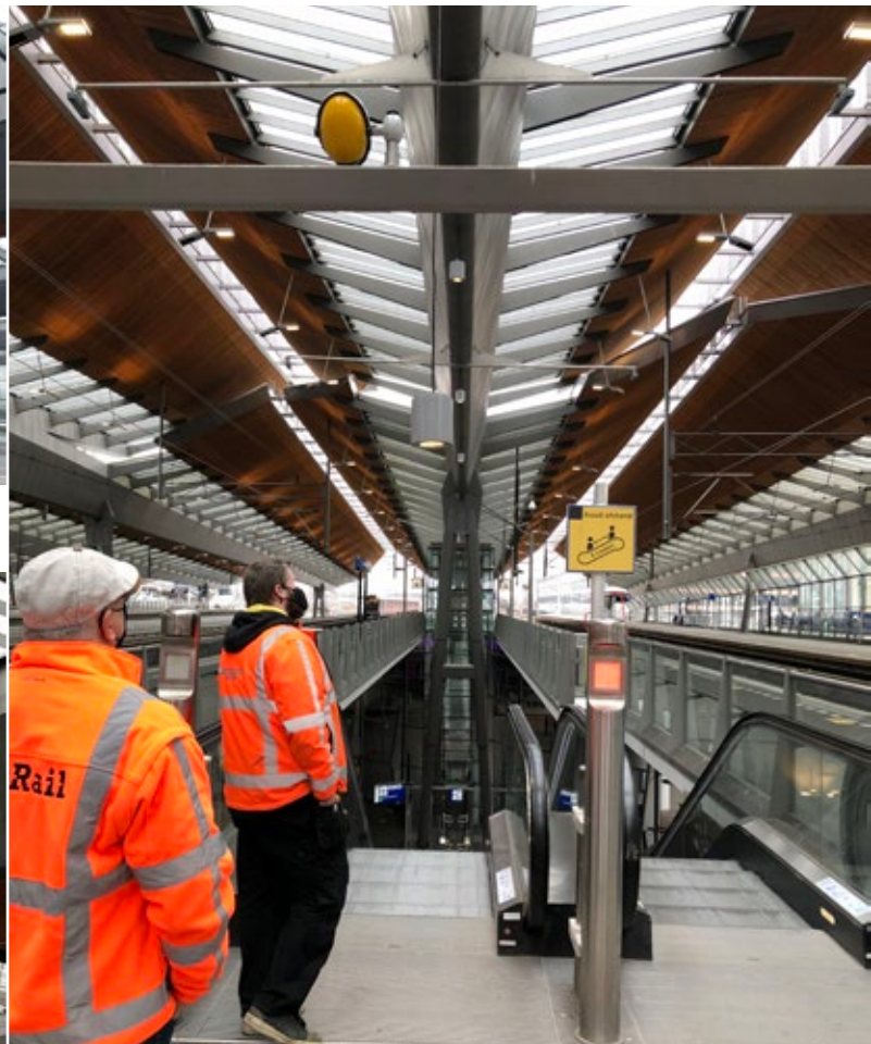
Strahler über der Rolltreppe mit einer Markisenwinde absenken, da auf der Rolltreppe keine Hebebühne eingesetzt werden kann.
