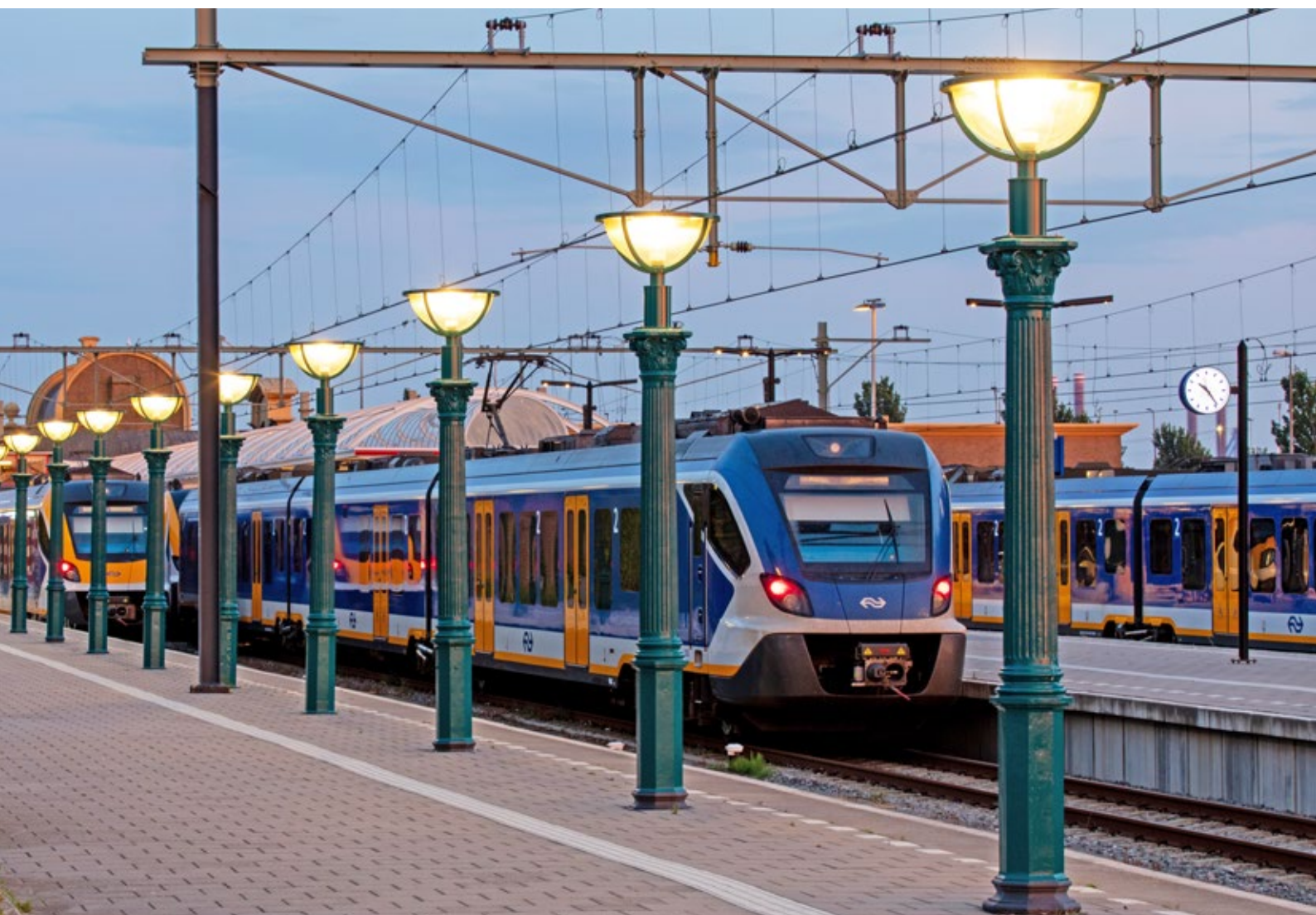
Historische gusseiserne Lichtmasten am Bahnhof Vlissingen, ausgestattet mit maßgeschneiderten LED-Leuchten und neuen transparenten Schirmen.
