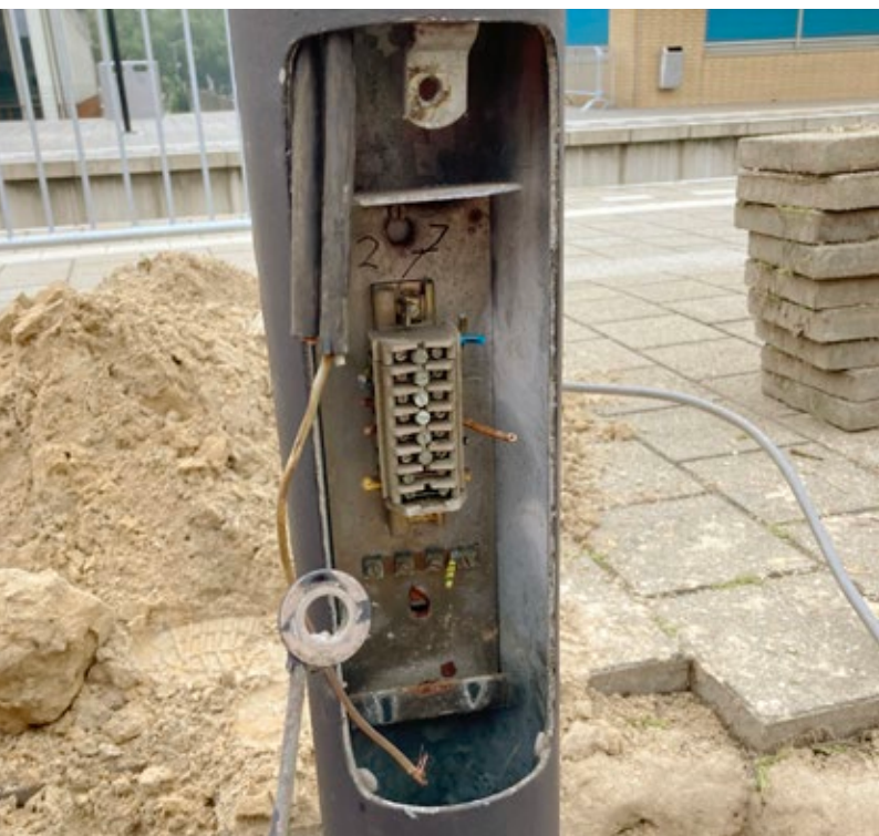
Mast-Schienen-Verbindung (Erdnetz zwischen den alten Lichtmasten) im Werk saniert.
