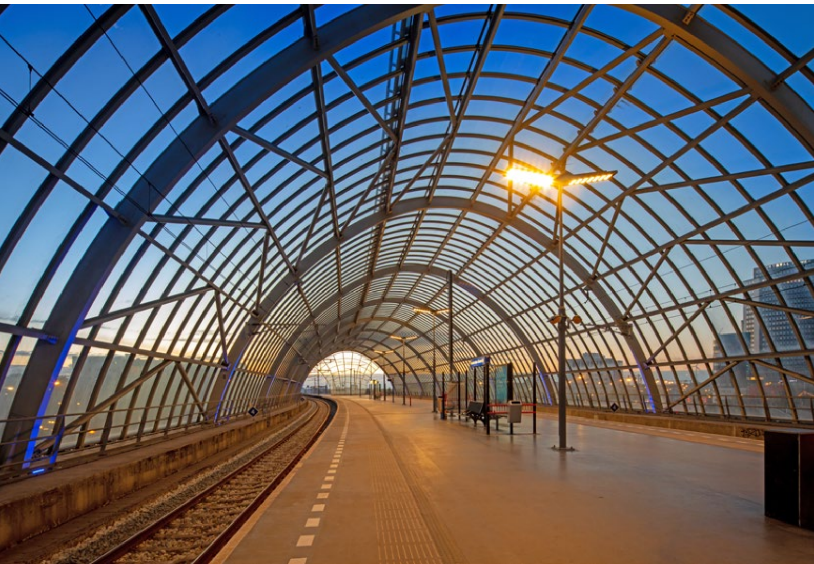
Bahnhof Amsterdam Sloterdijk Hemboog. Um die Bögen der Überdachung nicht durch Leuchten zu stören, entschied sich der Architekt für Lichtmasten unter der Überdachung. Um Blendwirkung zu vermeiden, wurden höhere Masten als bei normalen Bahnsteigen verwendet.
