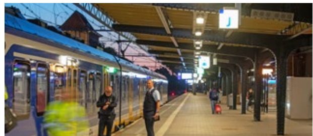
Der Bahnsteig in Deventer nach der Erneuerung.
