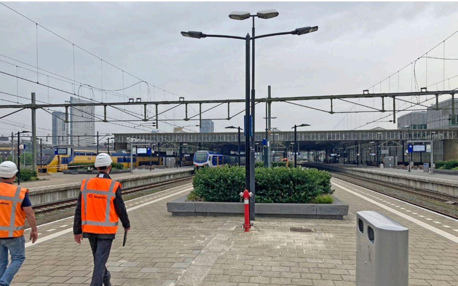
Der neue Mast wurde bereits aufgestellt, während der alte noch abgerissen werden muss.
