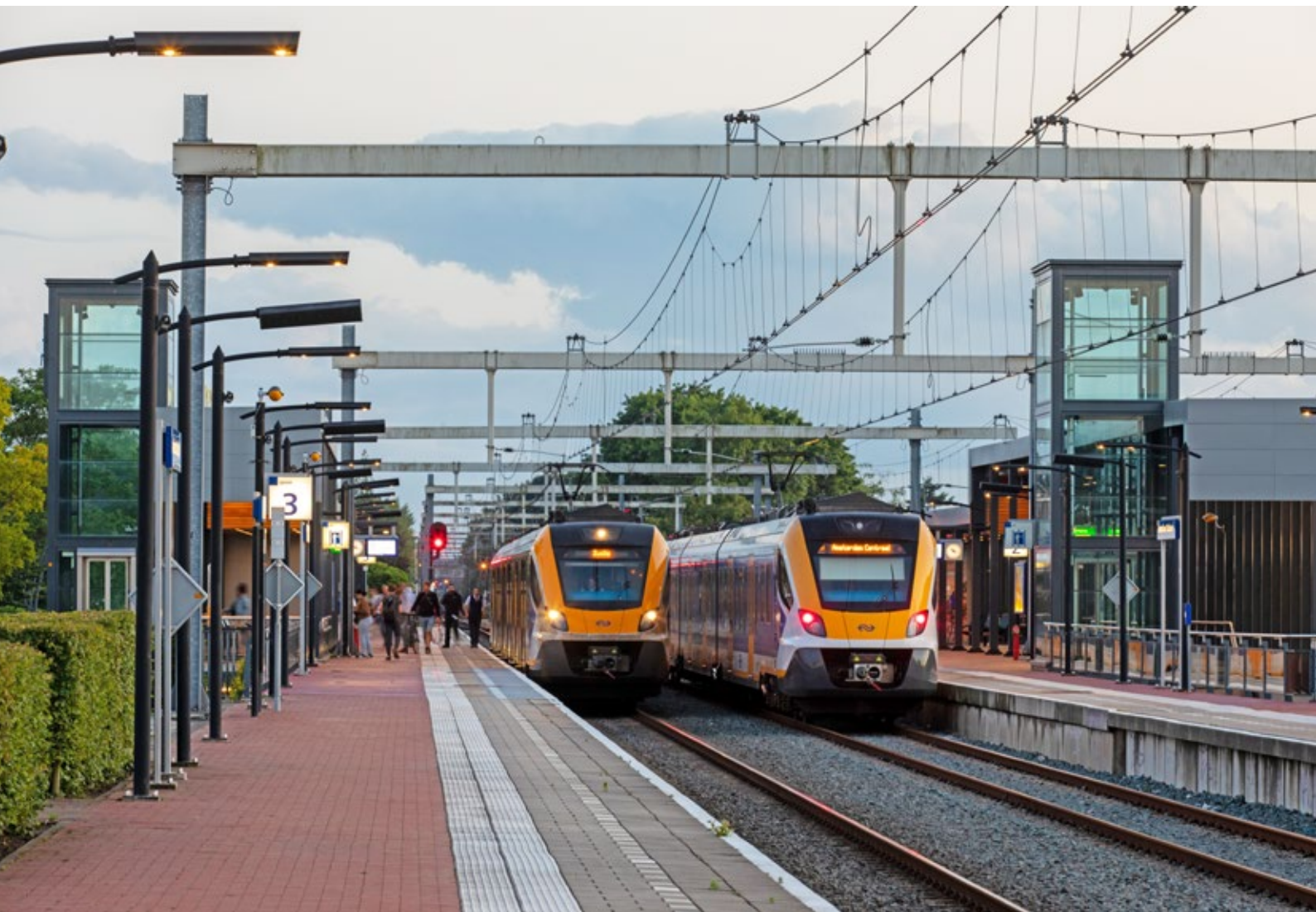
Bahnhof Vathorst nach dem Austausch der LED. Die einzelnen Lautsprechermasten zwischen den Lichtmasten sind gut zu erkennen. Mit dem Mehrzweckmast (siehe Kapitel 18) wollen wir einen solchen Mastenwald vermeiden.
