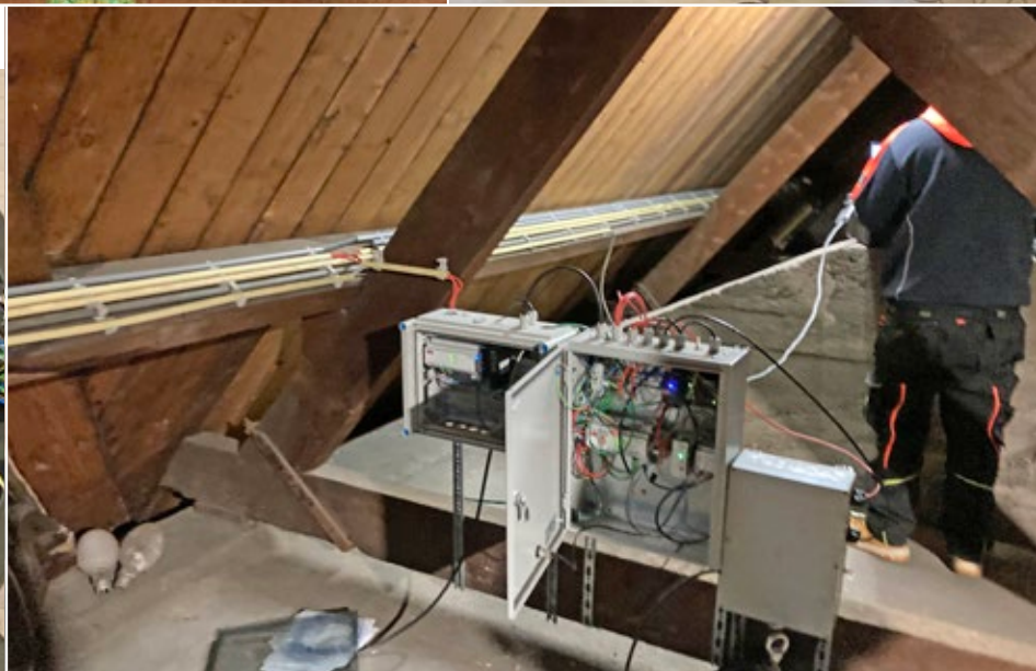
Lichtsteuerung im Dachgeschoss über der Halle.
