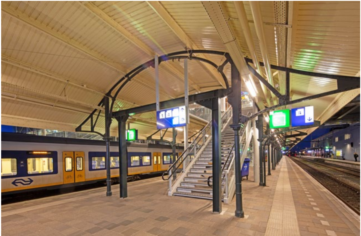
Die monumentale Überdachung mit der neuen LED-Beleuchtung unter dem neuen Kabelkanal.
