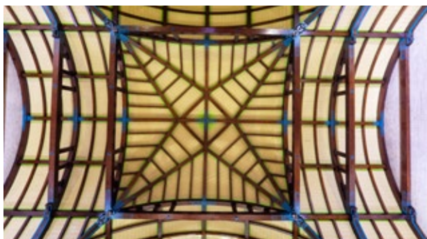
Dachkonstruktion der Halle.
