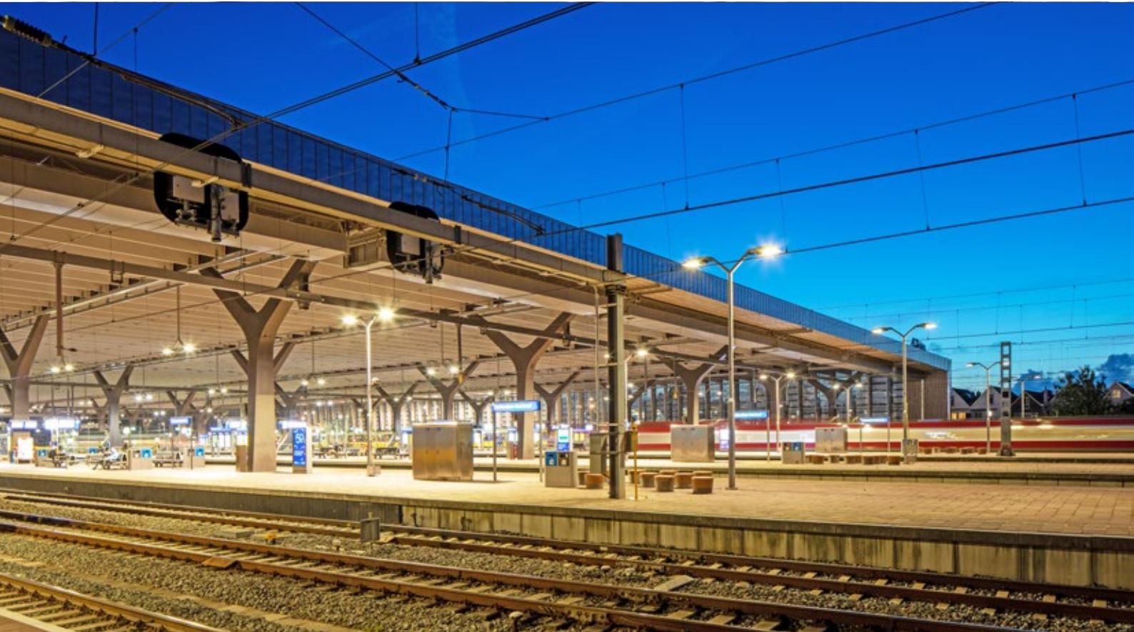
Masten außerhalb der Überdachung.
