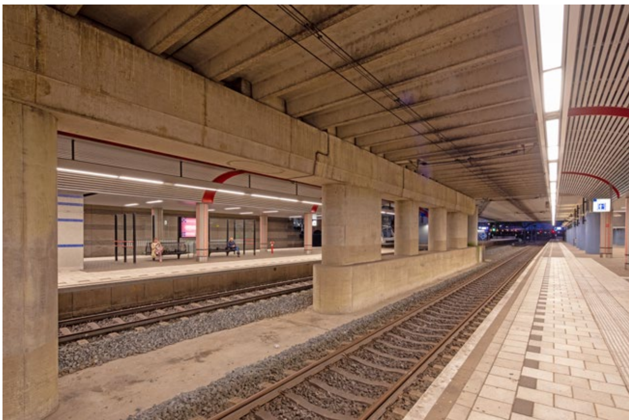
Die vollständig überdachten Bahnsteige des Bahnhofs Amsterdam Sloterdijk bei 200 Lux am Abend nach dem LED-Austausch.
