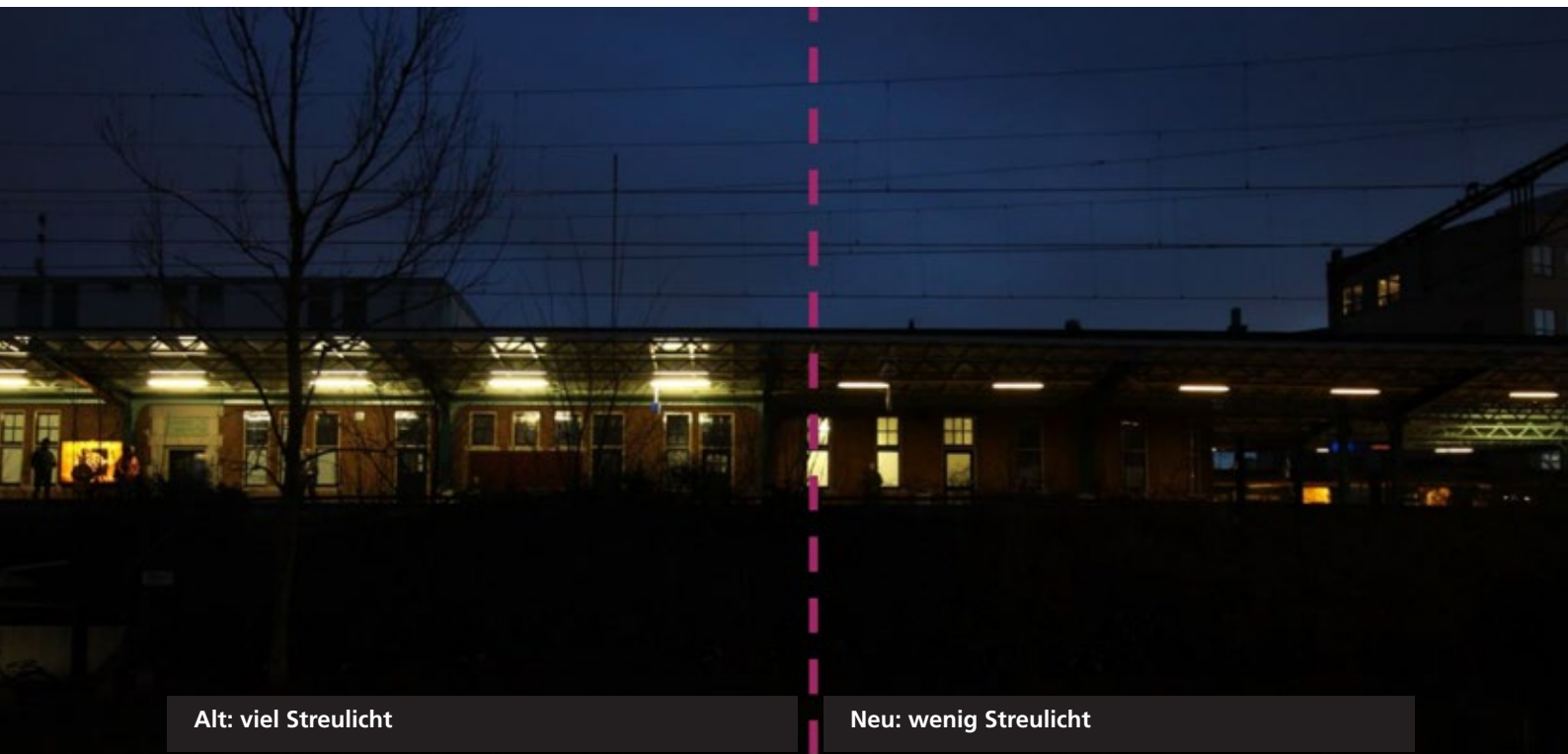
Ansicht des Bahnhofs von der Rückseite. Auf der linken Seite: die alten Vorrichtungen. Rechts die neuen Leuchten mit viel weniger Streulicht.
