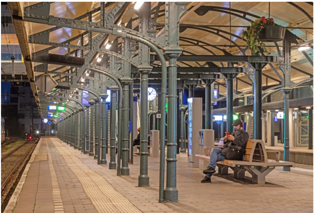
Die monumentale Überdachung mit der neuen Beleuchtung
