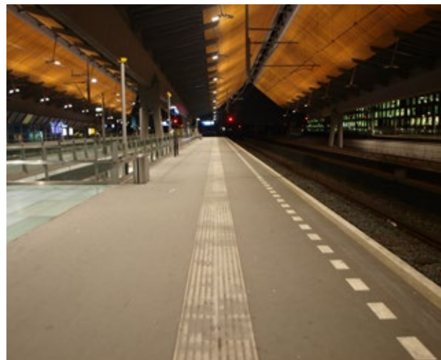
Die Situation vor dem Austausch der LED. Ein großer Teil der Uplights war fehlerhaft.
