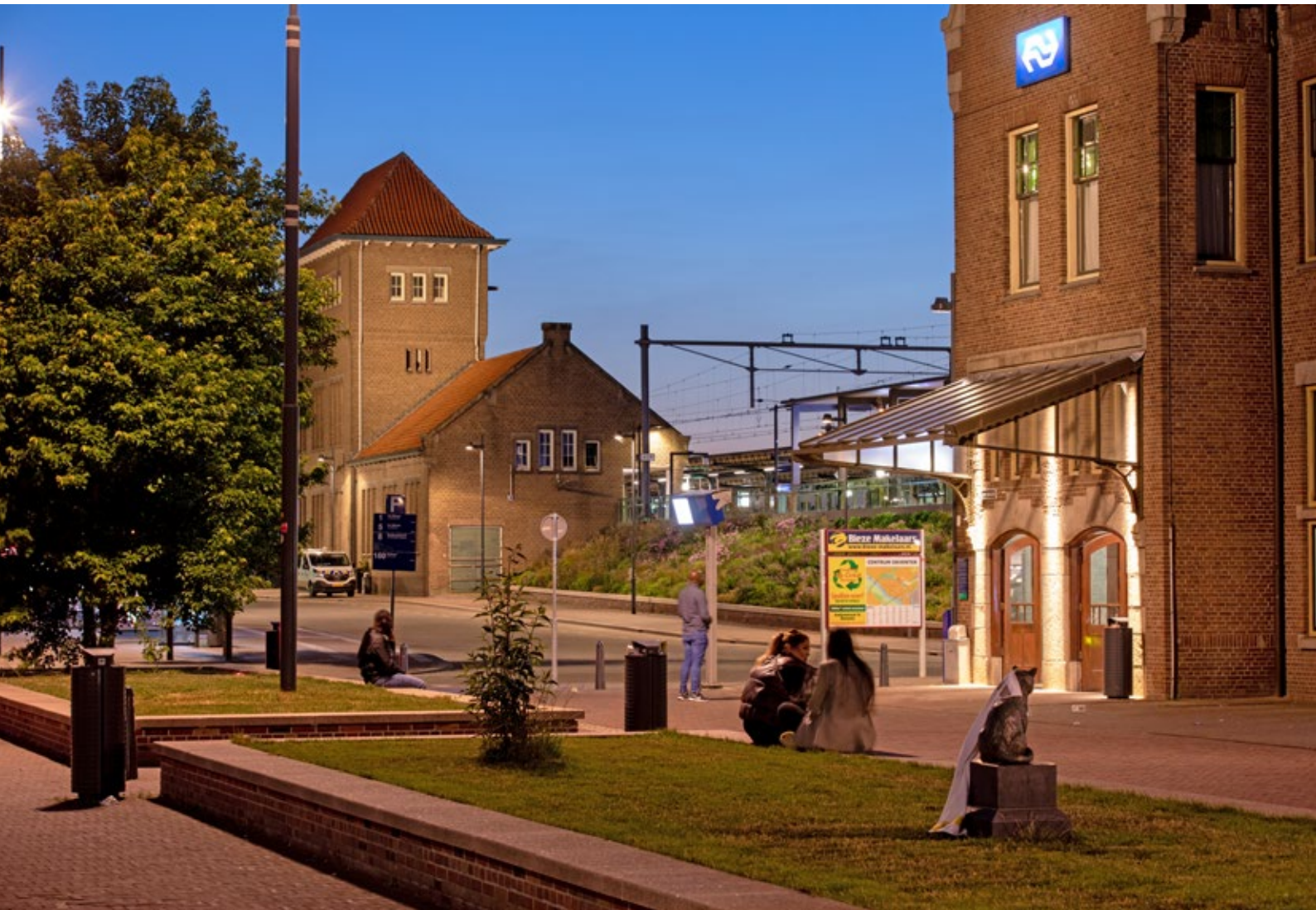
Beleuchtung Bahnhofsvorplatz Deventer
