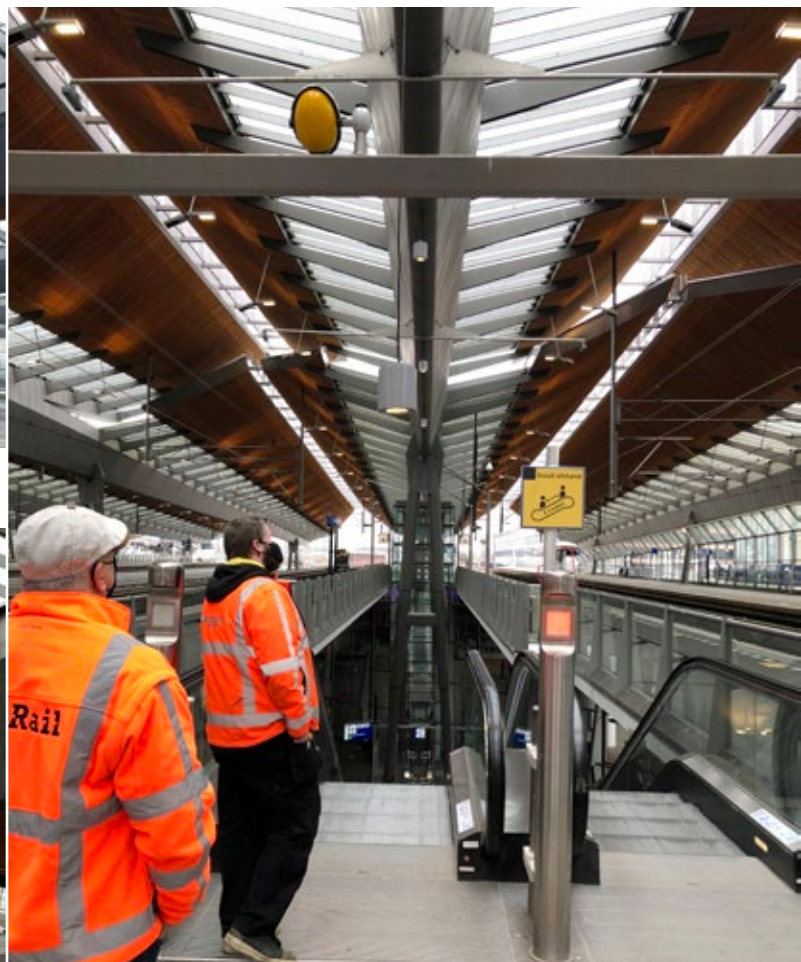
Spot boven de roltrap met een zonneschermliertje laten zakken want op roltrap kan geen hoogwerker.
