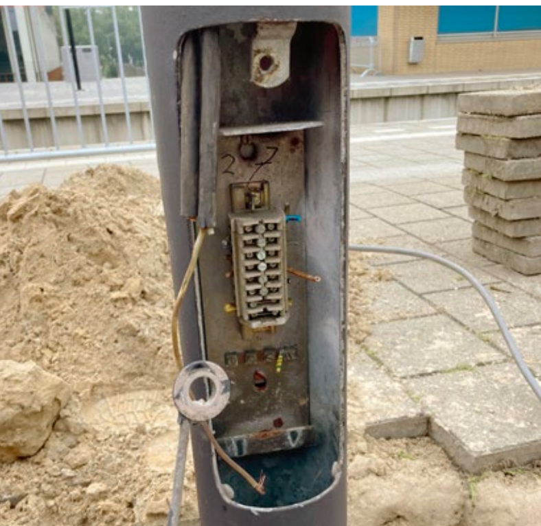
Paal - spoorstaafverbinding (aardnetwerk tussen de oude lichtmasten) in het werk gesaneerd.
