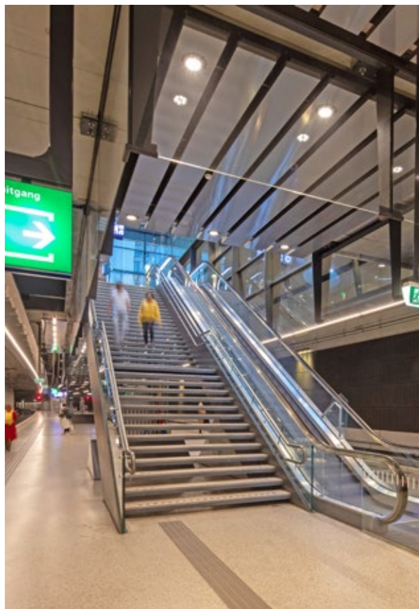
Op het midden bordes van de trap was te weinig licht. Hier zijn nu (achter de lamellen) extra spots geplaatst.
