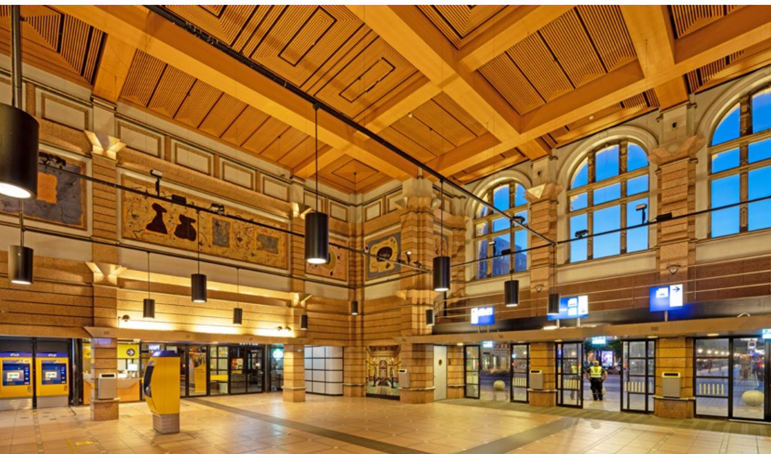
Huidige situatie: de monumentale hal die door de downlighters een verlaagd plafond lijkt te hebben.
