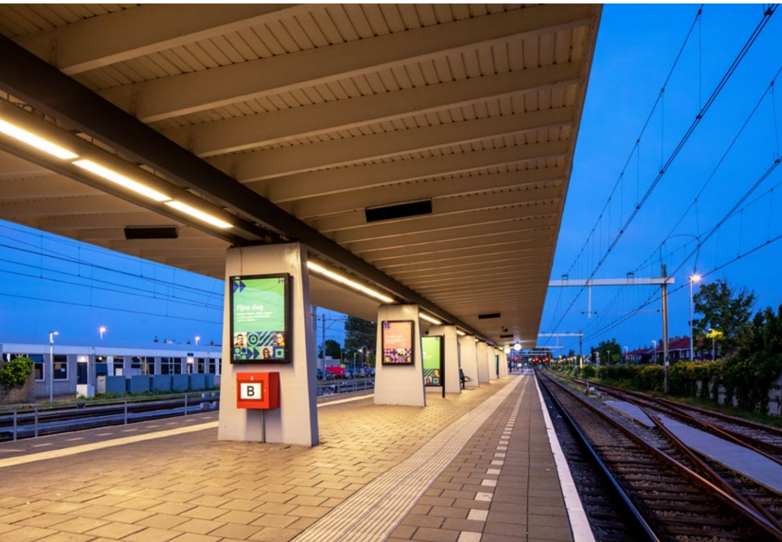
De strakke kap op station Den Helder. Kabels, goten en leidingen zijn in centrale ligger uit het zicht weggewerkt (maatwerk armatuur in de ligger schoongemaakt en voorzien van led binnenwerk).
