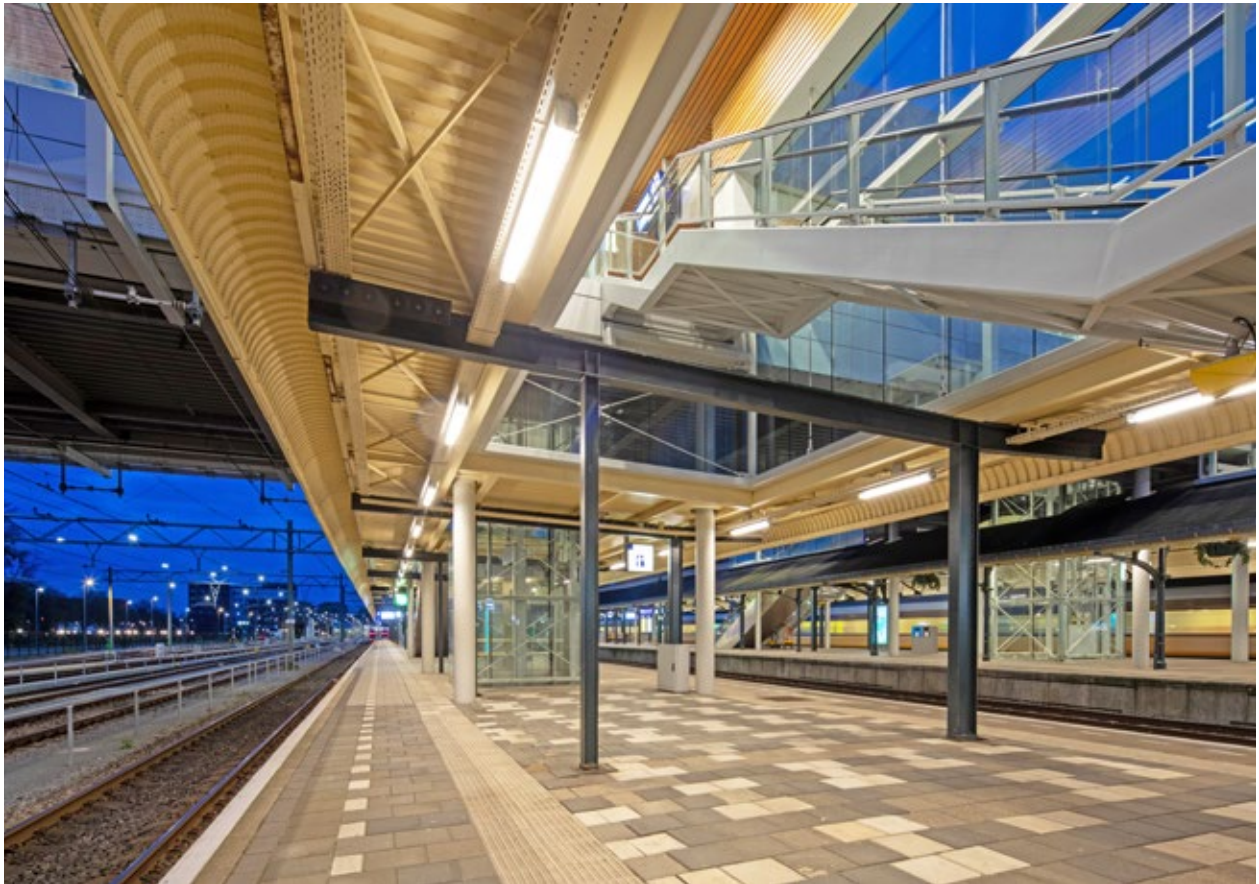
Perron 3 (de moderne kap), met de nieuwe kabelgoot in zone C en de oude goot in zone A. Op de oude goot zijn nog slecht geverfde plekken zichtbaar op de posities van de oude armaturen. Deze plekken zijn inmiddels geschilderd.
