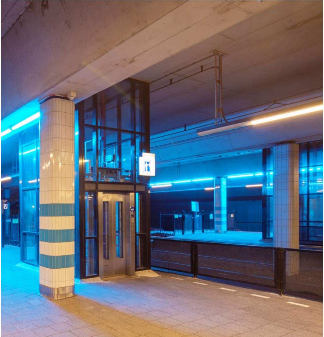
Het perroneinde aan de noordzijde bij de oplevering in 2019, wanneer het blauwe licht aan springt. Er zijn hekwerken voor het perroneinde aangebracht. Het hek kan nog open als vluchtweg maar is wel voorzien van bordjes over de suicide preventie hulplijn 0800-0113.
