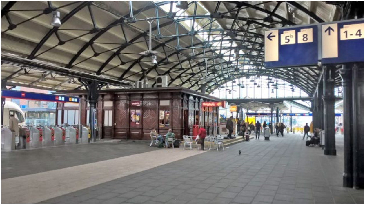
De oude situatie (kap niet aangelicht).
