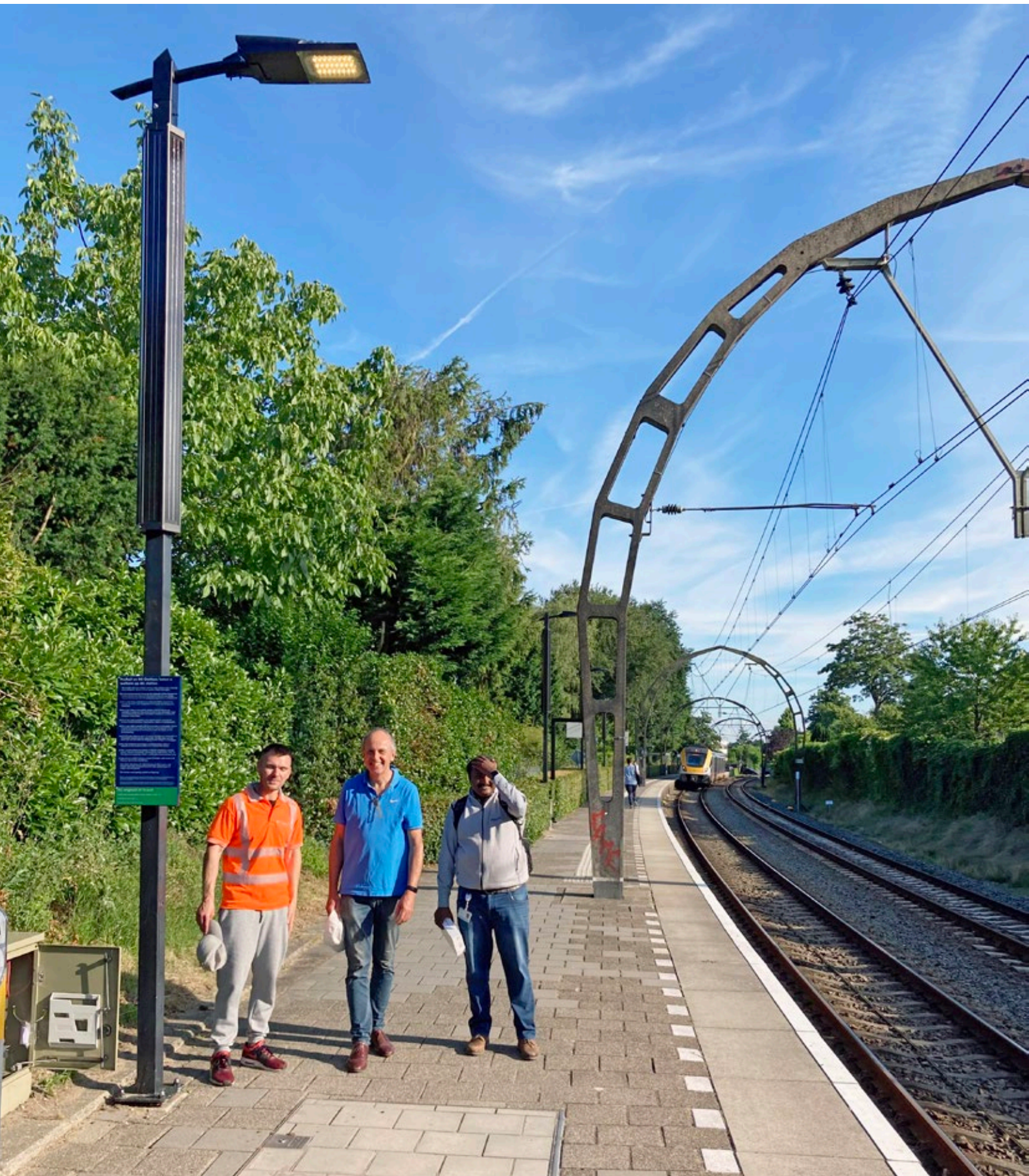
Signify Solar armatuur en panelen bij de inbedrijfstelling op Hilversum Sportpark (de auteur in het midden).
