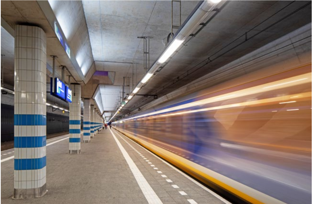
Station Rijswijk met 3000K downlighters en 4000K uplighters.
