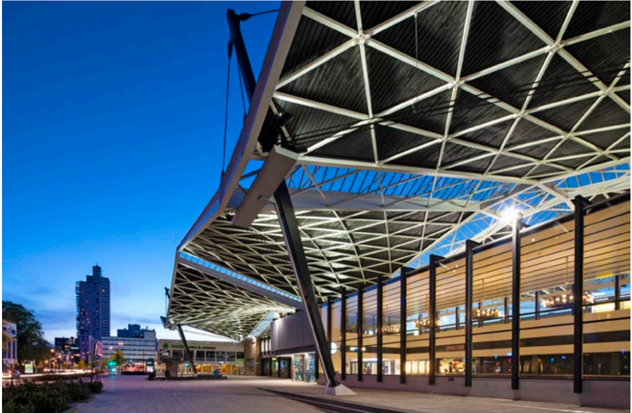
Station Tilburg in de avond, na het plaatsen van de architectonische verlichting (48 spots) (lichtontwerpers Atelier LEK / fotograaf Frank Hanswijk).
