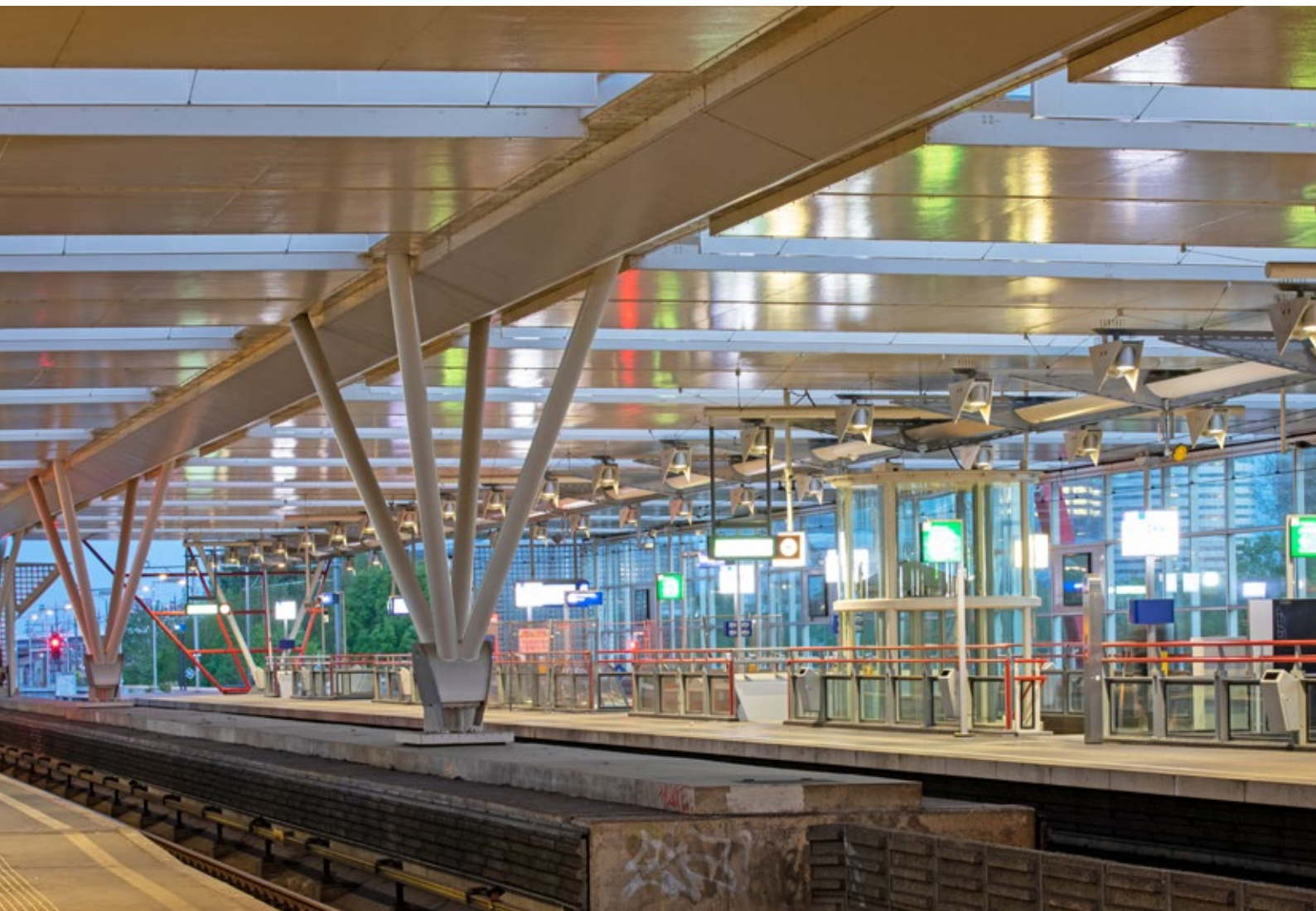
De spots tussen de driehoeken zijn omgebouwd met een nieuw led binnenwerk.
