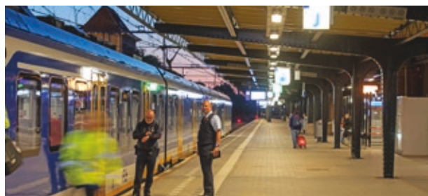
Het perron in Deventer na de vervanging.
