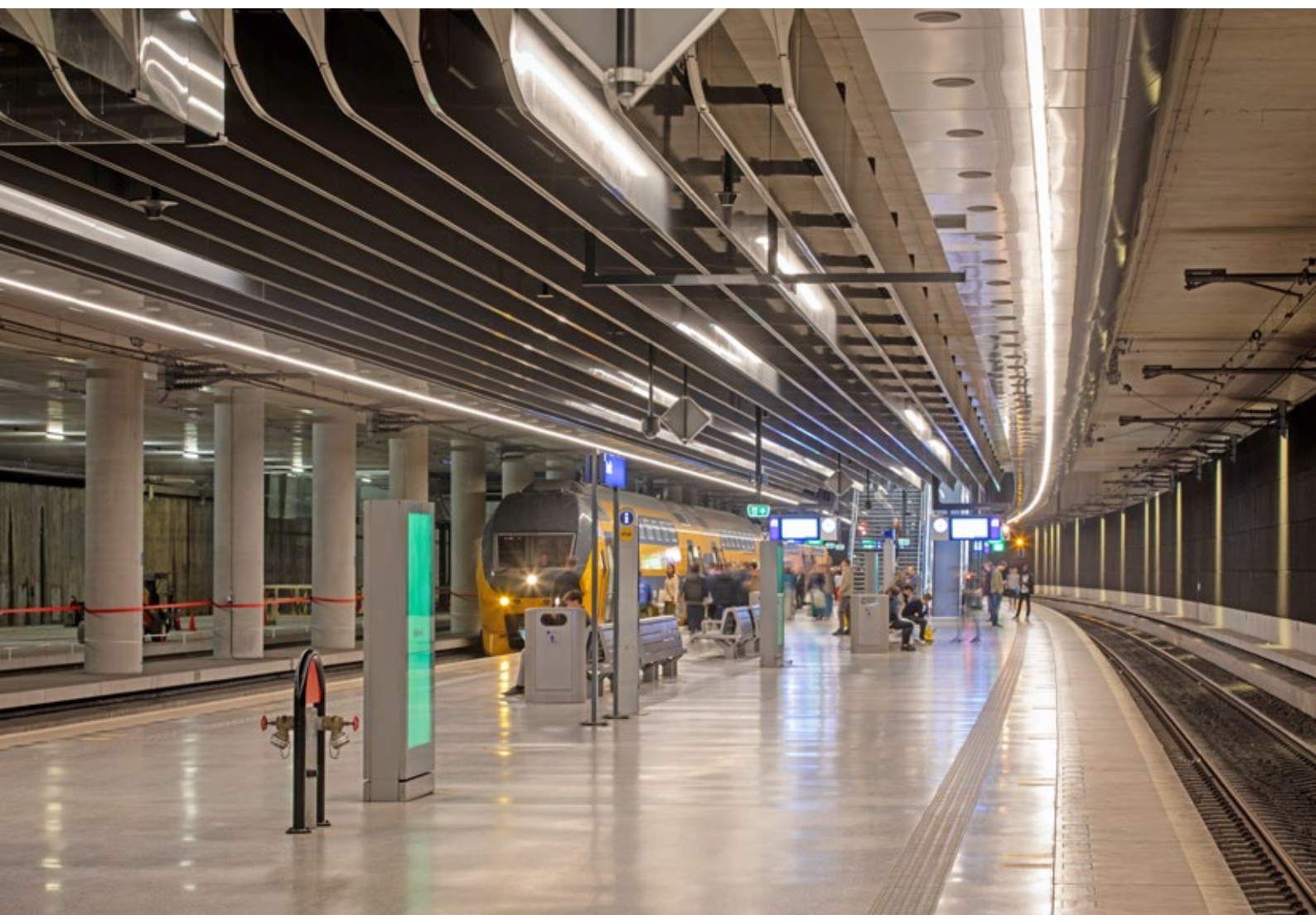
Ledverlichting op het perron van station Delft
