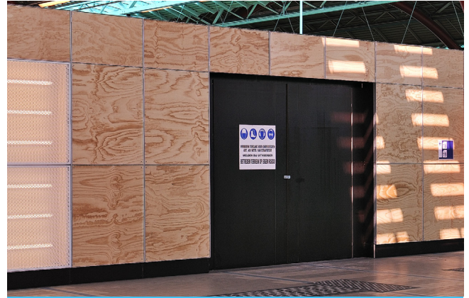
FACILITAIR LAAG | toegangsdeur in nis
