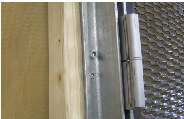
4. Detail van een scharnier op een vurenhouten stijl.
