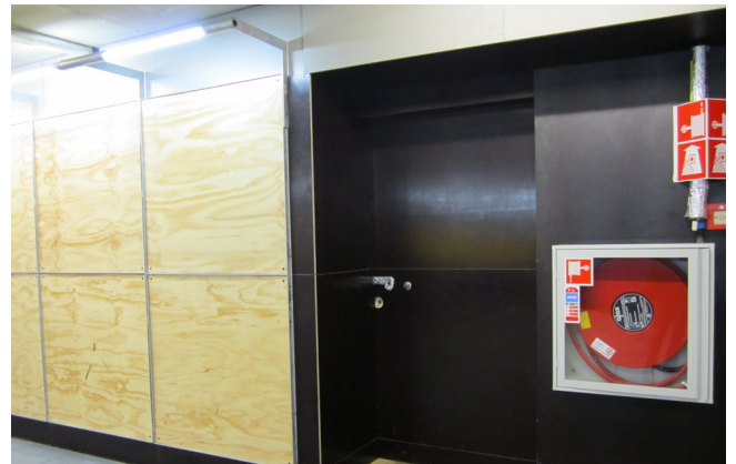
2. Betonplex passtuk, Amsterdam Centraal Station.
