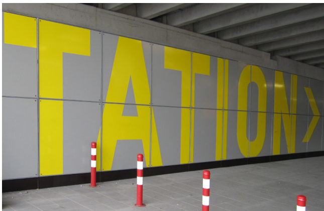
1. Toepassing direct tegen een betonnen wand op Amsterdam Centraal.
