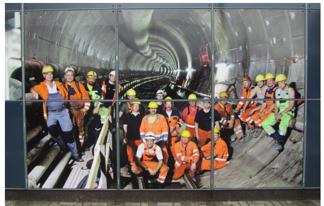
2. Voorbeeld van een gepoedercoat zincor paneel, deels voorzien van een grafische laag (in dit geval een foto).
