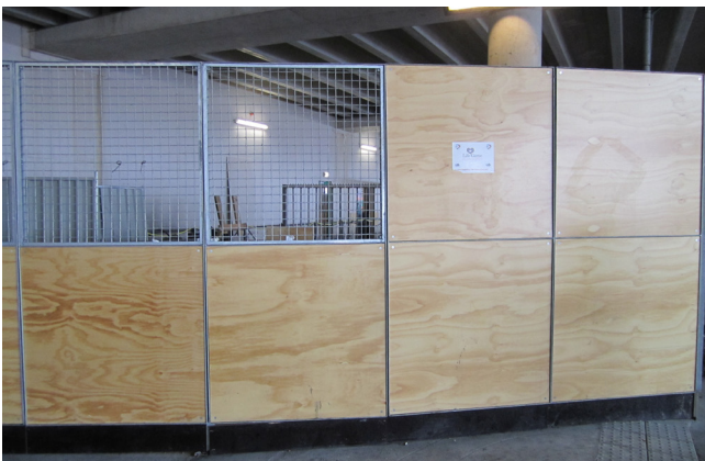
1. Voorbeeld van een arauco-paneel, gefreest en tweezijdig gelakt. Daarboven een verzinkt gaasframe.
