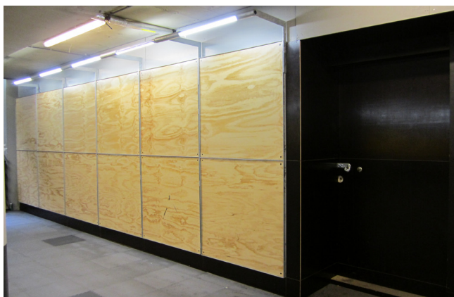
4. Toepassing van TL-verlichting met kabelgoot, Utrecht Centraal Station.
