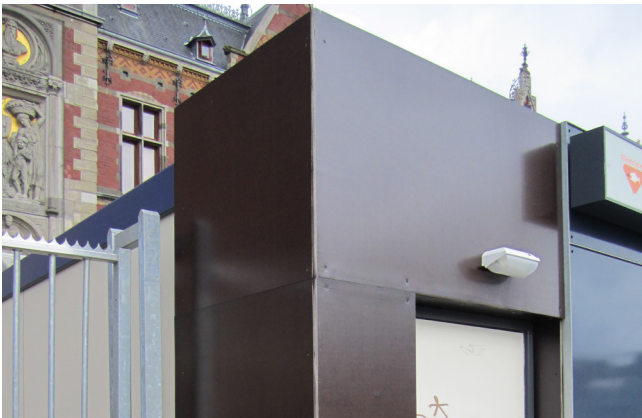
1. Betonplex passtuk, Amsterdam Centraal Station.
