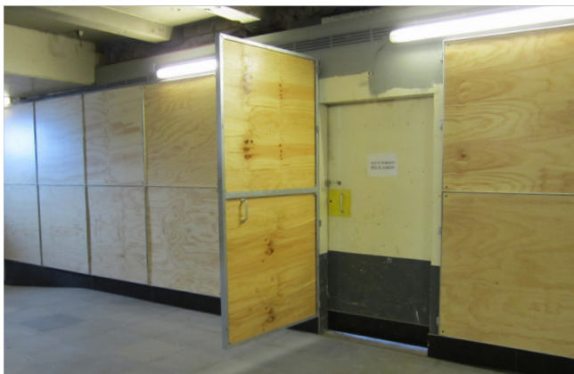
1. Toepassing van een deur in een frame, ten behoeve van een doorgang op Amsterdam Centraal.
