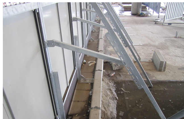
3. Toepassing op ongelijke vloer. Amsterdam Centraal Station.
