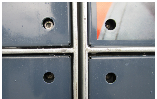
5. Detail van een gepoedercoat zincor paneel, deel voorzien van een grafische laag (in dit geval een foto).
