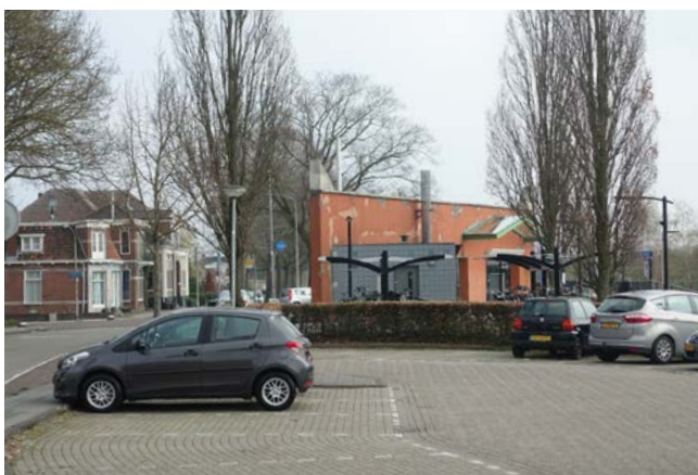
Aan de westzijde maakt de Stationsweg (die parallel loopt aan het spoor) een bocht, waarbij de weg zich verder verwijderd van de spoorlijn, zodat er ruimte is voor het stationsgebouw. Zodra het gebouw wordt genaderd begeleidt de muur de reizigers weer terug richting de spoorlijn.
