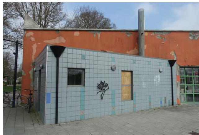
De achtergevel van het stationsgebouw. De raamopeningen zijn bescheiden en passen precies in het tegelpatroon van de gevelafwerking. Opvallend zijn de hemelwater afvoeren.
