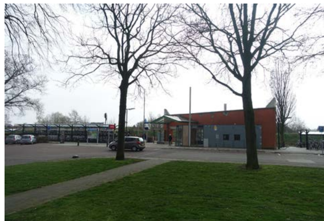
Vorgevel gezien vanaf het plantsoen bij het Joodse monument. Hier wordt duidelijk dat de muur de kant op wijst van de perrons en de treinen. Een ongelukkig geplaatste kaartenautomaat en de fietsenstalling blokkeren het beeld naar de perrons.
