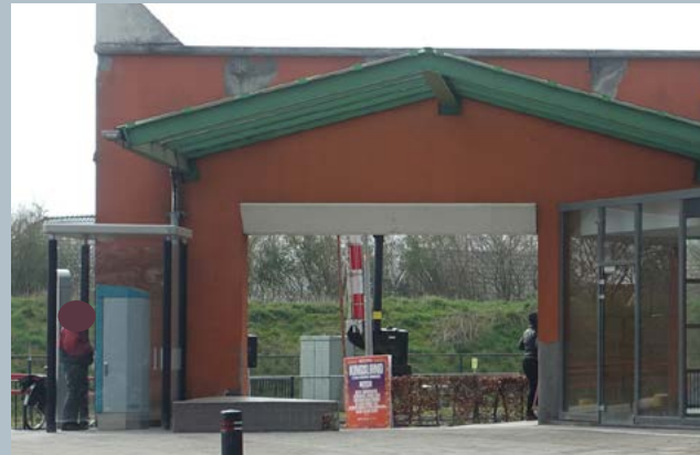
Aanpassingen in het ontwerp, zoals het plaatsen van een kaartautomaat op de plek van de zitplaatsen voor de reizigers.
