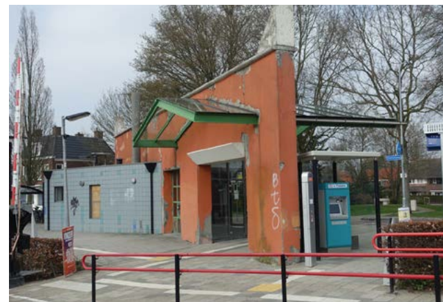
Achtergevel gezien vanaf het perron. Hier is duidelijk te zien dat de opening in de muur toegang geeft tot de spoorwegovergang (goed te zien aan de ribbeltegels ter geleiding van blinden en slechtzienden).
