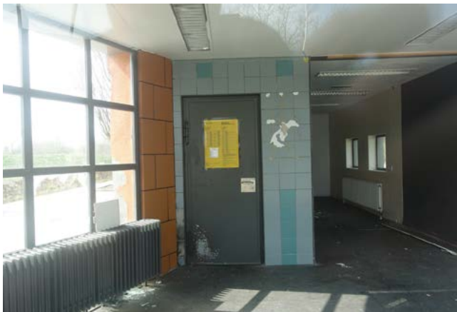
Wachruimte en de deur naar de CV ruimte. Rechts was voorheen de balie geïnstalleerd. Duidelijk zichtbaar: de originele tegels van de diagonale muur en de blauwe tegels die doorlopen van het exterieur naar het interieur.
