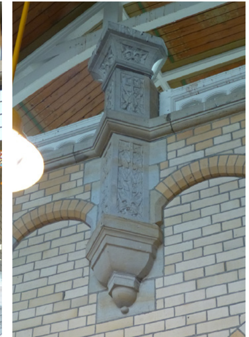
Decoratie van de stationsklok en console.
