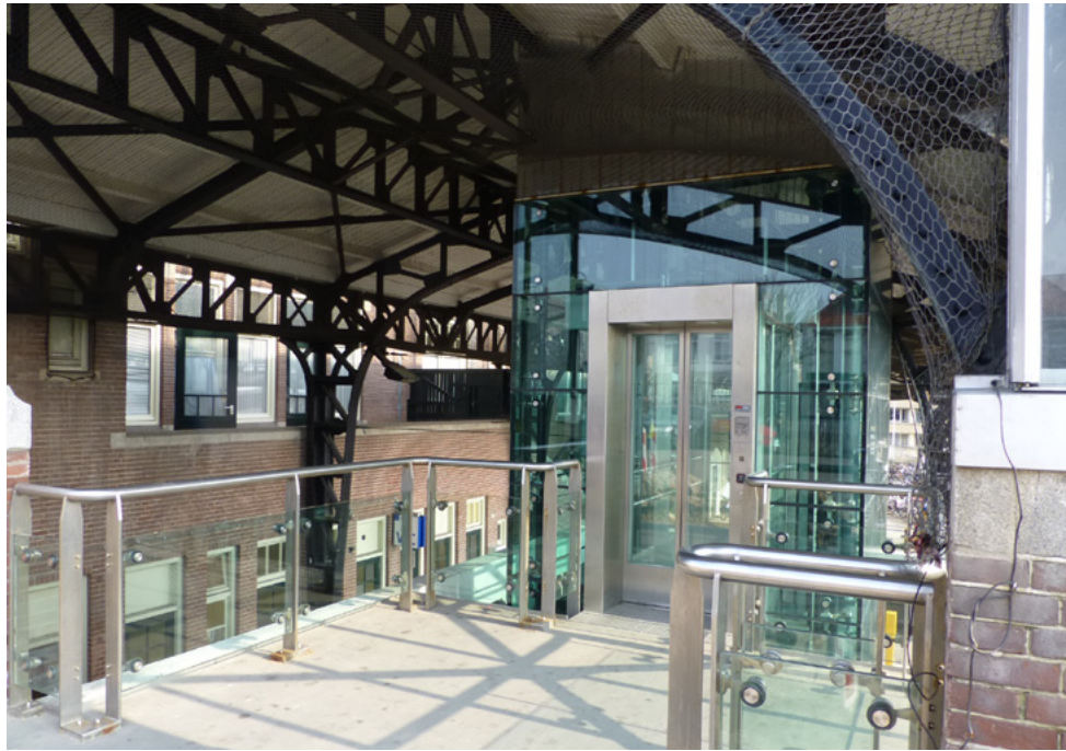
Toevoeging van moderne lift in de zuidkant van de perronkap.
