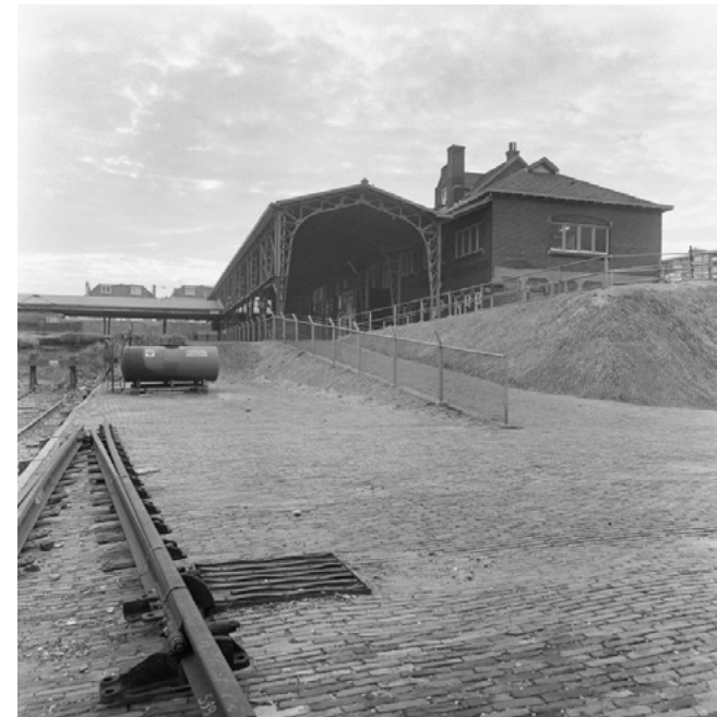
Noordkant van het station in 1974. [Stationsweb]
