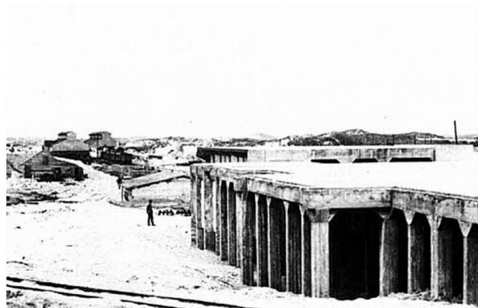
De funderingen van het nieuwe station te Zandvoort, 1908. Op de achtergrond is het oude station nog zichtbaar.
