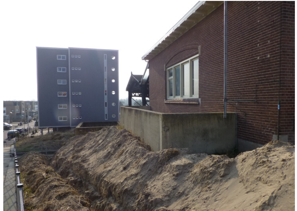
Noordkant van het station met detonerende aanbouwen.
