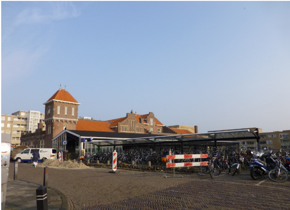
Zuidzijde van het station met nieuwe fietsenstalling.
