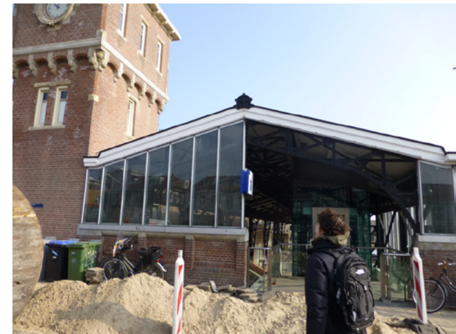
Enkel de perronkap parrallel aan het stationsgebouw is nog aanwezig.
