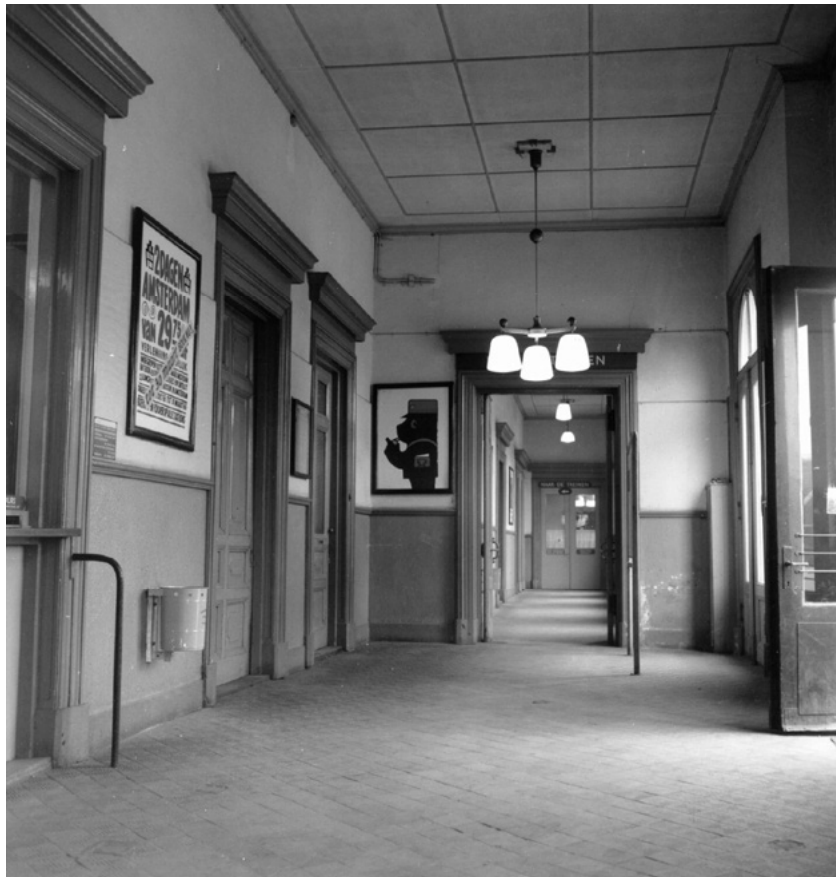
Afb. 2.3.13 Beeld van de vestibule en de gang in de noordvleugel, midden jaren '60. Rechts de hoofdentree, links de loketwand (vooraan), toegangsdeur naar kantoor stationschef (midden) en de deur naar het trappendeur en personeelentree naar het perron (achteraan). Midden op de foto de gang door de noordvleugel, met het deurstel dat zich tot op heden hier bevindt. In de gang aan de linkerzijde deuren naar de wachtkamer 1e/2e klasse en keuken. Aan het einde van de gang de deuren naar de voormalige wachtkamer 3e klasse. Het gebouw heeft geen tot zeer weinig modernisering ondergaan. Foto maart 1966.
