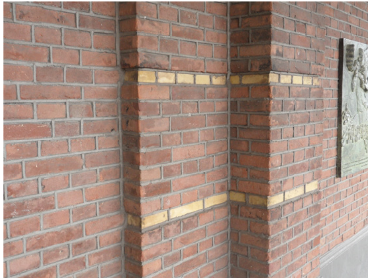
Afb. 5.2.13 De invallende sierbanden op de pilasters.
