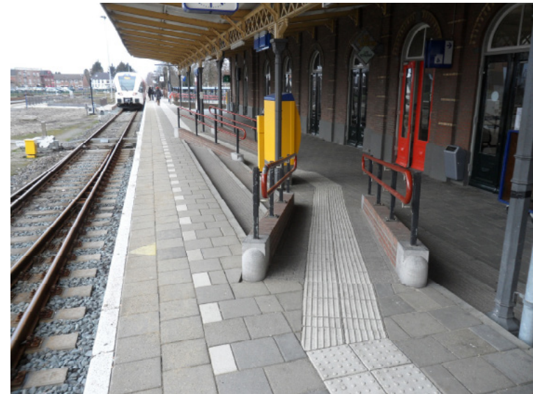
Foto 4 De recente hellingbaan op het perron, ter hoogte van het hoofdvolume. Goed zichtbaar is links het verhoogde actuele perron en rechts de lager gelegen historische perronhoogte.
