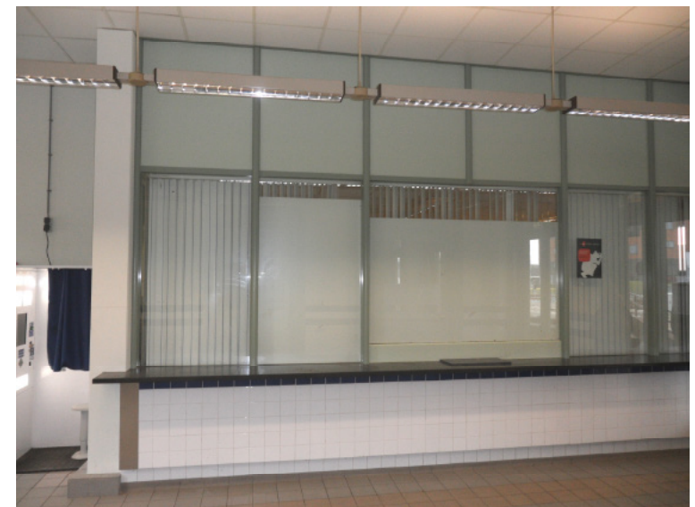
Afb. 2.3.15 De nieuwe loketwand aan de zuidzijde van de vestibule.
