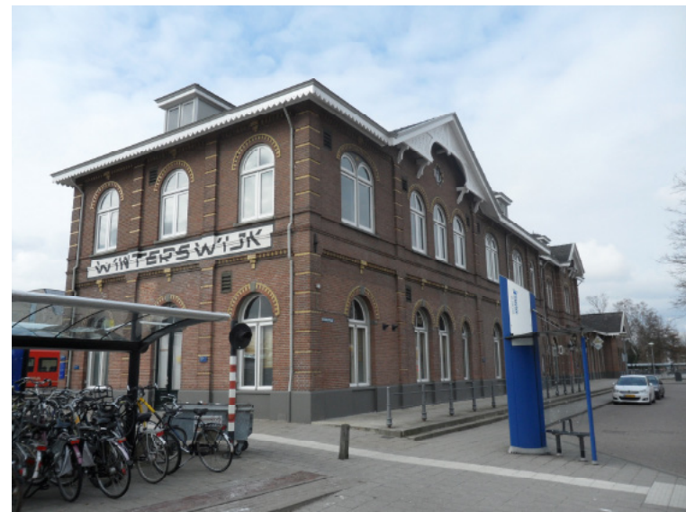
Afb. 5.2.8 Het voormalige GOLS-station, met omringend bedrijventerrein.
