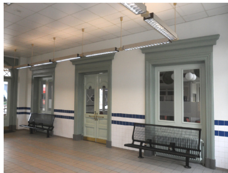
Afb. 5.3.9 De oude deurstellen herplaats als entree naar de stationsrestaurant. Ook hier staan zitbanken voor de deuren. De in vormgeving afwijkende entreeduren (midden) zijn niet te herleiden op de bestekstekeningen.
