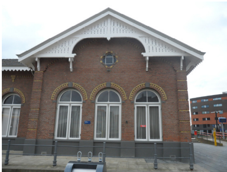
Afb. 5.2.14 De topgevel van de perronvleugel aan de straatzijde.
