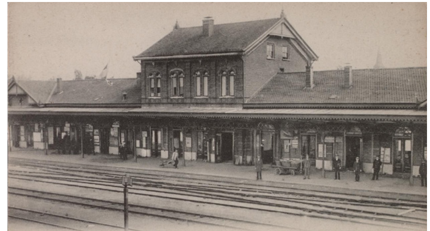
Afb. 2.3.4 De perrongevel met de perronkap, rond 1905. Het plaatskaartenkantoor heeft nog de vlakke perrongevel. In de topgevel van de dienstwoning zijn de twee ramen zichtbaar.
