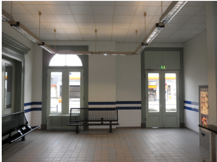
Afb. 5.3.8 De vestibule gezien vanaf de perron- naar de straatzijde. Rechts de hoofdentree, zonder bovenraam. Een zitbank is half voor het linker oude deurstel geplaatst.
