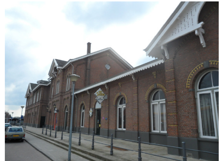
Afb. 5.2.4 De voorgevel gezien vanaf de noordoostzijde. Op de voorgrond de noordvleugel, daarna het hoofdvolume en achteraan de hoge zuidvleugel.
