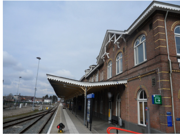
Afb. 5.2.6 De perrongevel vanaf de zuidzijde. De perronkap heeft de oude lengte.
