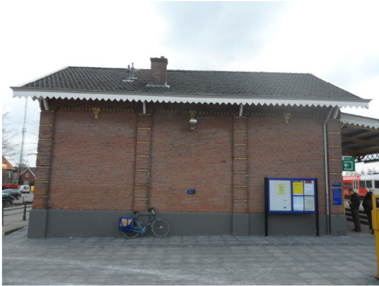
Afb. 5.2.5 De noordgevel van het station.
