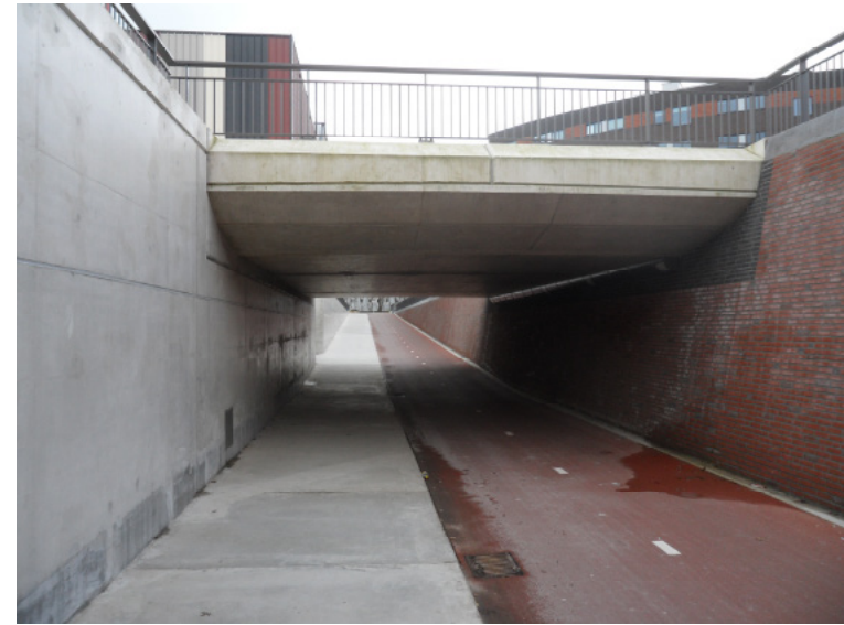
Foto 7 De langzaam-verkeerstunnel, vanaf de centrumzijde.
