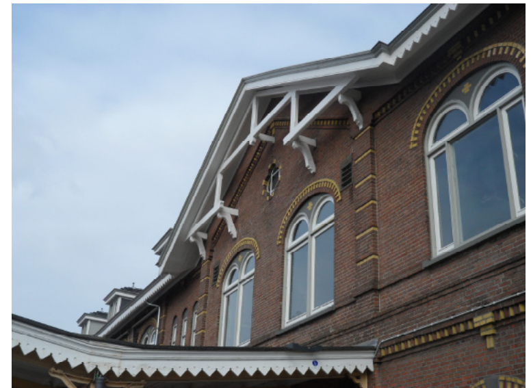
Afb. 5.2.16 De topgevel van de zuidvleugel aan de perronzijde.
