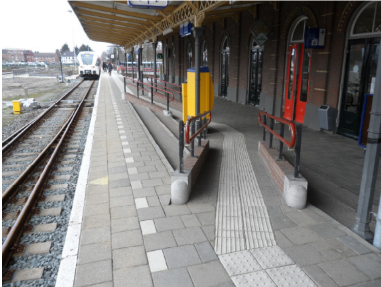
Afb. 5.2.17 De entree naar de vestibule vanaf het perron.
