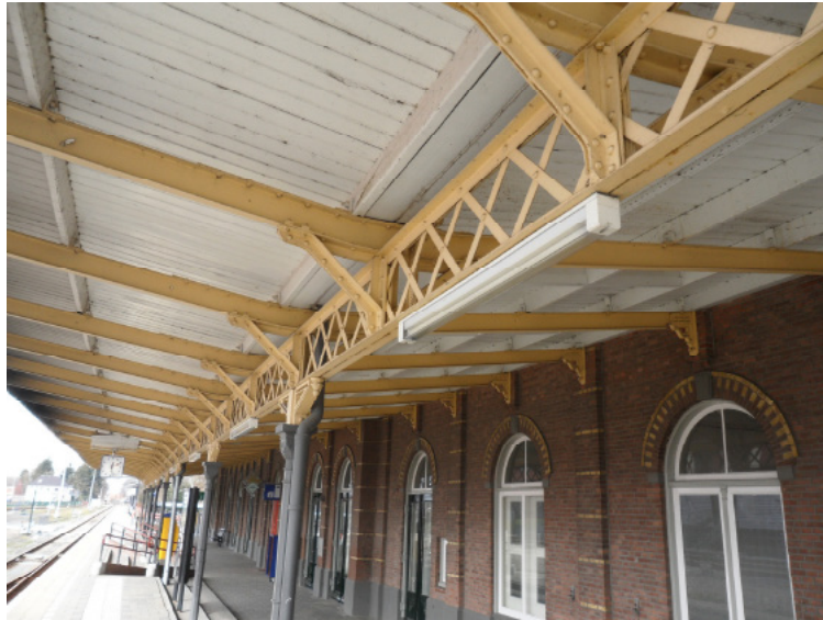
Foto 5 De historische perronkap aan het NWS-stationsgebouw.
