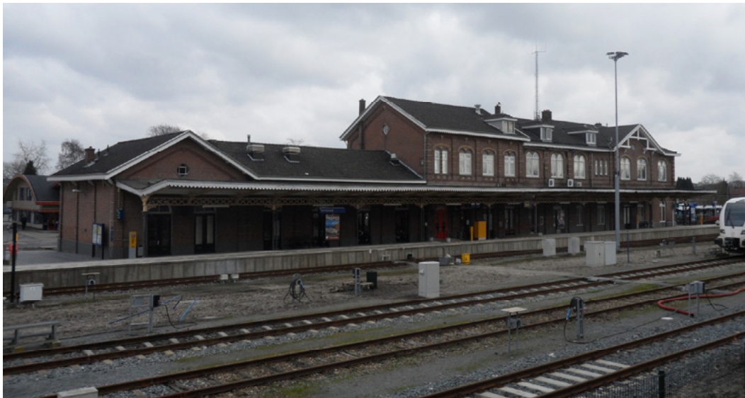
Afb. 5.2.7 De perrongevel uit het noordwesten.
