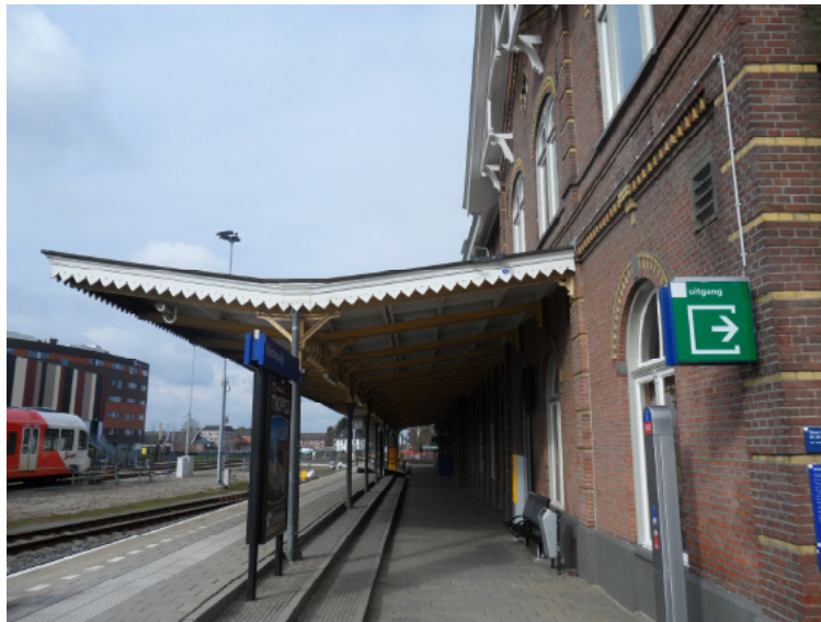
Afb. 5.2.19 De zuidelijke beëindiging van de perronkap.
