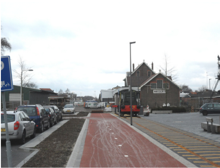
Foto 12 Het terrein rond het GOLS-station, met kleine industrie en parkeerplaatsen.
