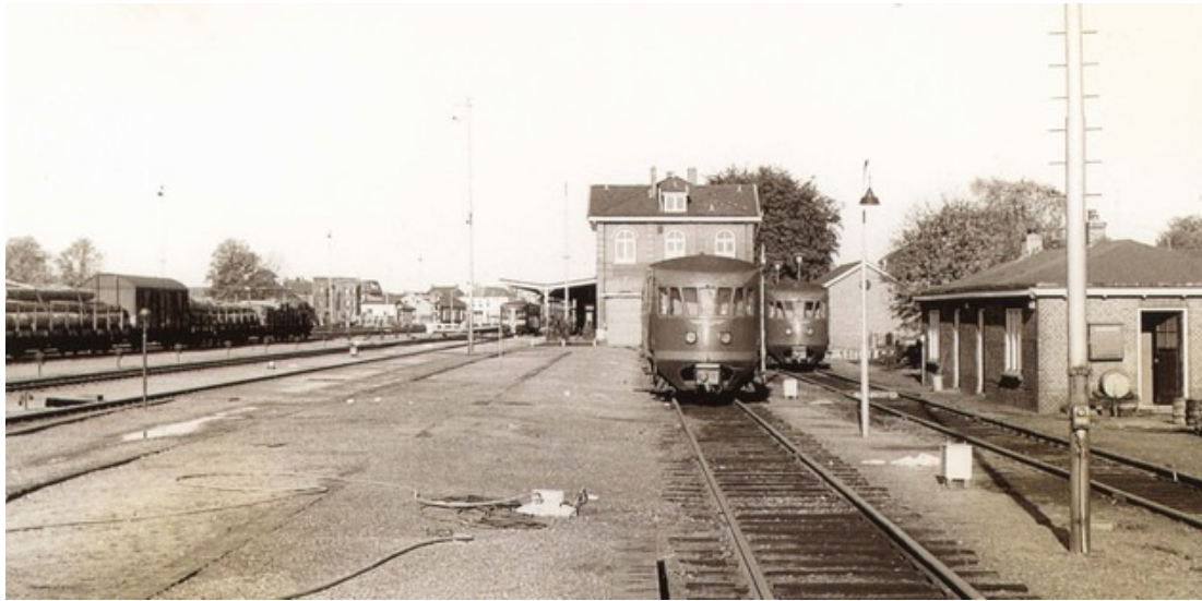
Afb. 4.2.5 Het emplacement aan de zuidzijde van het stationsgebouw (middenvoor) in 1962. Tussen het treinstel en het station is de zuidgevel van de nieuwe rijwielstalling zichtbaar. Het zuidelijke eilandperron is verwijderd (links naast de goederentrein). Rechts staat de Lampisterie.
