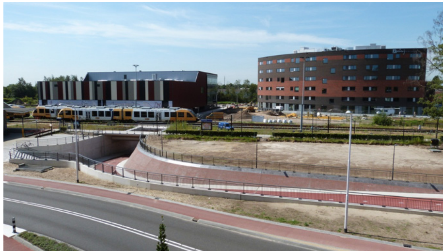
Foto 11 De nieuwe Sport- en turnhal (links) en scholengemeenschap (rechts) op het GOLs-emplacment, met op de voorgrond de tunnel voor langzaam verkeer. Gezien vanuit het Gemeentehuis. Foto zomer 2012. Bron: www.keypointconsultancy.nl
