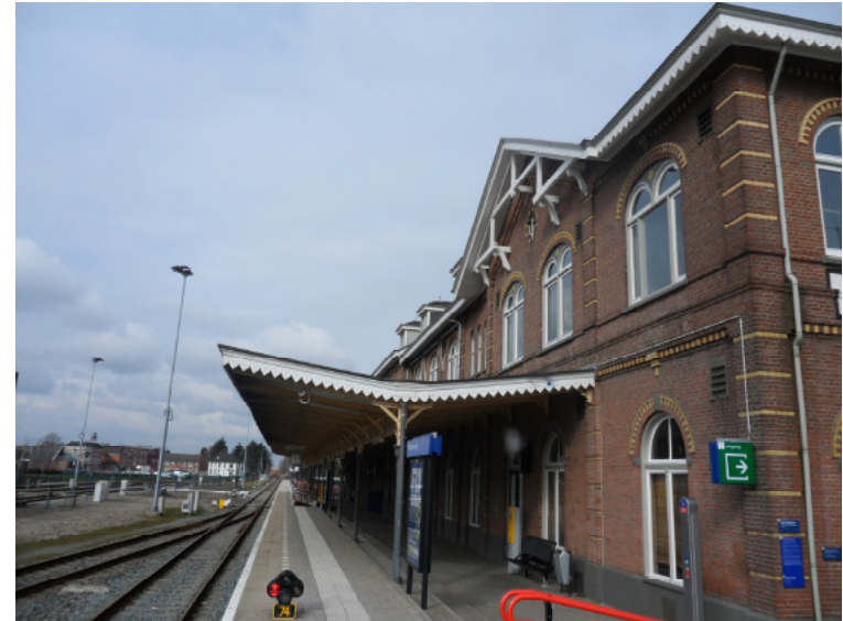
Foto 3 De perronzijde van het station, met perronkap, vanuit het zuidoosten.
