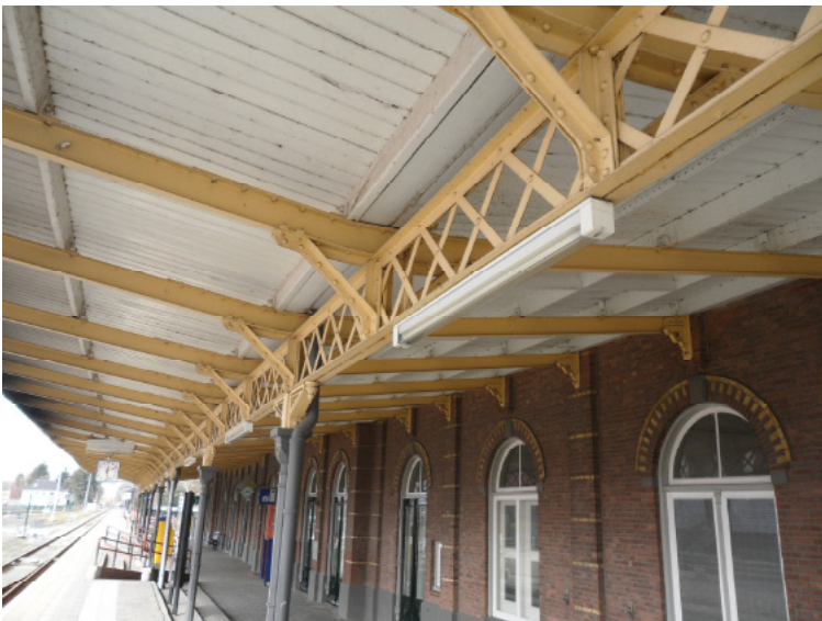
Afb. 5.2.18 De draagconstructie onder de perronkap.
