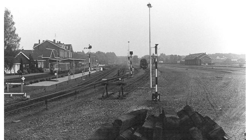
Afb. 4.2.9 Het emplacement vanuit het noorden in 1978. Rechts is goed zichtbaar hoever de sporen op het rangeerterrein reeds zijn opgeruimd. Rechtsachter de goederenloods en op de voorgrond een stapel spoorbiels.
