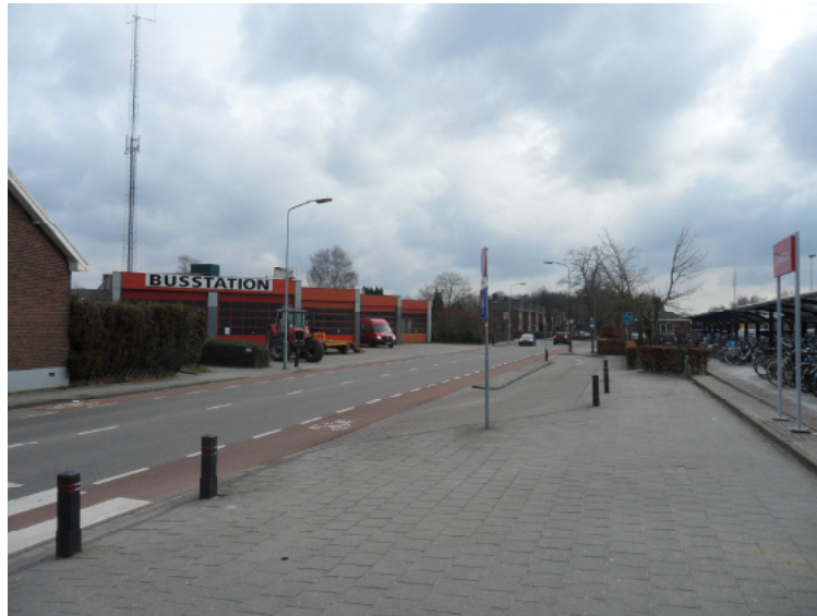
Foto 1 De overgang Stationsstraat/ Kleine Parallelweg, gezien naar het zuiden. Rechts ligt het emplacement. Links het (oude) busstation van de Gelderse Tram.
