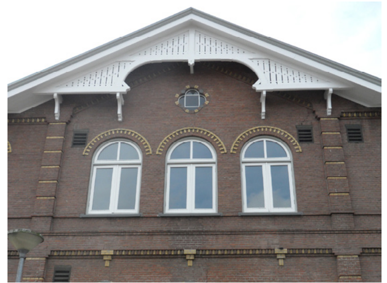
Afb. 5.2.15 De topgevel van de zuidvleugel aan de straatzijde.
