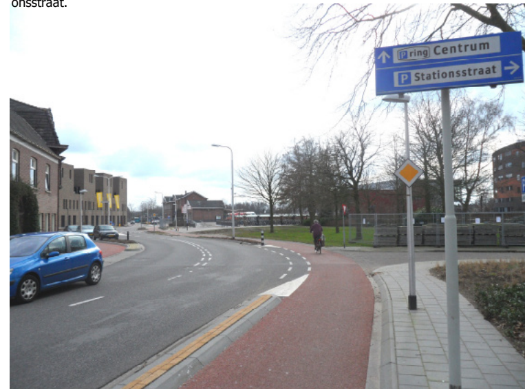
Foto 15 De Stationsstraat vanaf de Misterweg naar het station gezien. Het parkje rechts-midden is vanaf de bouw van het station in 1880 als park in gebruik. Recent is het sterk verkleind voor de aanleg van een parkeerplaats en voor de entree naar de langzaam-verkeertunnel.
