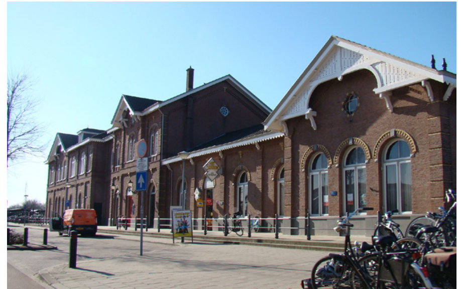
De voorgevel van station Winterswijk, op de voorgrond de noordvleugel en hoofdvolume uit 1879, op de achtergrond de hoge zuidvleugel uit 1916.
