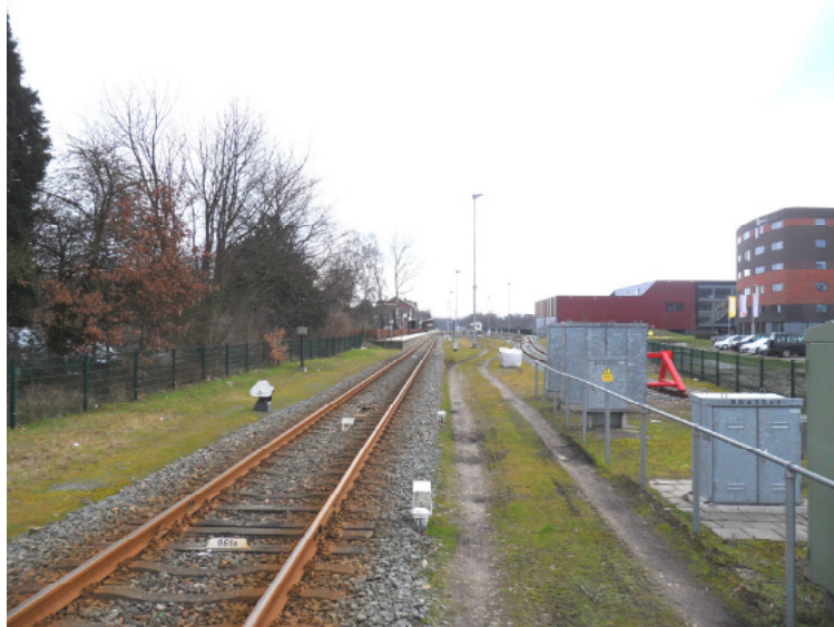
Foto 16 Zicht vanaf de spoorovergang Misterweg naar het stationscomplex, met rechts de nieuwe stedelijke bebouwing en linksachter het NWS-stationsgebouw.
