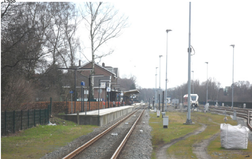
Afb. 4.3.1 Het huidige emplacement, gezien vanaf de noordelijke spoorkruising. Rechtsvoor is een opgebroken spoor herkenbaar, dat langs het verwijderde eilandperron liep. Op de locatie van het eilandperron staan nu hoge lichtmasten.
