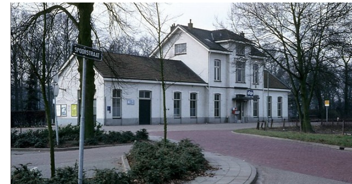
Afb. 2.3.4 Station Ruurlo. Foto P. van Baarle 24-02-1980
