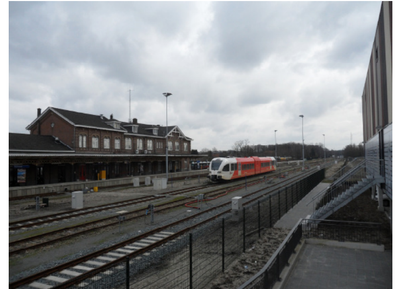
Foto 15 Het emplacement gezien naar het zuidoosten, vanaf de nieuwe sporthal (rechts).
