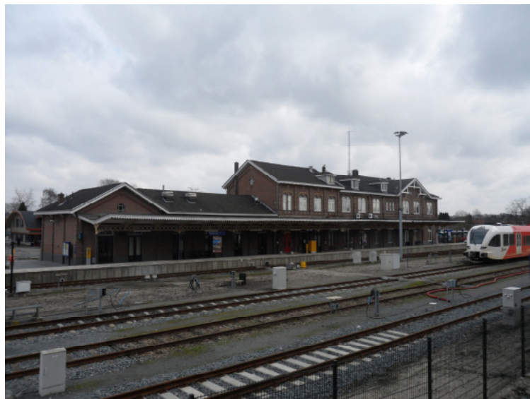
Foto 6 Overzicht van de spoorzijde van het NWS-station met perronkap, gezien vanaf de nieuwe sporthal.
