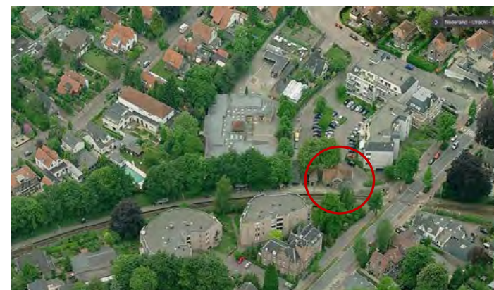
Overzicht station Soestdijk, Luchtfoto, voormalig stationsgebouw omcirkeld (Bingmaps 2016)
