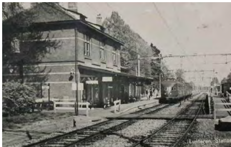
Afb. 4.2 Het emplacement in circa 1950. Het emplacement heeft een dubbel spoor, met aan weerszijden een perron. Coll. W. Bramer.
