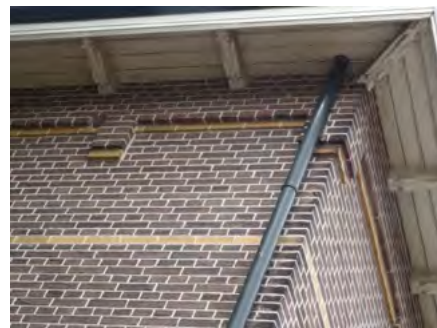
Afb. 5.10 De uitkragende sierlijst langs de dakrand, met geelstenen bias.
