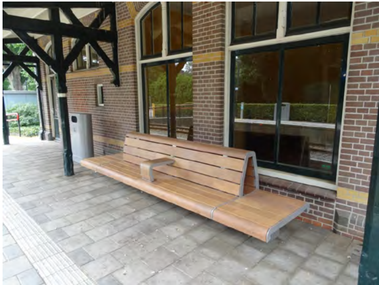
Afb. 2.6 De vensters op gemetselde plint, op de plaats van de dubbele deurstellen van de wachtkamer 2e Klasse.
