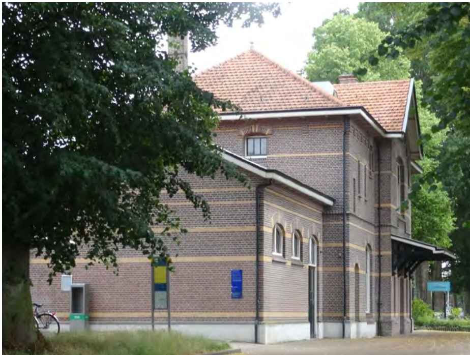
Afb. 5.8 Het schild- en zadeldak zijn beiden voorzien van rode Hollandse pannen en een doorlopende daklijst. Aan de voorzijde loopt het schilddak door in de steekkap boven de middenrisaliet. De muren zijn gedecoreerd met banden van gele baksteen. De banden zijn veelal gekoppeld aan architectonische hoofdpunten van de deur- en raamopeningen.
