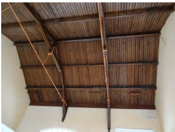
Afb. 5.27 De goederenloods, met de originele houten kapconstructie met trekstangen.
