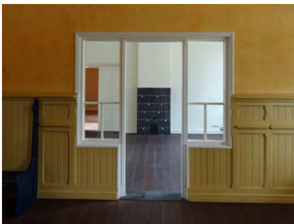
Afb. 5.22 Doorzicht van de wachtkamer naar het Bureau. De doorbraak is aangebracht in 1959 als modern loket en bij restauratie afgewerkt in de bouwstijl van het pand. In het Bureau de jaren '50-afwerking van de haardpartij.
