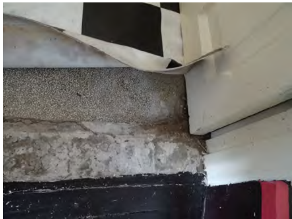
Afb. 5.29 De vloer van het toiletblok uit 1959; de dorpel en daarboven de originele terrazzovloer, met later opgebracht zeil.
