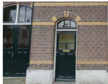
Afb. 5.16 De voordeur naar de dienstwoning. Links de dubbele deur naar de goederenvleugel
