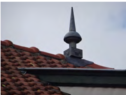
Afb. 5.9 De hoekpannen van het schilddak zijn gedecoreerd met een metalen piron.
