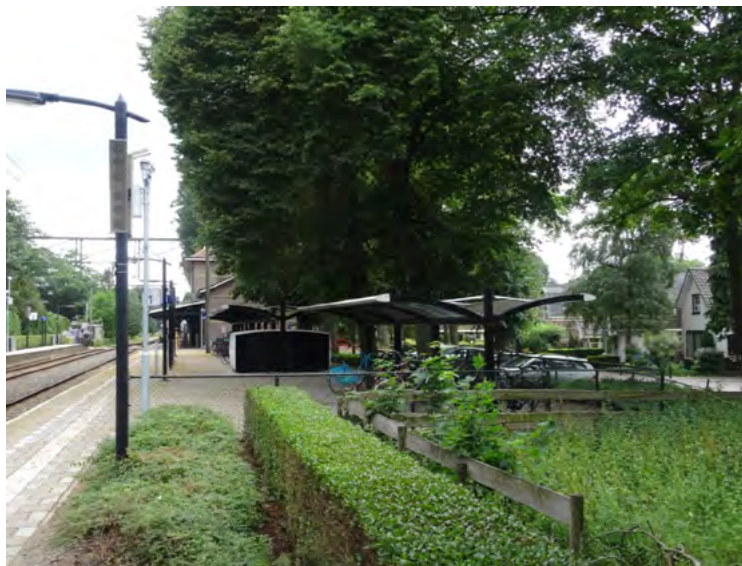
Afb. 4.13 De noordelijke fietsstalling, met overkapte fietsrekken en -kluizen.
