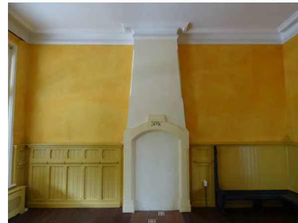
Afb. 5.21 De zuidwand van de wachtkamer (2e Klasse), met de originele lambrisering, ornamentele haardpartij en geprononceerde plafondblijst.
