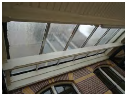
Afb. 5.15 De lichtstraat boven de locatie van de vroegere erker aan het plaatskaartenkantoor.
