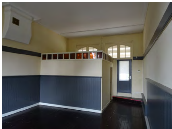
Afb. 5.19 De zuidelijke stationsruimte (wachtkamer 3e Klasse, later fietsenstalling), met het in 1959 ingebouwde toiletblok. Daarnaast de deur naar het perron. Links de afgekapte haardpartij uit de wachtkamerperiode.
