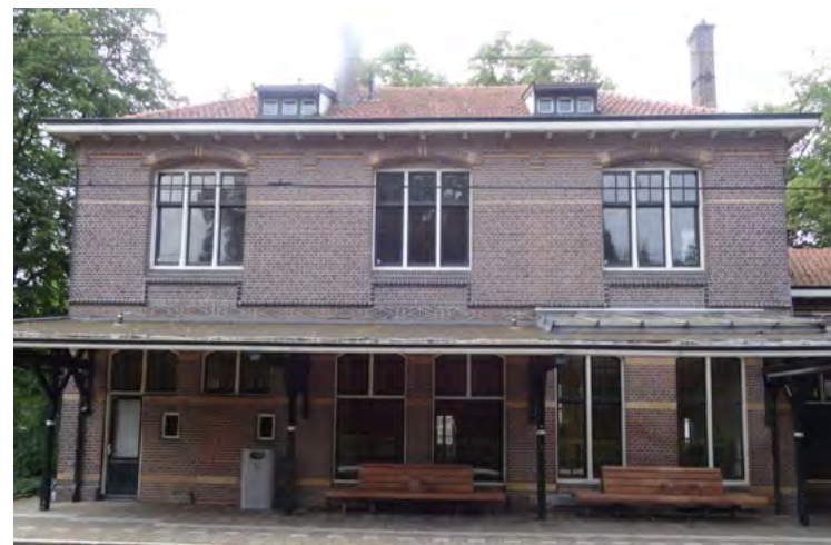
Afb. 2.5 De perrongevel van het hoofdvolume in de actuele situatie. Links de half dichtgemetselde entree naar de fietsenstalling, dan een dichtgemetselde deurpartij hoogte van het toiletblok. Daarna de twee vensters van de wachtkamer en de twee vensters van het plaatskaartenkantoor,
