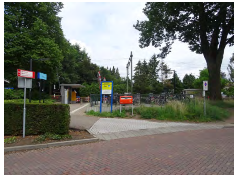
Afb. 4.12 De zuidelijke entree tot het stationsplein. Daarachter de zuidelijke, omheinde fietsenstalling op de plek van de Leidseabri.
