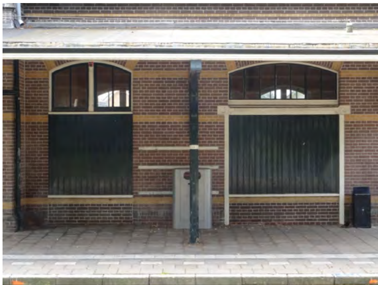
Afb. 2.7 De (sier)luiken op gemetselde plint, op de plaats van de perrontrees van bagagedepot (links) en goederenloods (rechts).
