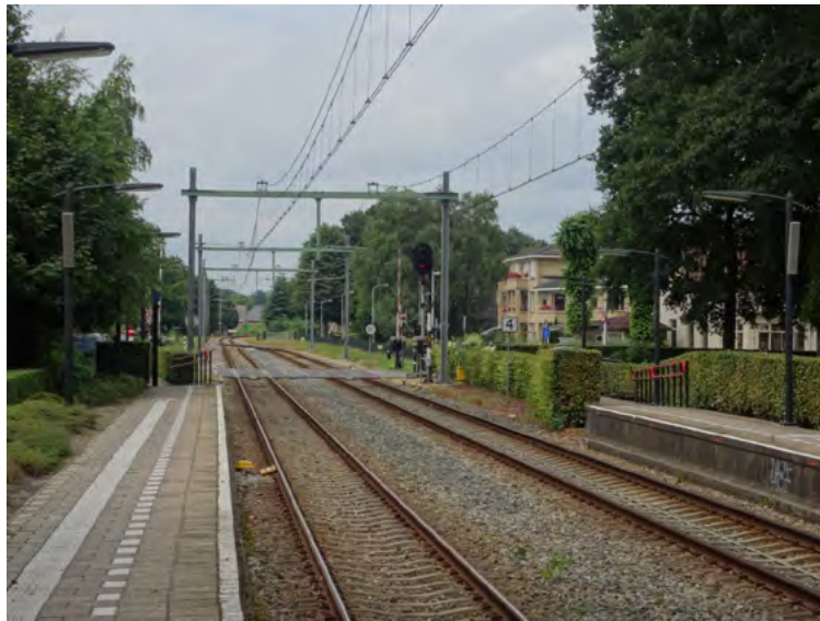
Afb. 4.9 De reizigersoversteekplaats aan de noordzijde van de perrons. Hier is ook een wandelpad richting de Engweg.
