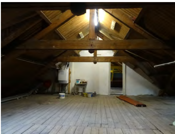
Afb. 5.28 De originele kapconstructie op de zolder van de dienstwoning.
