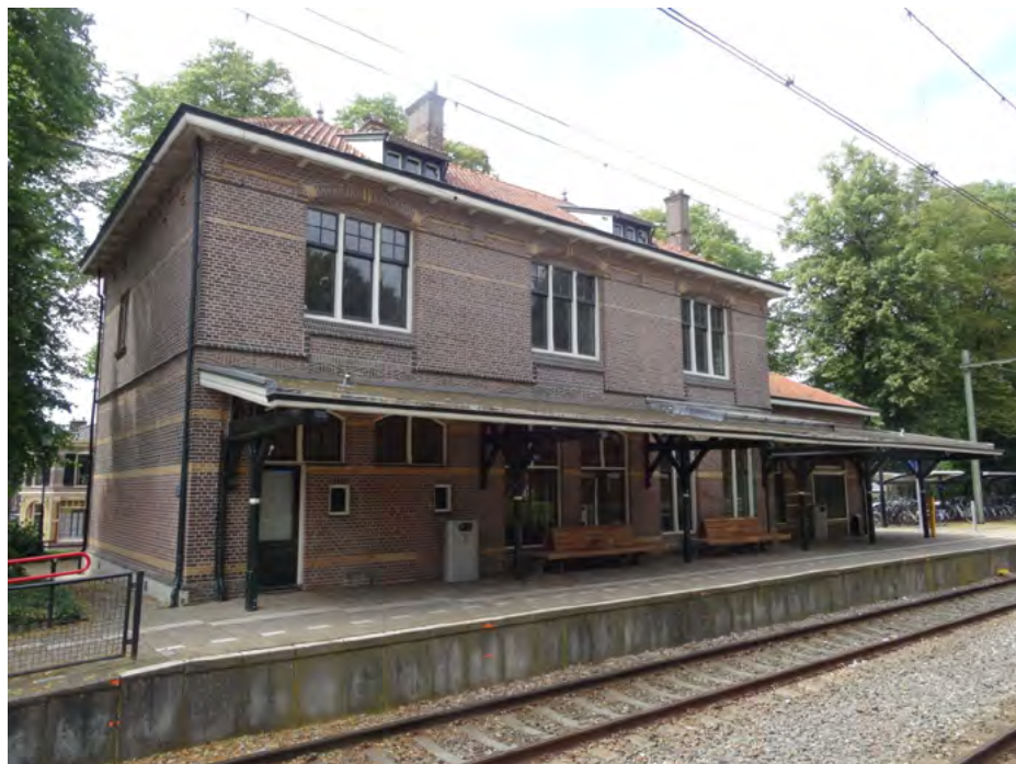
Afb. 5.13 De spoorzijde van het station met de perronkap over de volle breedte van hoofdgebouw en goederenvleugel.
