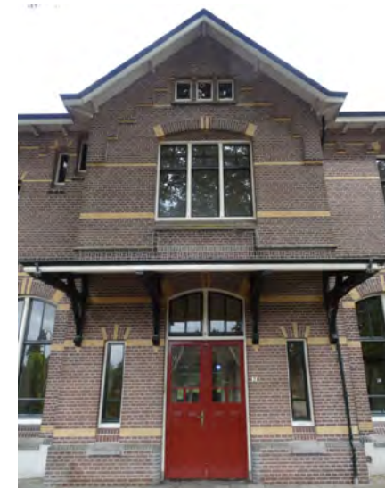
Afb. 5.17 De middenrisaliet in de voorgevel met de hoofdentree met dubbele deur.
