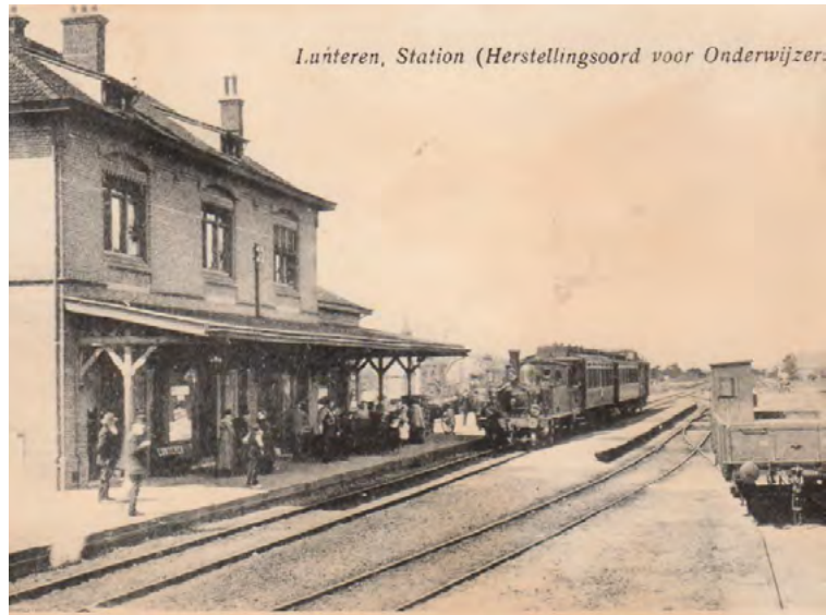
Afb. 4.1 Het eenvoudige emplacement in circa 1910. Het emplacement bestond uit een doorgaand spoor en enkele opstelsporen. Behalve het stations- en retiradegebouw waren geen andere spoorgebouwen of installaties aanwezig. Coll. J. Siepel.
