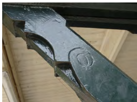
Afb. 5.14 Detail van het snijwerk aan de draagconstructie.
