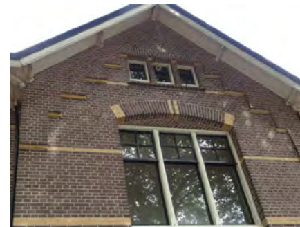
Afb. 5.11 De sierlijst van uitkragend metselwerk is doorgezet in de topgevel van de middenrisaliet.
