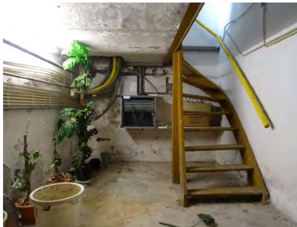
Afb. 5.30 De kelder met troggewelfjes, onder de entree tot de dienstwoning, doorlopend onder de vestibule.
