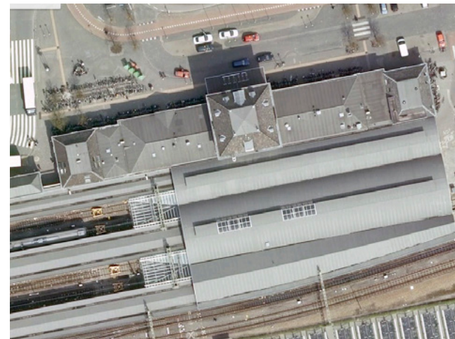
Kapvormen van het stationsgebouw. [Google]
