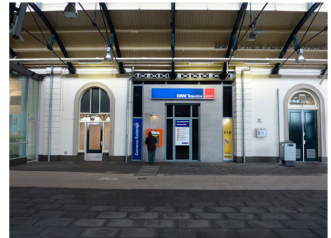
Achterzijde GWK bij de oostvleugel.
