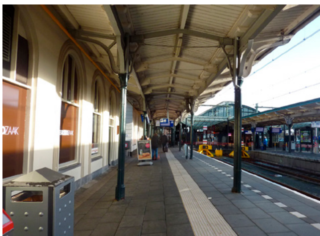
Verhoogd 1ste perron (zichtbaar aan het langzaam verdwijnen van het basement van de kolommen.
