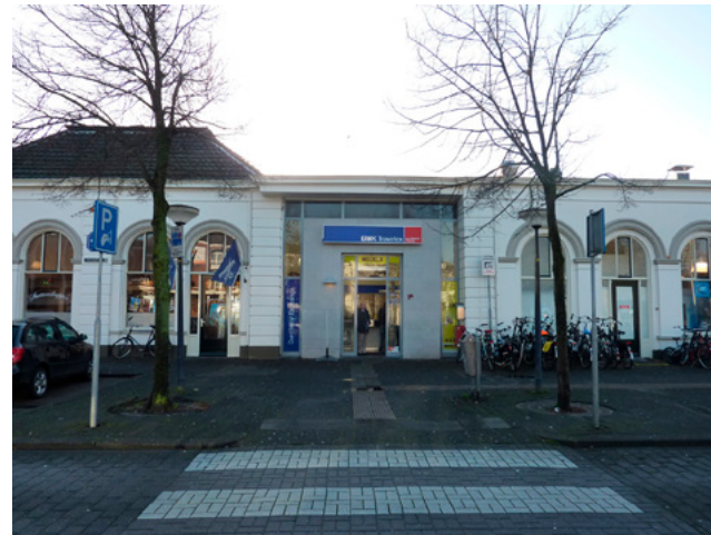
Entree GWK in de oostvleugel van het stationsgebouw.
