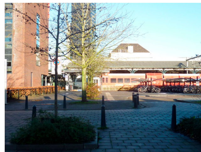
Zuidzijde van het station. Op de achtergrond het station met perronkap en de toegang tot de voetgangerstunnel. Links de onbewaakte rijwielstalling en een parkeerplaats.
