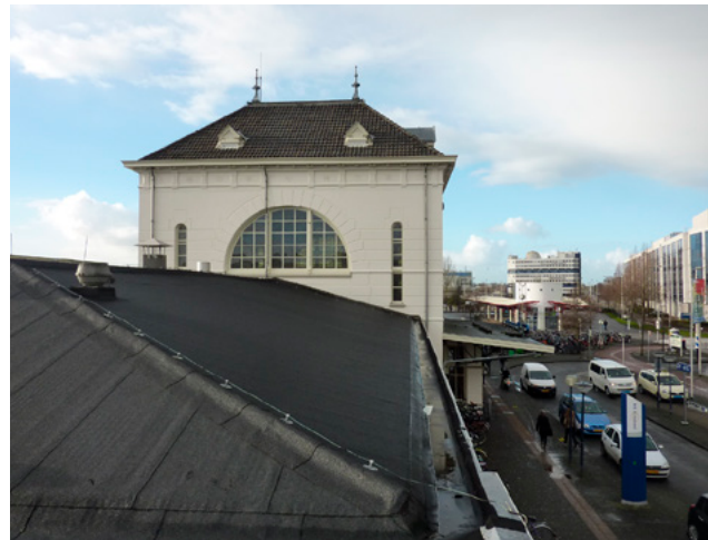
Dakkap oostvleugel bekleed met bitumen.
