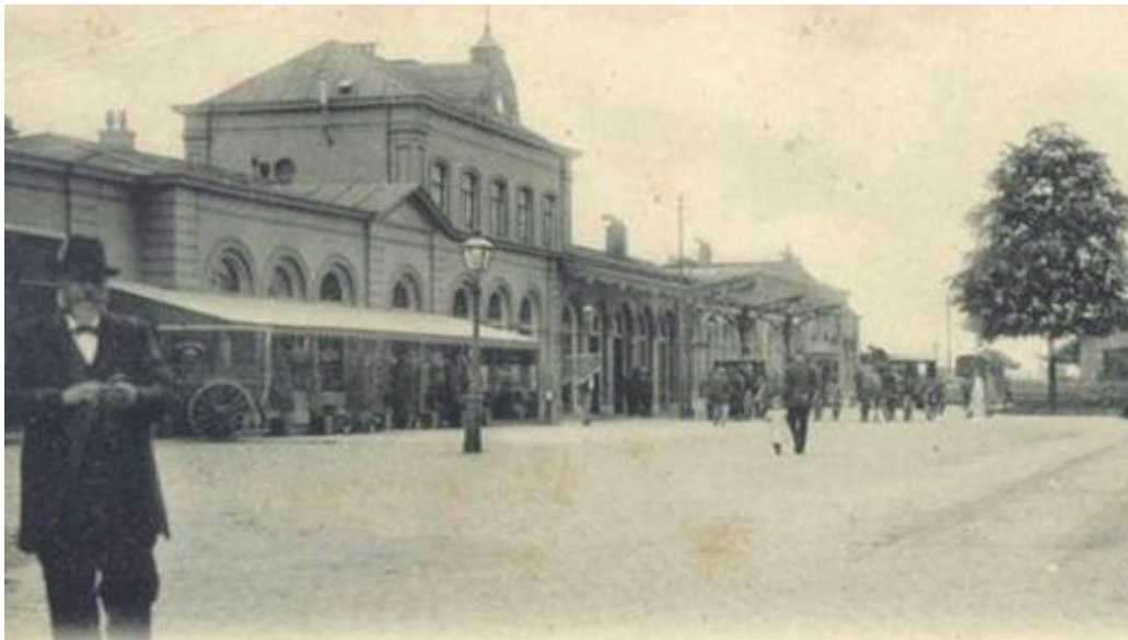
Zicht op het station, 1900. [Stationsweb]
