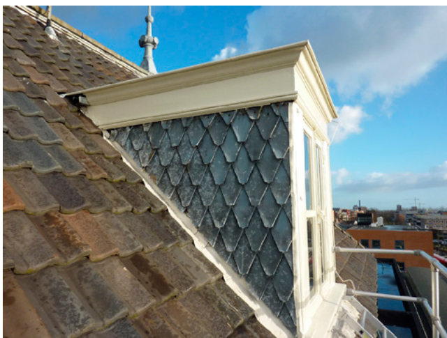
Oorspronkelijke dakkapel middendeel stationsgebouw (met zinkbeplating).
