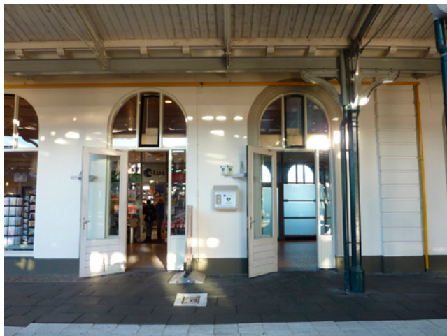
Achtergevel stationsgebouw te hoogte van de Etos.
