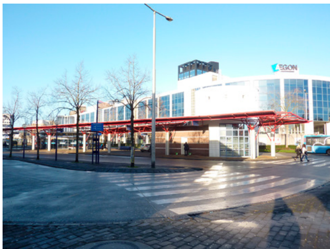
Bustation (ontwerper Chris Vegter ) aan de noordwestzijde van het stationsgebouw.
