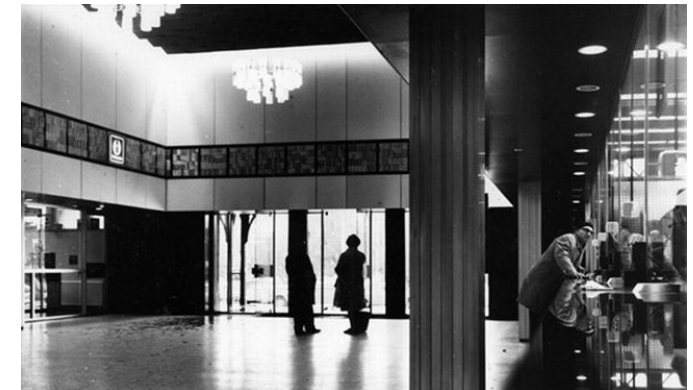
Afb. 4.52: De gemoderniseerde stationshal in de vestibule
