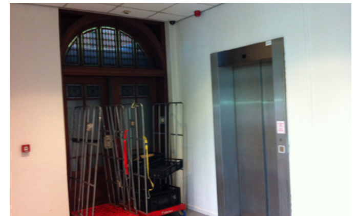
Afb. 4.59: De ruimte met de in 2000 nieuw gecreëerde toegangsdeur naar de vm wachtkamer 3e klasse is nu vanuit de voorkant alleen een (niet prettige) toegangsruimte naar de vm restauratie
