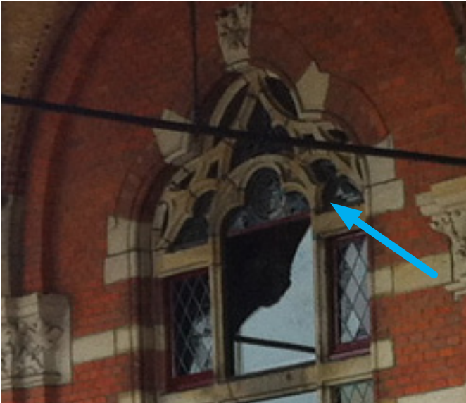
Afb. 4.39: Het glas-in-lood in de tracering van de restauratie in de oostelijke (reizigers)vleugel
