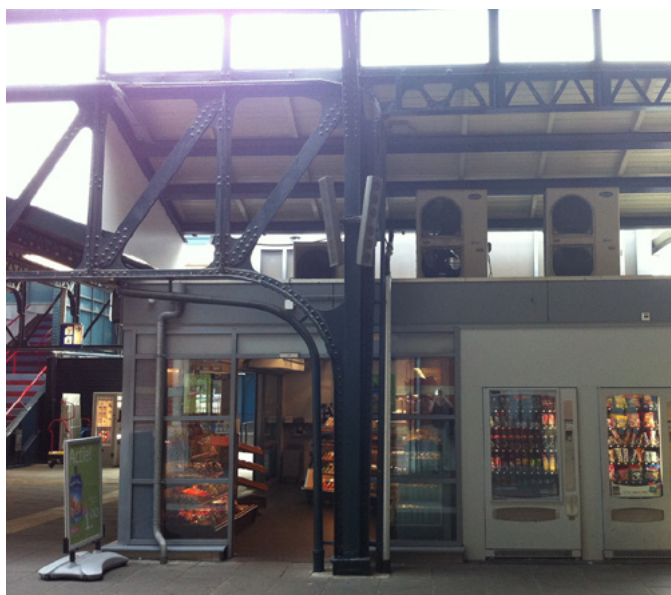
Afb. 4.86: De kiosk tussen de hoofdspanten
