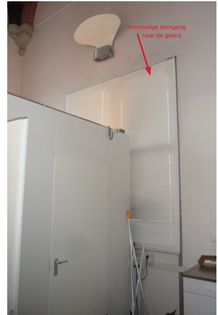
Afb. 4.61: Huidige inrichting oostelijk tochtportaal (opslagruimte)
