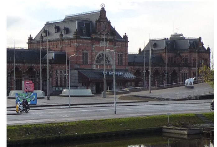
Afb. 1.4: Het stenen station van Isaac Gosschalk in 2012
