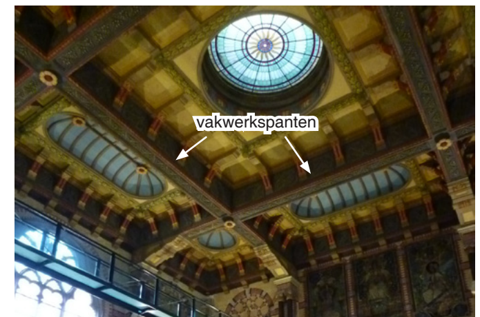
Afb. 4.43: De vestibule met de vakwerkspanten bedekt met papierstuc
