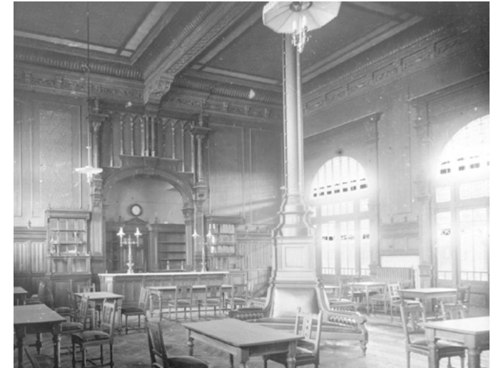
Afb. 4.42: De onderaan betimmerde kolom van kwadrant-ijzer
