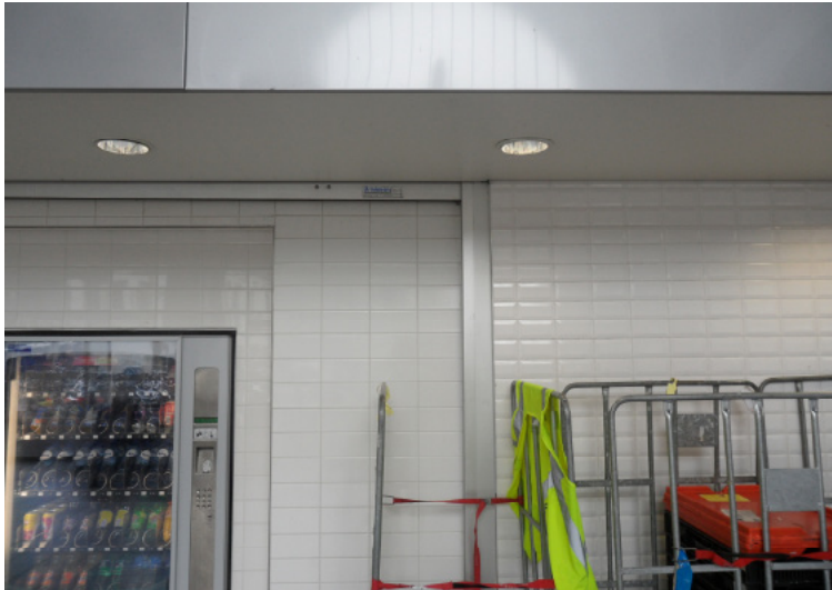
Afb. 5.6.3 Rechts het originele geprofileerde tegelwerk. Links vlak tegelwerk van een latere aanvulling.
