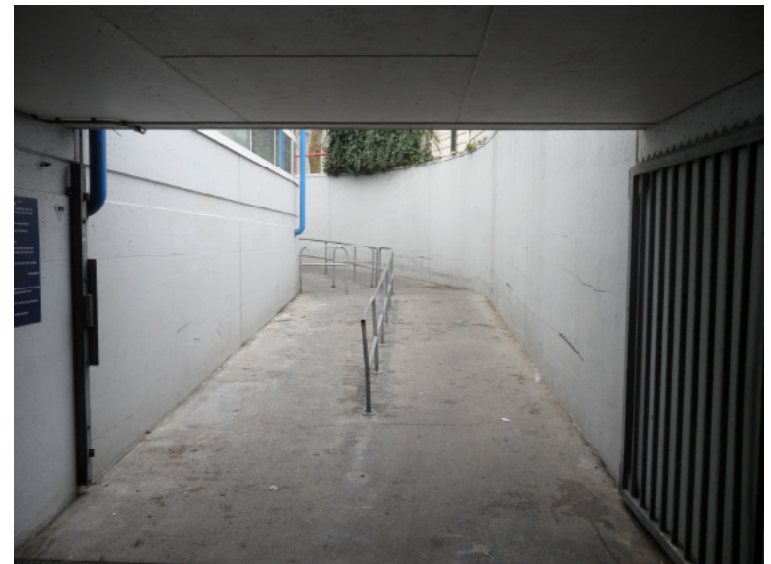
Afb. 5.5.5 De hellingbaan naar de westzijde van het station. Gezien vanuit de tunnelingang bij de fietsenkelder.
