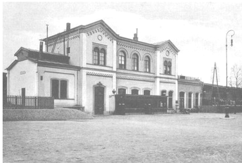
Afb. 2.3.3 Het stationsgebouw in circa 1915, met links de korte nieuwe vleugel op de plaats van de locomotiefloods. Voor het station staat een breed tochtportaal. Rechts staat de nieuwe vleugel met dakterras en aangrenzend de ingekorte goederenloods.
