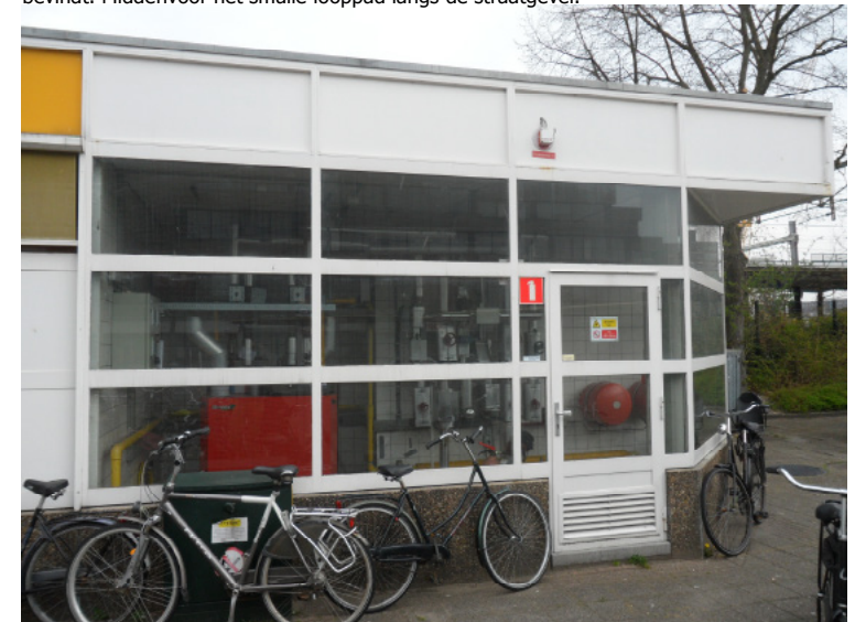
Afb. 5.5.12 De technische ruimten in de oostelijke aanbouw.
