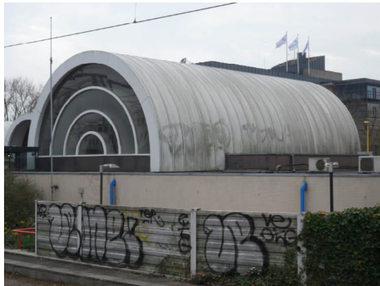
Afb. 4.2.4 De verwaarloosde spoorzijde van het stationsgebouw.
