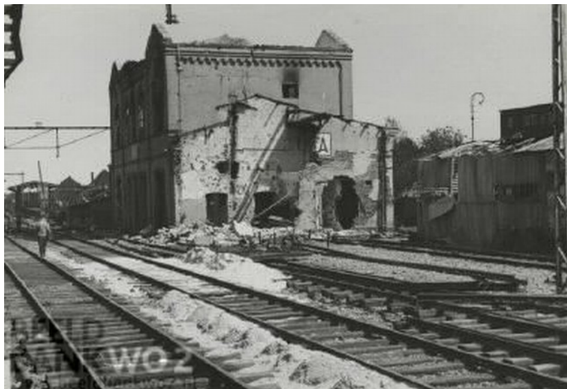
Afb. 2.3.6 Het beschadigde station in 1944. Op de voorgrond de verwoeste westvleugel, daarachter de zwaar beschadigde bovenverdieping van het hoofdvolume. Bron; Beeldbank WO 2.
