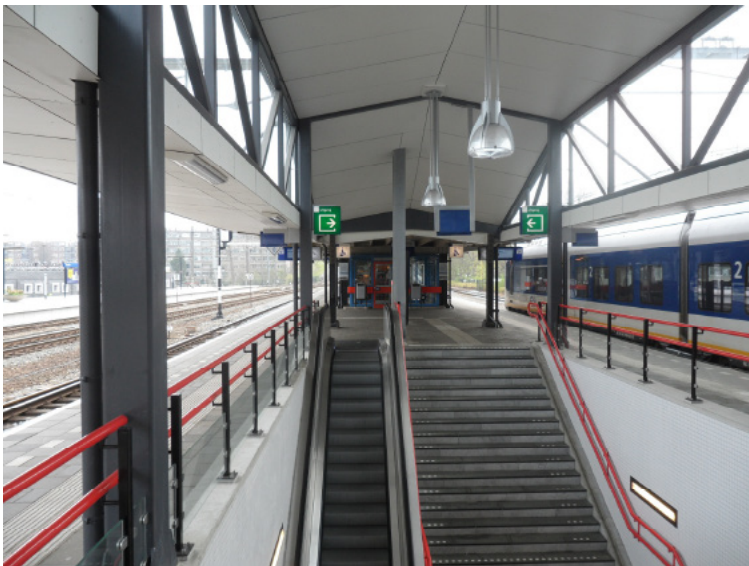
Afb. 2.4.5 De vernieuwde (rol)trap naar het eerste perron, met daarboven de nieuwe perronkap. Op de achtergrond de Kiosk aan de oostzijde van het perron.
