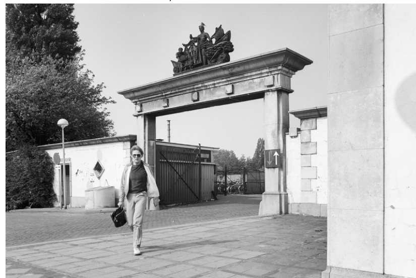
Afb. 2.3.9 De Grote toegangspoort in de muur tussen Stationsplein en goederenemplacement. Foto 1981. Bron; Rijksdienst voor het Cultureel Erfgoed, fotonr 20081431
