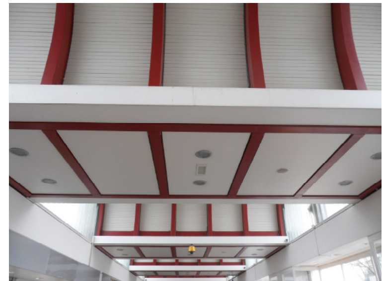
Afb. 5.6.2 De vlakke plafonddelen zijn ingevuld met trespa-platen. De ritmiek van de dakconstructie loopt door in de vlakke plafonddelen in de stationshal.
