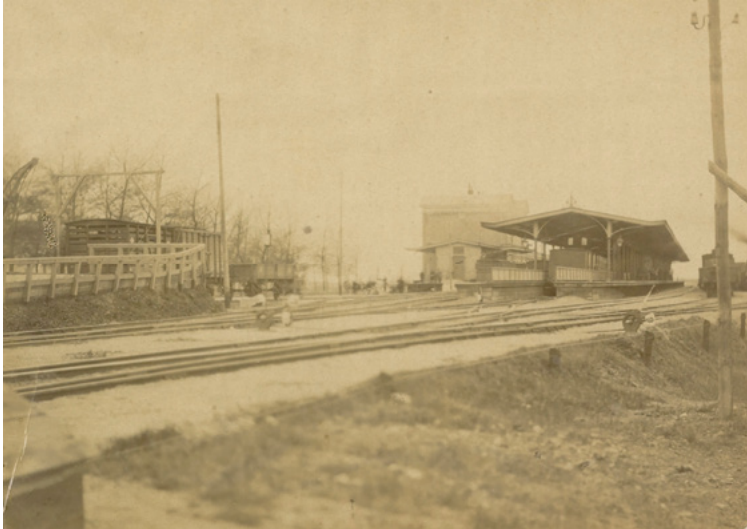
Afb. 4.1.8 Het emplacement in 1881, gezien vanuit het noordoosten. Foto mei 1881 nr 7980, Streekarchief Midden Holland.
