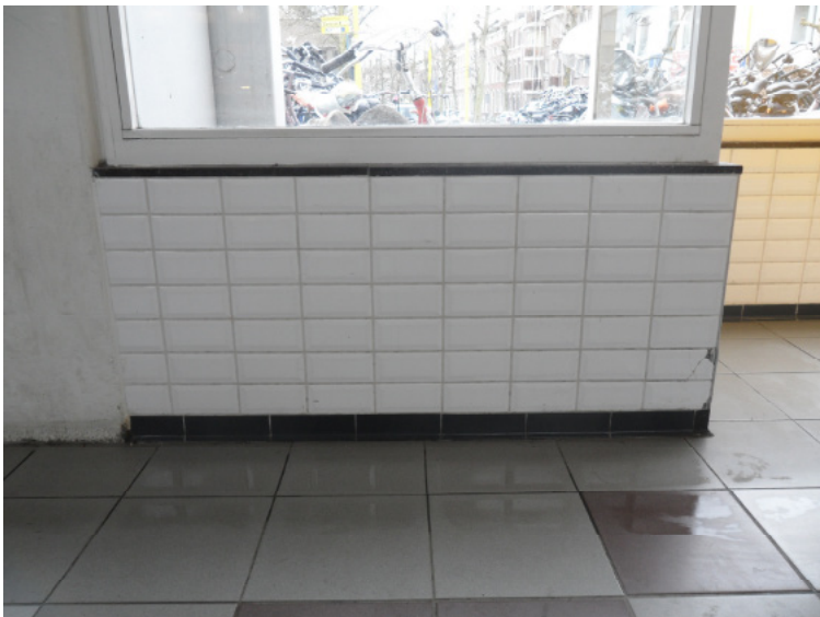
Afb. 5.6.5 Onder de raampartijen is een plint van tegels aangebracht. Bij het kozijn zijn zij afgesloten met een smalle hardsteenplaat, bij de vloer met een rand zwarte tegeltjes. Links een tot de vloer doorlopende witgeschilderde pilaster.
