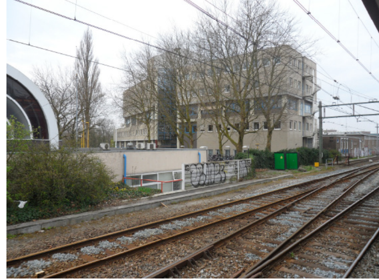
Afb. 3.2.12 De westelijke kantoorbebouwing, gezien vanaf perron 1.
