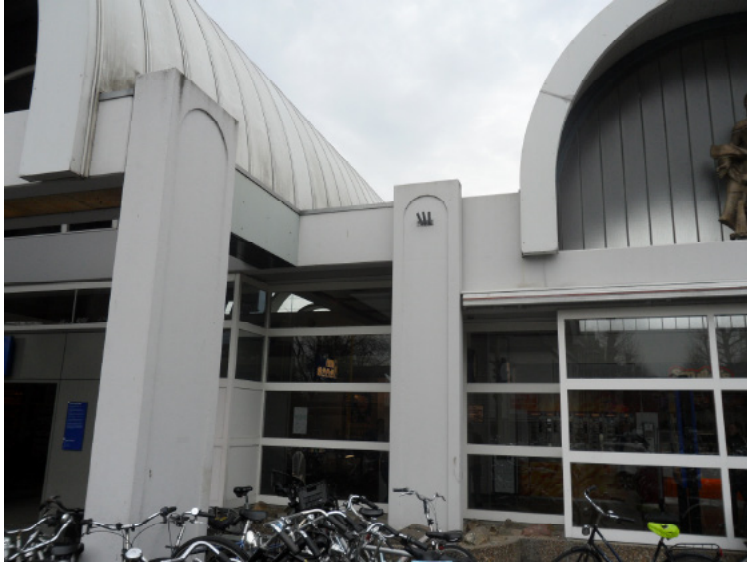
Afb. 5.5.17 Detaillering van de overgang van kap naar stationshal met naar binnen geplaatste vensters en kleine pilasters tussen de tongewelven.
