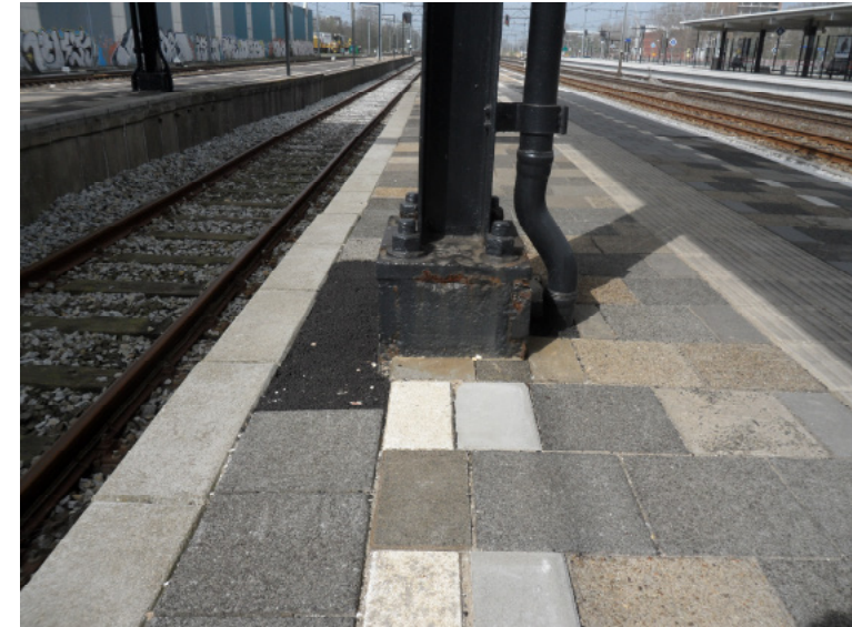
Afb. 4.2.10 Vooroorlogse voet van een perronkap op het westelijk deel van het eerste perron.
