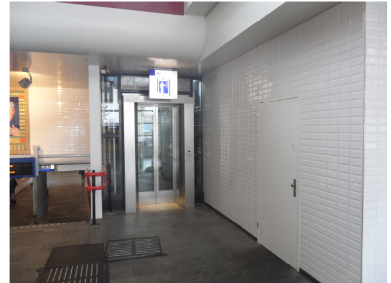
Afb. 2.4.6 De nieuwe liftschacht (rechts) in de stationshal naar de tunnel (linksachter).
