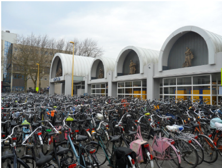
Afb. 5.5.19 De voorgevel met links de hoofdentree en daarnaast drie van vier kleine kappen boven de stationshal.
