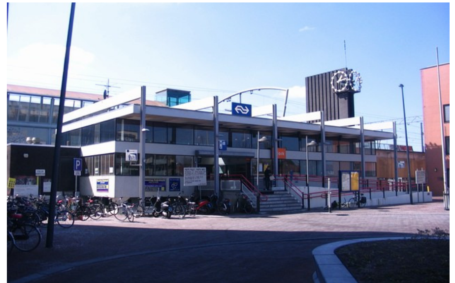
Afb. 5.1.4 Station Zwijndrecht in 2013. Ontwerp C. Douma in samenwerking met M.W. Markenhof. De achterliggende stationsuitbreiding is uit 1996 naar ontwerp van P.H. van de Ree.
