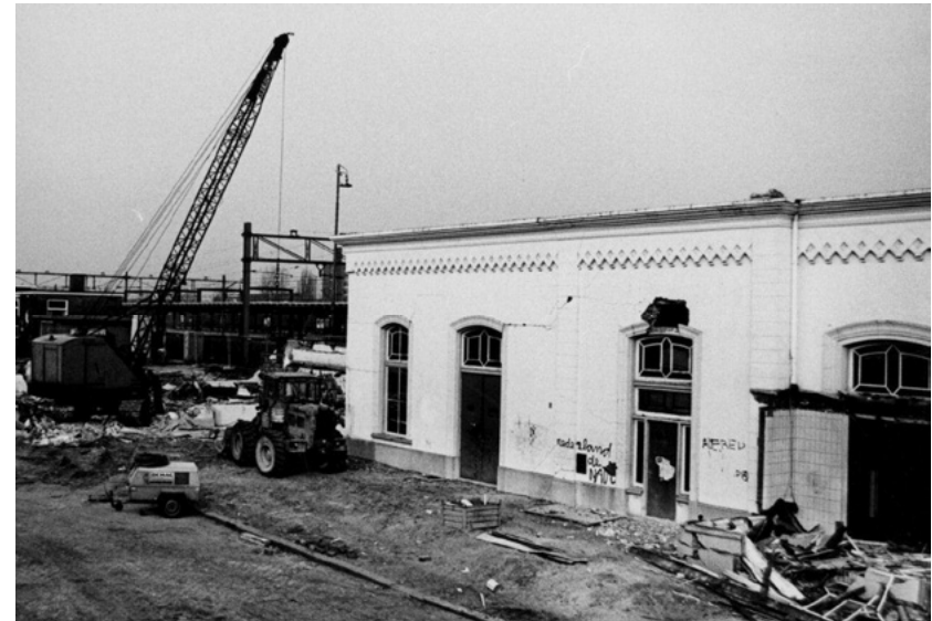
Afb. 2.3.13 De afbraak van het station in 1983.
