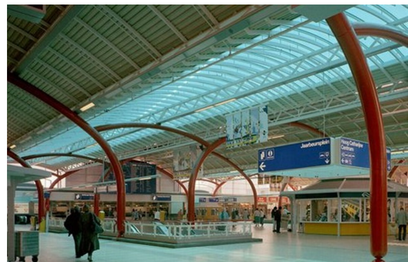
Afb. 5.1.6 De nieuwe hal van station Utrecht Centraal in 1989. Ontwerp van M.W. Markenhof.
