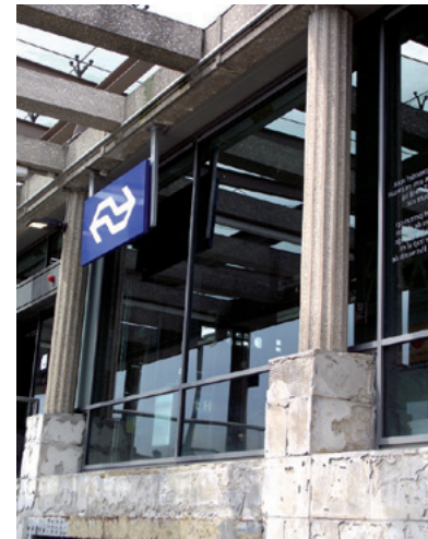
In plaats van op een borstwering te staan, hebben de kolommen nu sokkels gekregen
