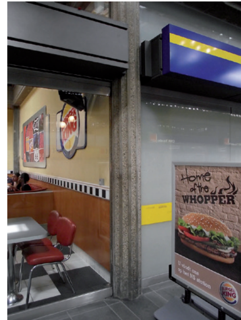
Vrijstaande Pilaren zijn pilasters geworden
