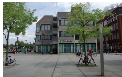
ABN-AMRO gebouw uit de jaren '80 (2011)
