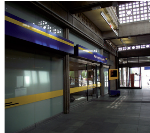
Glazen wanden zijn dichtgezet of beplakt
