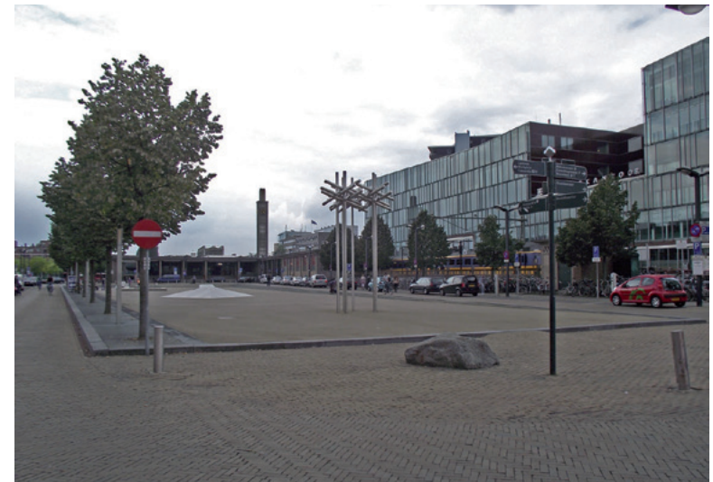
Het stationsplein in westelijke richting met rechts het Stadskantoor van architect Frits van Dongen (2001)
