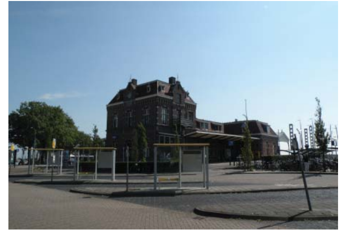
(afb. 120) de reizigers lopen aan de noordzijde langs het stationsgebouw om het perron te bereiken, in plaats van door het stationsgebouw
