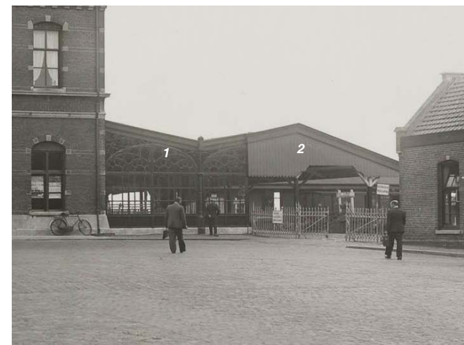
(afb. 86) zicht op de westelijke overkapping (1) en de uitbreiding westelijke overkapping (2) / foto 1932 SWM
