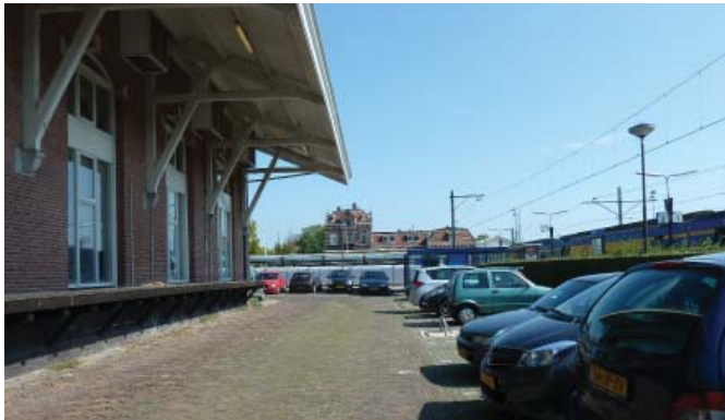
(afb. 121) de verbinding tussen het stationsgebouw en de goederenloods is verstoord met de komst van de parkeerplaatsen en fietsenstallingen
