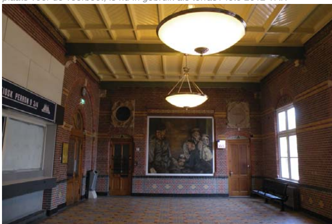
(afb. 6) het bijzondere interieur van de stationshal met wanden uit schoon metselwerk met decoratiewerk van geglazuurde baksteen / foto 2012 TAK
