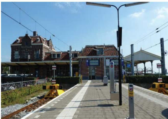
(afb. 124) de overkappingen zijn in vorm aangepast of verwijderd, waardoor de reiziger niet meer het 'beschutte idee' ervaart
