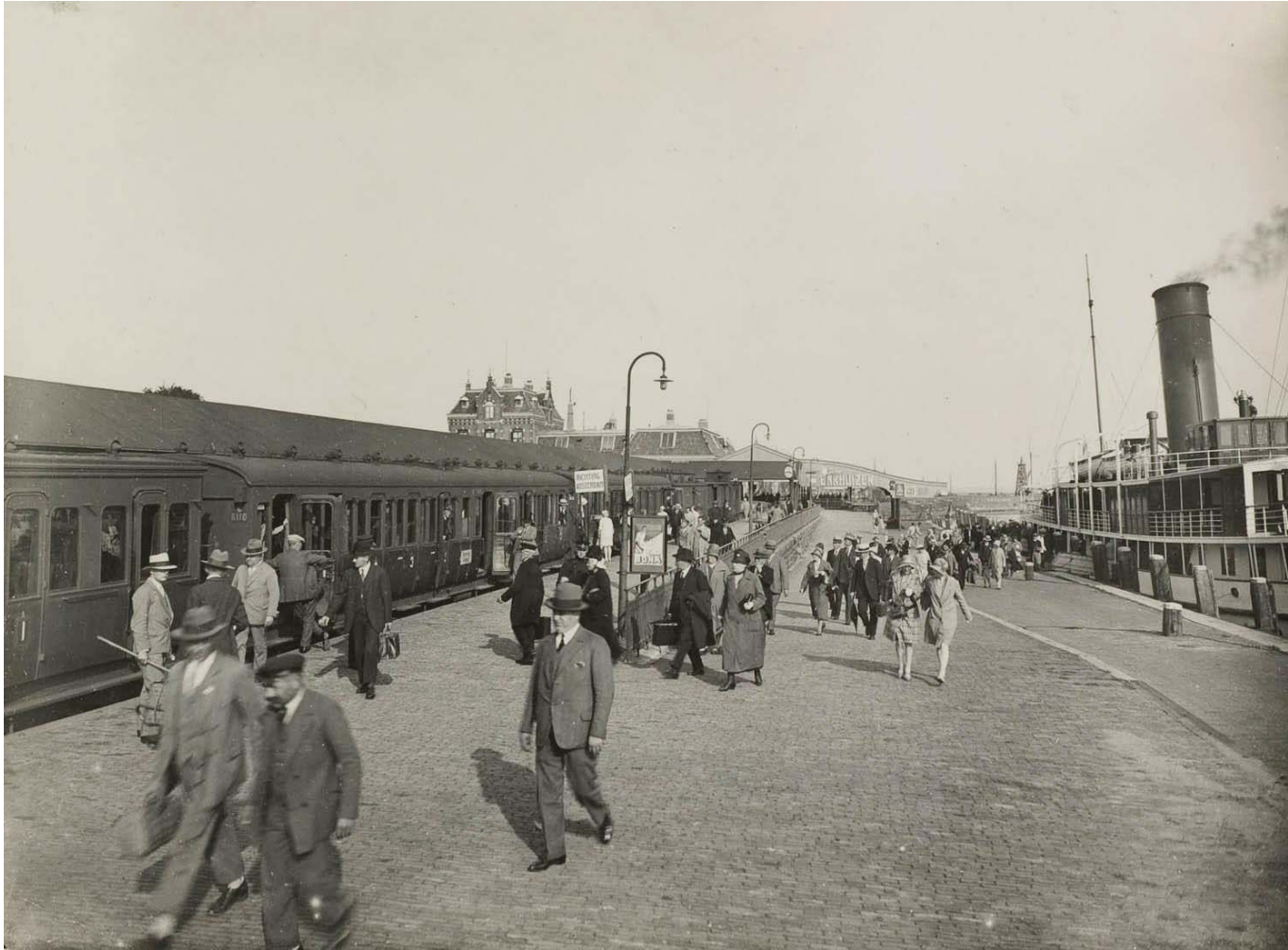
(afb. 97) zicht op westgevel van het station in 1935 waarop te zien is dat de oorspronkelijke dakkapellen zijn vervangen door dakramen / foto 1935 SWM
