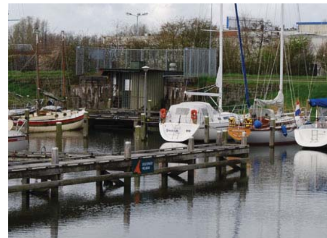
(afb. 47) restant van de overgangsbrug in de huidige situatie / foto 2012 TAK
