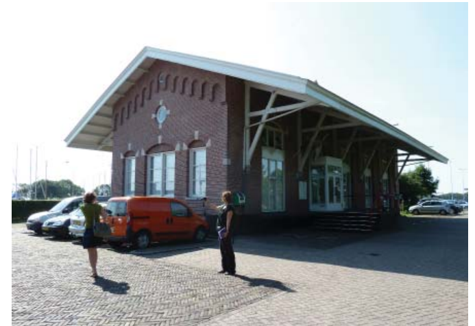
(afb. 3) de goederenloods, ontworpen in chaletstijl / foto 2012 TAK
