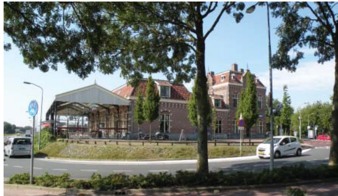
(afb. 122) het station is door de Bosmankade als het ware afgesneden van de omgeving; de vormgeving van het talud draagt bij aan het afgesloten karakter
