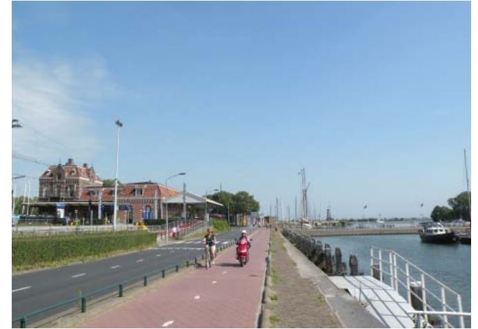
(afb. 2) het stationsgebouw (l) en de voorm. spoorhaven (r); de witte overkapping markeert de vroegere opstapplaats voor de veerboot / foto 2012 TAK
