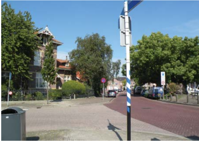
(afb. 29) zicht op het Snouck van Loosenpark (l) en de Buitenhaven (r) vanaf het voorplein van het stationsgebouw / foto 2012 TAK
