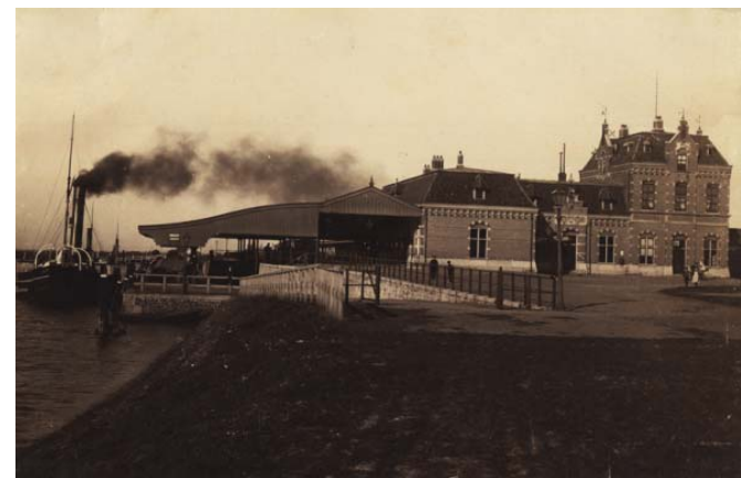
(afb. 54) oostgevel oorspronkelijke situatie / foto collectie KEH
