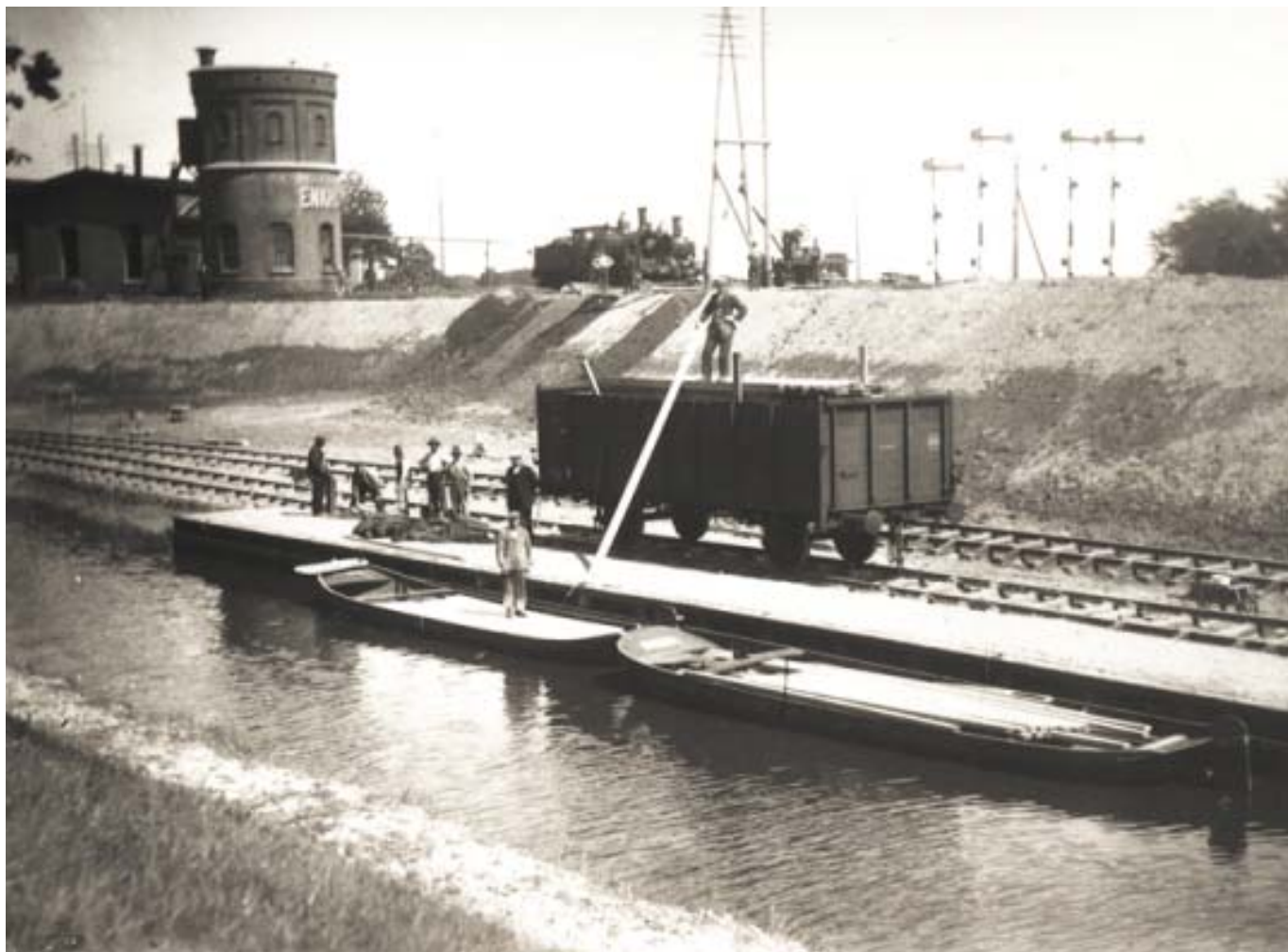
(afb. 42) het laad- en losspoortje in gebruik, met links op de achtergrond de watertoren en een deel van de locomotievenloods / foto 1925 KEH
