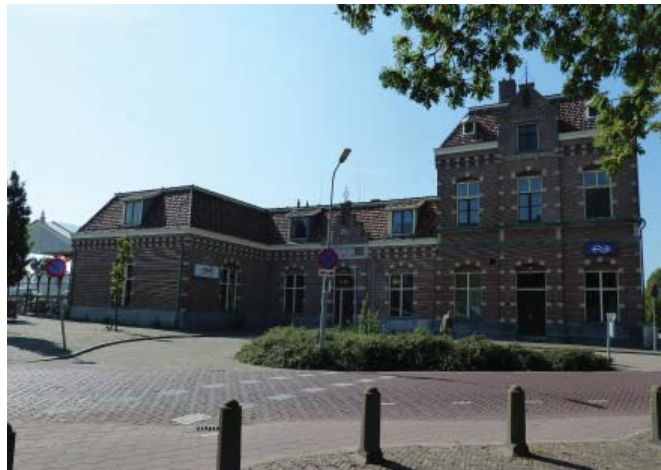
(afb. 52) zicht op de oostzijde van het gebouw in de huidige situatie / foto 2012 TAK
