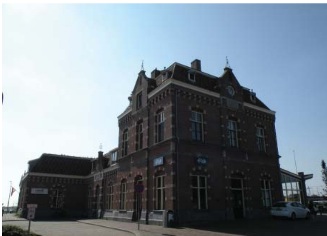
(afb. 113) zicht op het station vanuit het noordoosten / foto 2013 TAK
