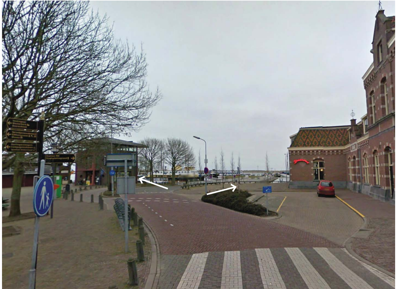
(afb. 35) het zicht langs het station op het water wordt belemmerd door de Gependam en het nieuwe VVV-gebouwtje / foto 2009 Google Streetview
