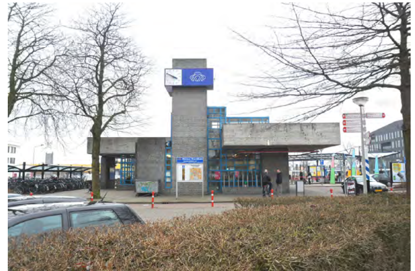
Afb. 4.4 De noordgevel van het station met centraal de stationstoren. Links van de toren de technische ruimte en rechts, onder de betonnen kap, het plaatskaartenkantor.
