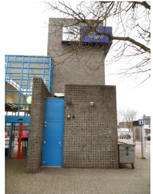
Afb. 2.26 Aanzicht vanaf de oostzijde van de technische ruimte en de erachter staande toren. Op de voorgrond de buitenentree tot het plaatskaartenkantoor.
