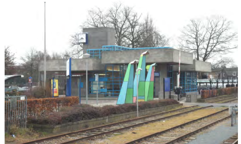
Afb. 3.8 Het kunstwerk tussen rondrit en spooreplacement
