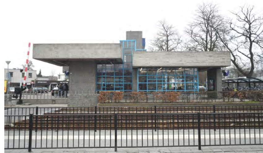
Afb. 4.2 De zuidgevel van het station. Onder het linker dakvlak ligt de hal, onder het rechter dakvlak de wachtruimte. Tussen de daken staat de lichtstraat.
