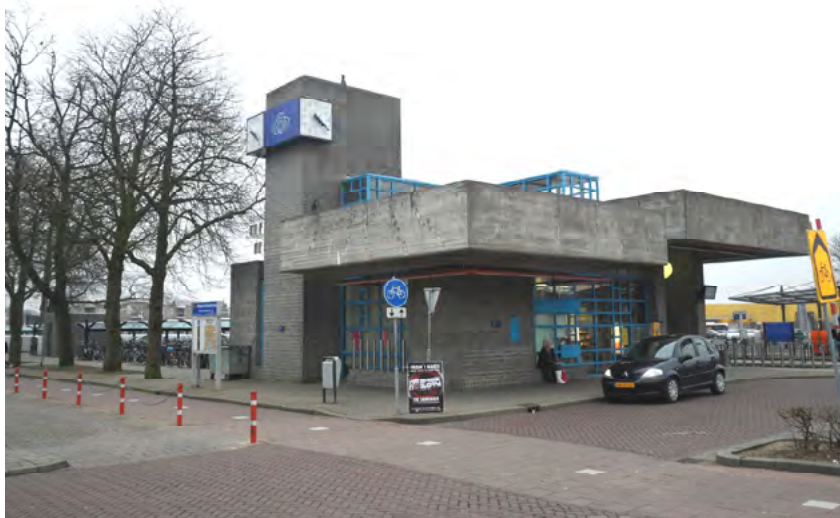
Afb. 3.10 De omgeving van het stationsgebouw aan de noordwestzijde.
