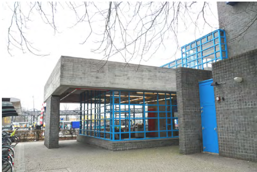
Afb. 4.3 De oostzijde van het station met de wachruimte. Rechts de technische ruimte en erachter de stationstoren. Links is de wachruimte. In het midden de lichtstraat.
