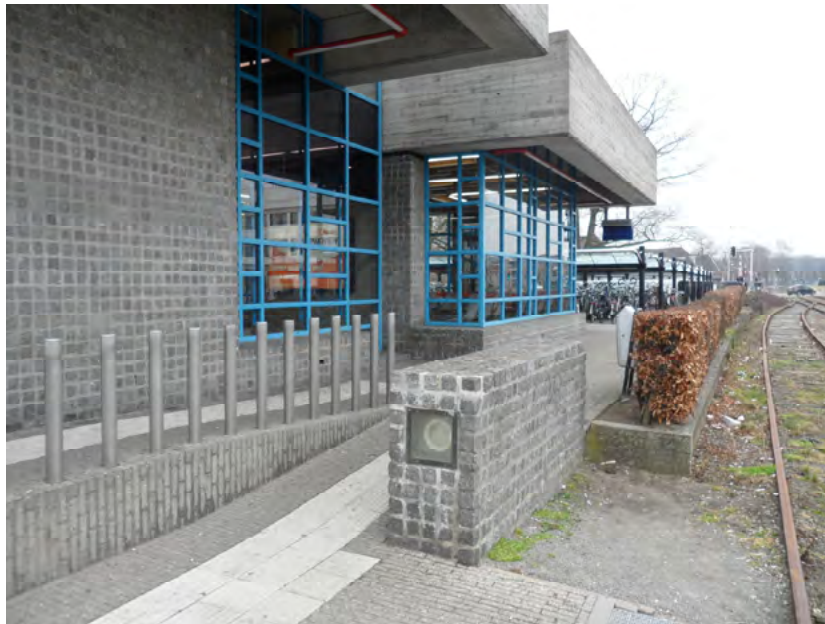
Afb. 4.7 Het originele keienmuurtje en de klinkerrand aan weerszijden van de hellingbaan.
