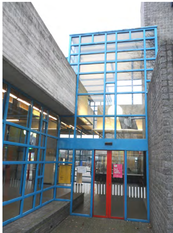
Afb. 4.10 De oostelijke entree in de lichtstraat.
