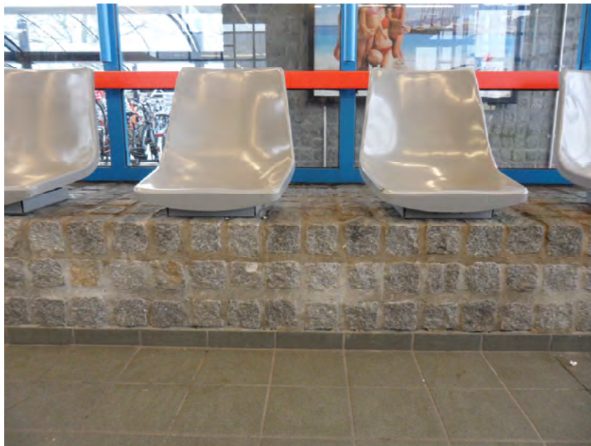
Afb. 4.18 De kuipstoeltjes op de keienrand. Eronder de tegelplint tussen keienrand en tegelvloer.
