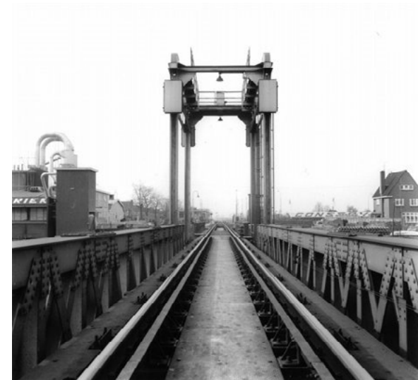
Afb. 2.13 De spoorbrug over de IJssel. Foto 1966, HUA.
