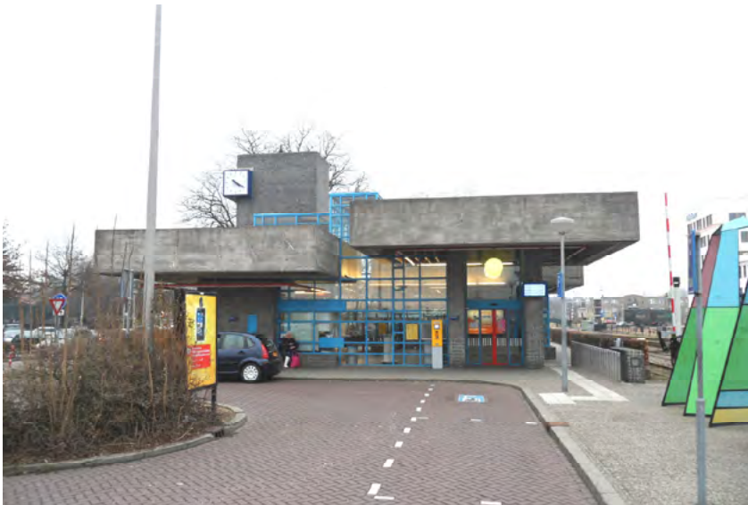
Afb. 4.1 De westgevel van het station. Rechts de westelijke entree, met ernaast de hal
