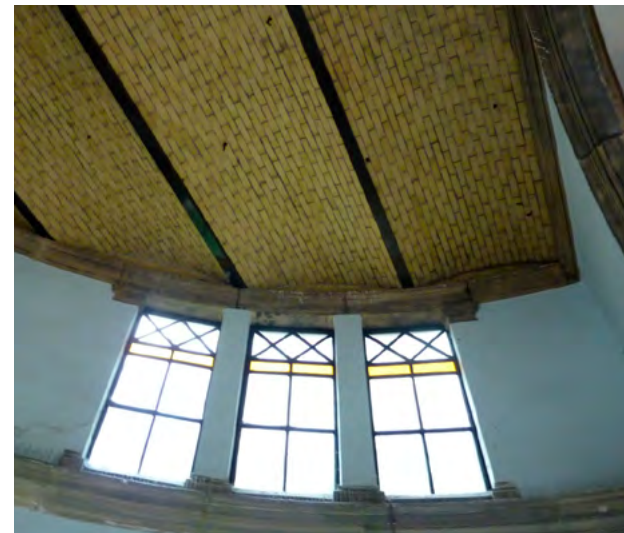
Getoogd plafond van gele baksteen, keerwand uitgangstunnel
