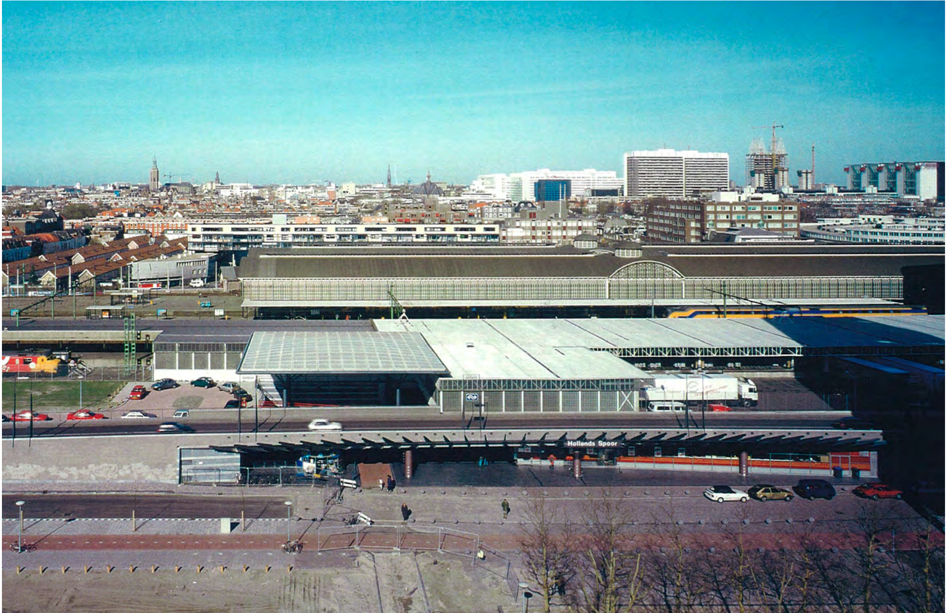
Vogelvlucht van nieuw aangebouwde achterkant Station Hollands Spoor. Daarachter het station van Margadant. Links de Kiss and Ride zone (Laakplein) en vooraan de Waldorpstraat.
