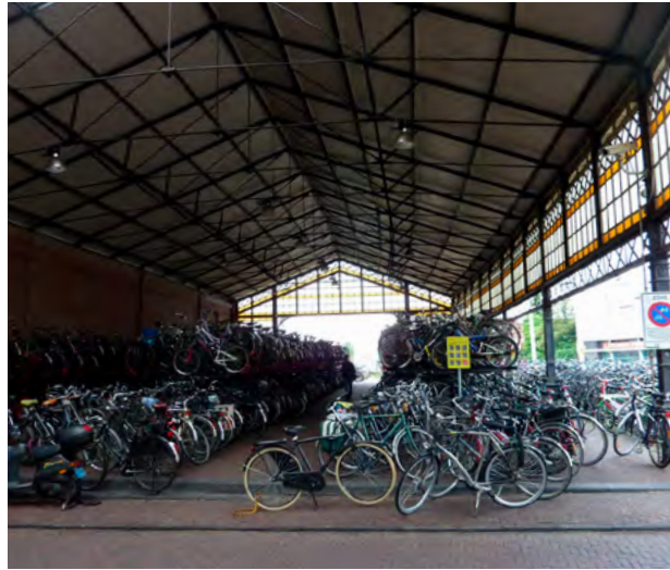
Fietsenstalling onder rijtuigkap
