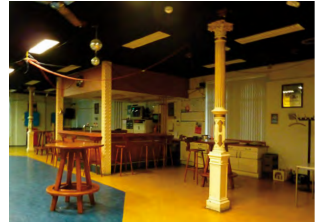
Kolommen uit de eerste bouwphase in de SOV-ruimte. De buitenste kolommen zijn geornamenteerd, de middelste twee niet, omdat deze oorspronkelijk waren opgenomen in een scheidingswand.
