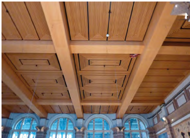
Plafond zoals aangebracht in de derde bouwphase.
