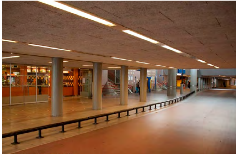
Fietserstunnel met winkels en betonnen draagkolommen
