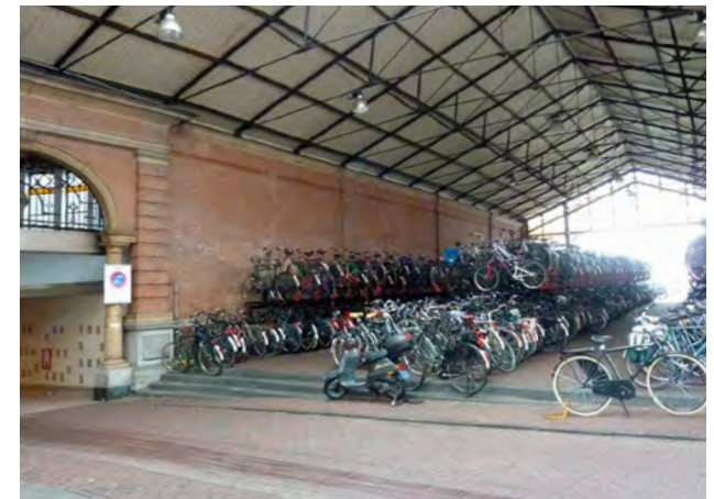
5. Fietsenstalling onder rijtuigkap
