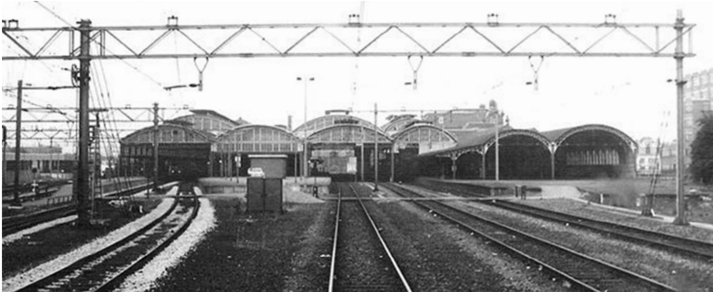
De oorspronkelijke perronoverkapping reikte tot op het derde perron. Rechts is de overkapping van de Hofpleinlijn nog zichtbaar, terwijl de lijn al was opgeheven.
