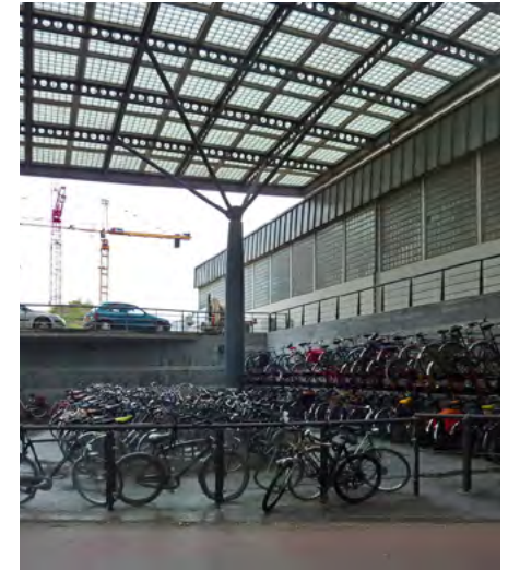
Fietsenstalling achterkant station
