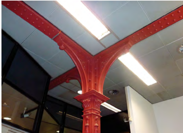
Kolommen uit de eerste bouwphase in de kantoorruimten op de begane grond.
