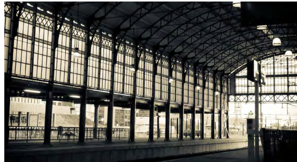
De perronkap na 1989, na realisatie derde perron en aanbouw van luifel. De trap met hekwerk vanuit de uitgangstunnel (links op de foto) werd tijdens de derde bouwphase toegevoegd.
