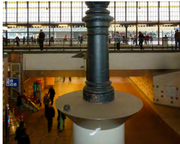
Draagkolom spooroverkapping op nieuwe betonnen draagkolom.
