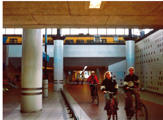
4. Fietserstunnel onder het tweede perron
