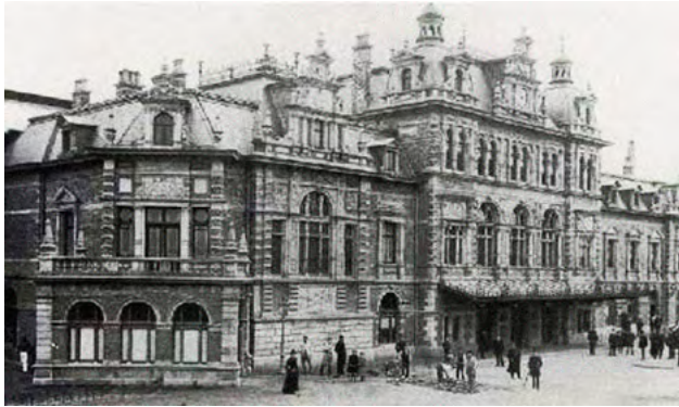
Foto van voor 1900. Voor de uitbreiding voor de Hofpleinlijn bevond zich links van de uitbouw de entree naar het Koninklijk Paviljoen.
