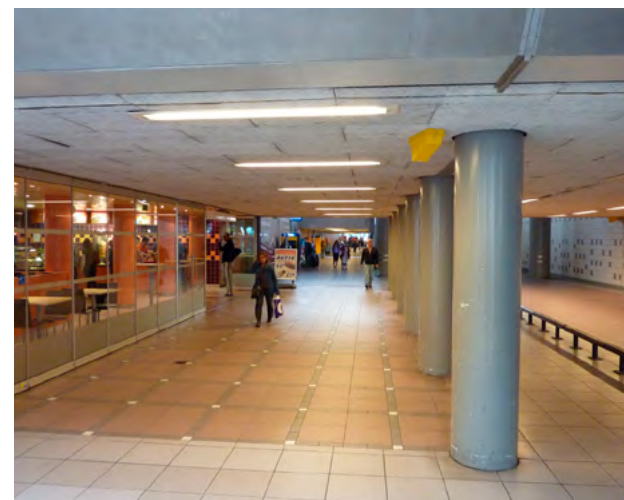
Uitgang- en fietserstunnel met links winkels/horeca, betonnen draagkolommen en laag plafond bekleed met platen
