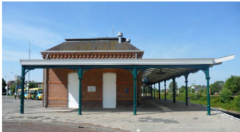
Afb. 5.2.7 Perronoverkapping aan de oost- en noordzijde van het station.
