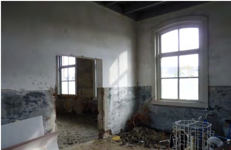
Ruimte in oostvleugel
