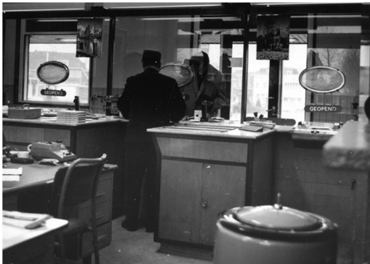
Afb. 2.4.9 Het interieur van het vernieuwde plaatskaartenkantoor. Foto 1970
