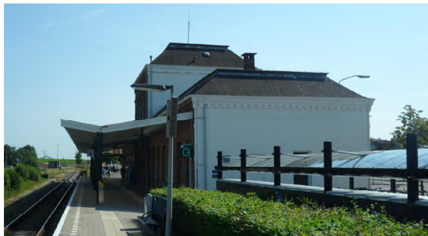
Afb. 5.2.2 Station Delfzijl met de kenmerkende platte daken, met rondom schuine schilden. De westgevels van het station zijn afgewerkt met witgeschilderd Portland-cement.
