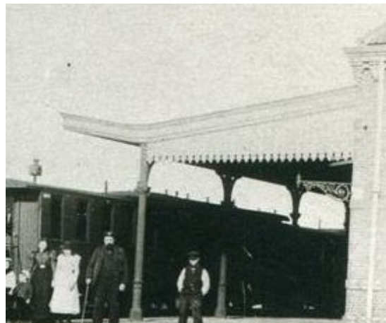
Afb. 5.2.9 De afwerking van de perronkap aan de westzijde, rond 1900. het zijvlak is afgewerkt met latwerk met houtsnijwerk. Zichtbaar is dat alle zuilen een Korintisch kapiteel dragen. Op de hoek van het gebouw hangt eenzelfde lantaarn als aan de voorzijde.
