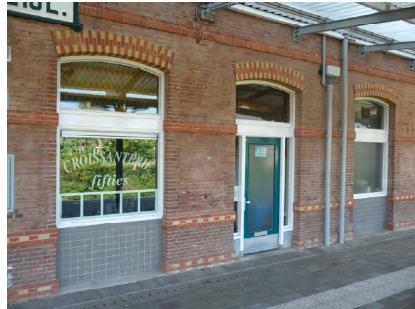
Afb. 5.2.6 Deur en vensters aan de perronzijde in het hoofdvolume.
