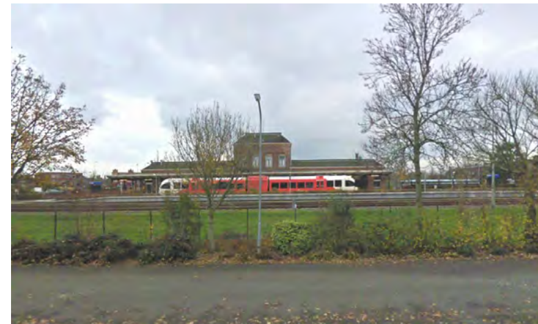
Afb. 3.2.9 Zicht op de perronzijde van station Delfzijl, vanaf de Uitwierderweg in de noordelijke woonwijk. Bron; still uit Google Streetview
