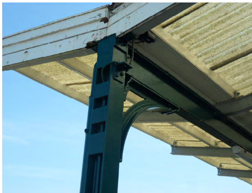
Afb. 5.2.10 De actuele afwerking van de perronkap aan de westzijde. De gietijzeren zuil met kapiteel is vervangen door een stalen balk met I-profiel, zonder kapiteel en met eenvoudiger korbelen. De verticale afwerking met latwerk is geheel verdwenen.
