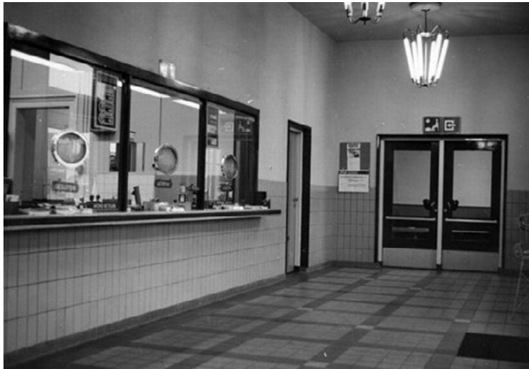
Afb. 2.4.8 De vernieuwde vestibule te Delfzijl. Muren en plafond zijn strak gestuct. Langs de wanden is een tegellambrisering aangebracht. De wachtkamer heeft eigentijdse deuren met matglas en het lokettenfront is vernieuwd. Foto 1970
