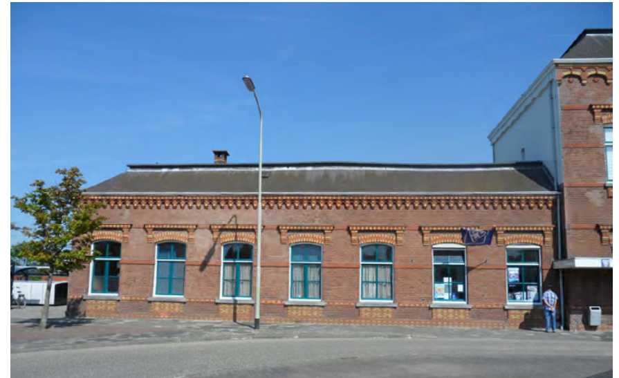
Afb. 5.2.3 Station Delfzijl kenmerkt zich door toepassing van geel siermetselwerk in de roodstenen muren. In tegenstelling tot de andere stations van het type heeft het gebouw geen decoratie van speklagen
