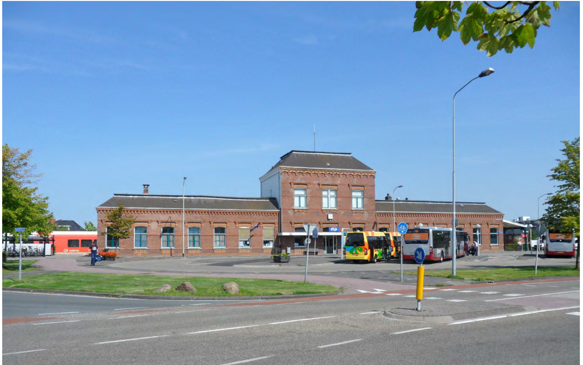
Afb. 3.2.7 Het ensemble van stationsgebouw met het voorliggende plein en busstation in de actuele situatie. Door de kaalheid en gebrek aan doordachte inrichting die rekening houdt met het station, ligt het gebouw kaal in de ruimte en in de beleving los van de stad. Het stationsgebouw mist zo de kracht die het heeft bij een samenhangende aankleding van de omgeving.
