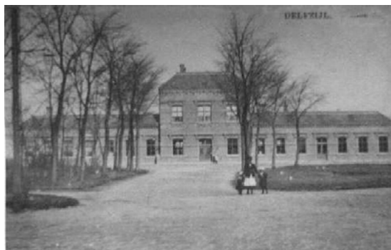
4 Station Delfzijl, geopend 15 juni 1884, foto 1890
