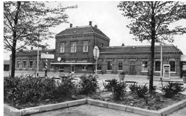
Afb. 2.4.7 Station Delfzijl in 1966. Op het dak van het hoofdvolume zijn de vier schoorstenen nog aanwezig. De stationskap (rechts) heeft nog de verticale houten afwerking.
