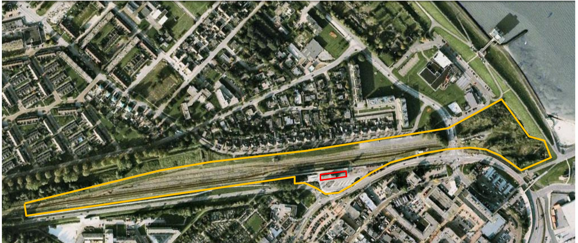
Afb. 4.1.4 Het langgerekte emplacement van Delfzijl op een recente luchtfoto. Rechts van het midden staat het station. Geheel rechts ligt het perceel van de vroegere locomotiefloods. Over de gehele breedte ligt een rangeerterrein. Nabij de locomotiefloods wordt het emplacement doorsneden door de spoor kruising met de Kustweg. Bron: Google earth
