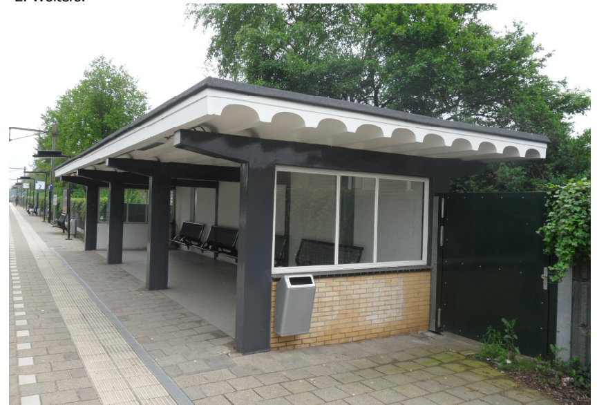
Afb. 4.9 Het actuele wachtgebouw op perron 2, met open voorzijde.
