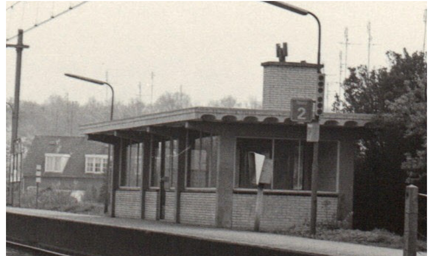
Afb. 4.7 Het wachtgebouw op perron 2 in 1978. Detail van foto. Coll. P. Collet.
