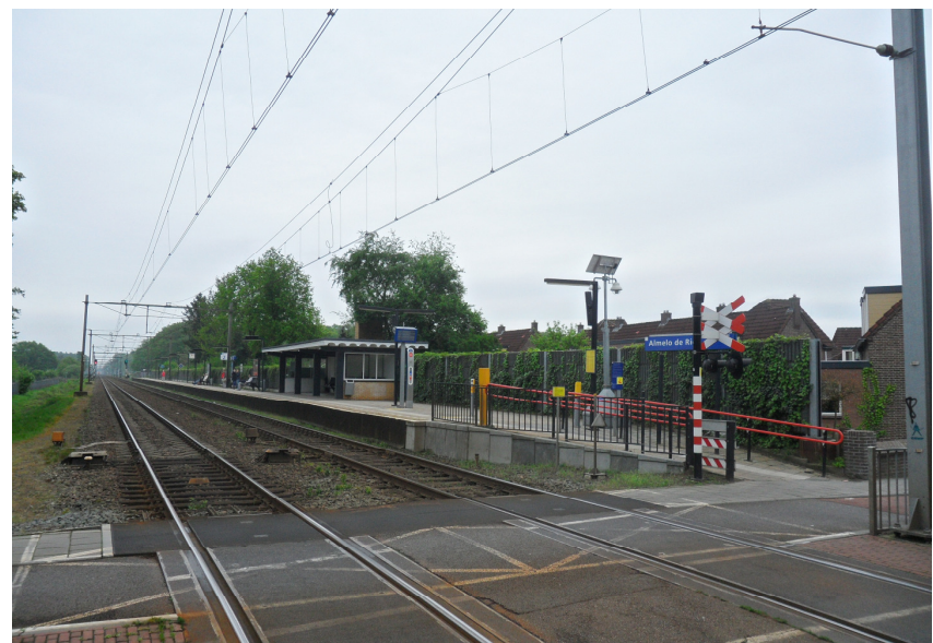
Afb. 4.19 Perron 2, met de wachtruimte, gezien vanaf het stationsgebouw.
