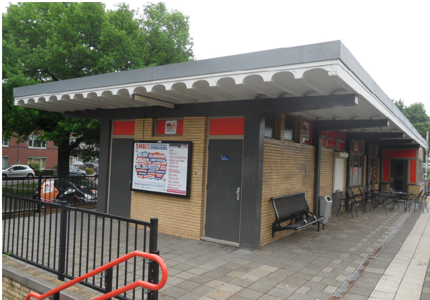
Afb. 5.13 De kopgevel aan de noordzijde van het gebouw.
