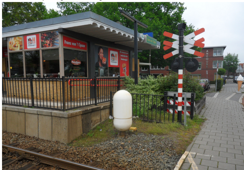
Afb. 5.12 De kopgevel aan de zuidzijde van het gebouw.
