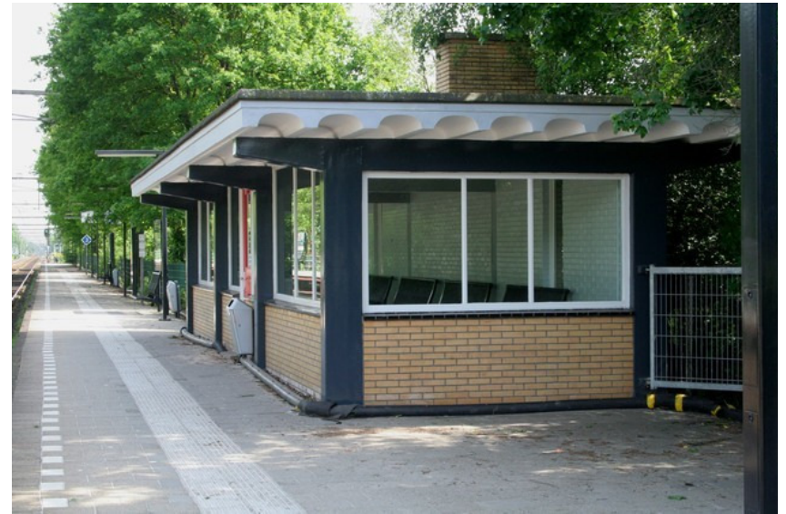
Afb. 4.8 Het wachtgebouw op perron 2 met de voorgevel nog aanwezig. Foto 2009, E. Wolters.
