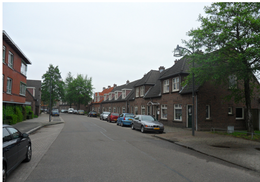
Afb. 3.6 De Rietstraat, gezien vanaf de spoorwegkruising naar het noordoosten.
