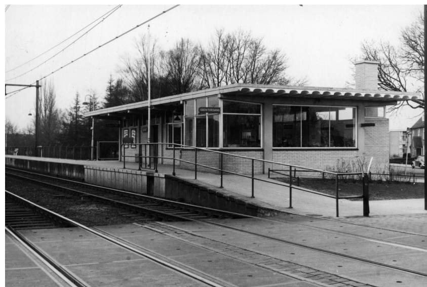
Afb. 2.6 De zuidzijde van het stationsgebouw. Links de uitbouw/ erker aan het plaatskaartenkantoor, van waaruit extra zicht is over overweg en perrons. Coll. HUA, cat.nr 153208, 3 maart 1959
