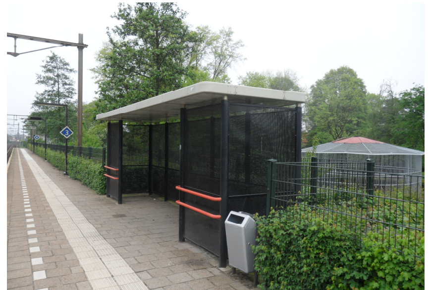
Afb. 4.14 De abri met staalgaaswanden op perron 1.
