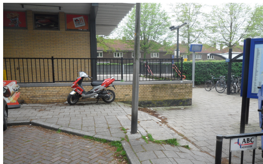
Afb. 5.20 De originele keermuur met later hekwerk bij voor- en noordgevel van het station.
