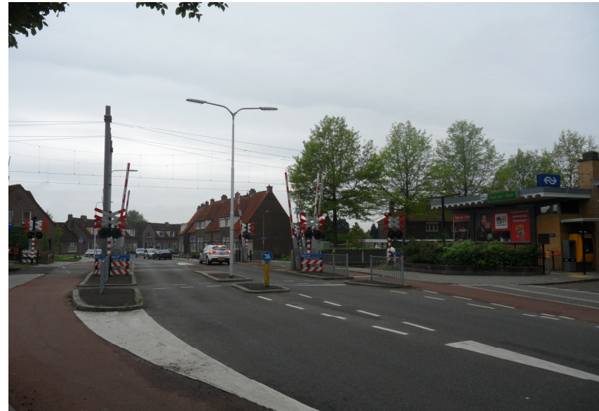
Afb. 4.18 De spoorwegkruising, gezien vanuit het noordoosten, met rechts het station.
