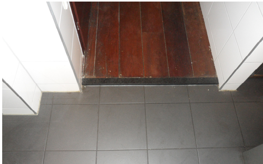
Afb. 5.24 De vloerafwerking in de snackbar (grijze vloertegels) en het café (houten planken).
