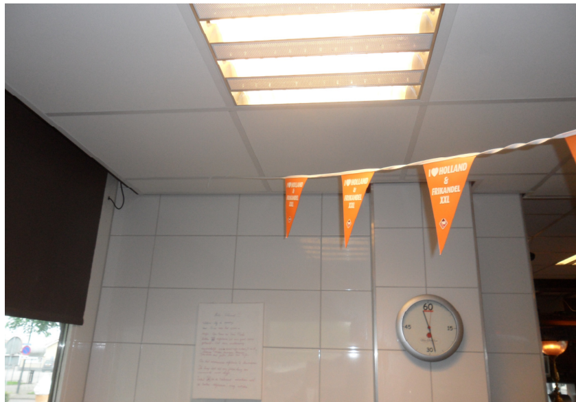
Afb. 5.23 Achter de klok de vooruitspringende, betegelde paal van het derde betonportaal. De paal is de oorspronkelijke locatie van de buitengevel, nu links zichtbaar.
