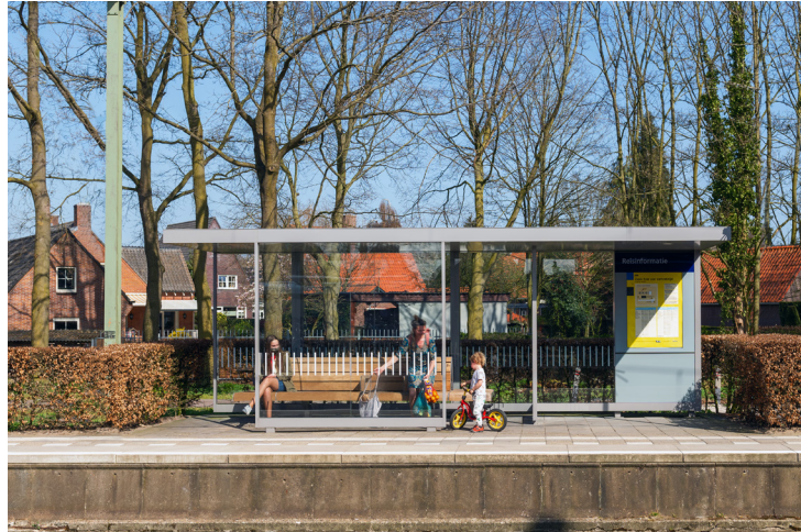
Beschuttingsystemen station Lunteren Fotograaf: Roos Aldershoff
