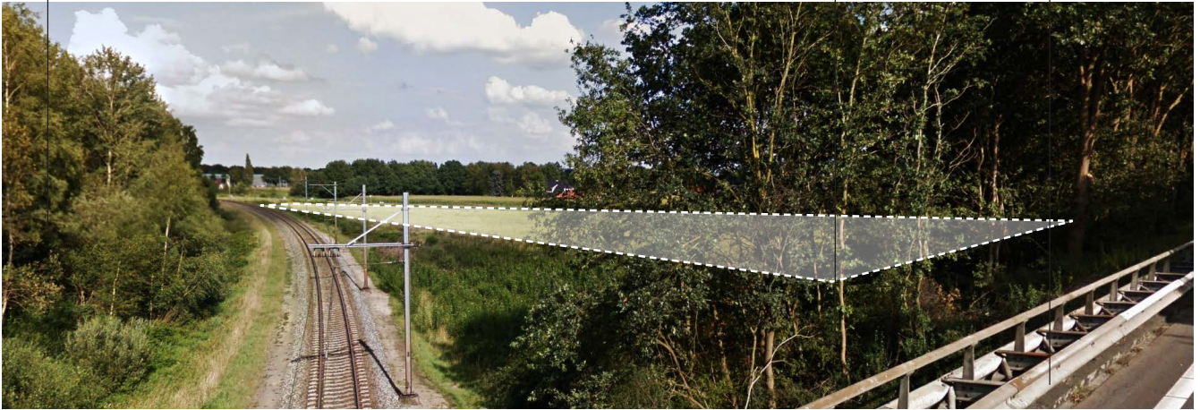
zicht vanaf het N36 viaduct kijkend richting het oosten. Beeld: Google Streetview
