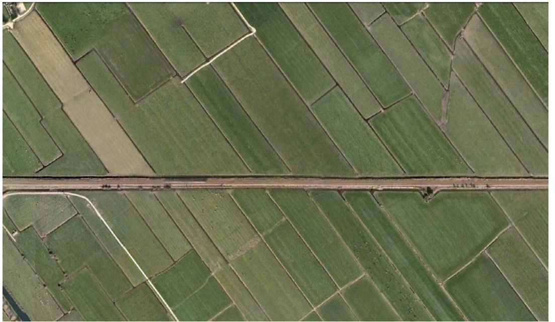
Een spoorlijn roept meestal geen ontwikkelingen op en ligt daarom vaak autonoom in zijn omgeving (Friesland)
