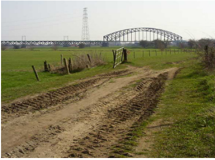
De spoorbrug bij Oosterbeek over de Nederrijn.
