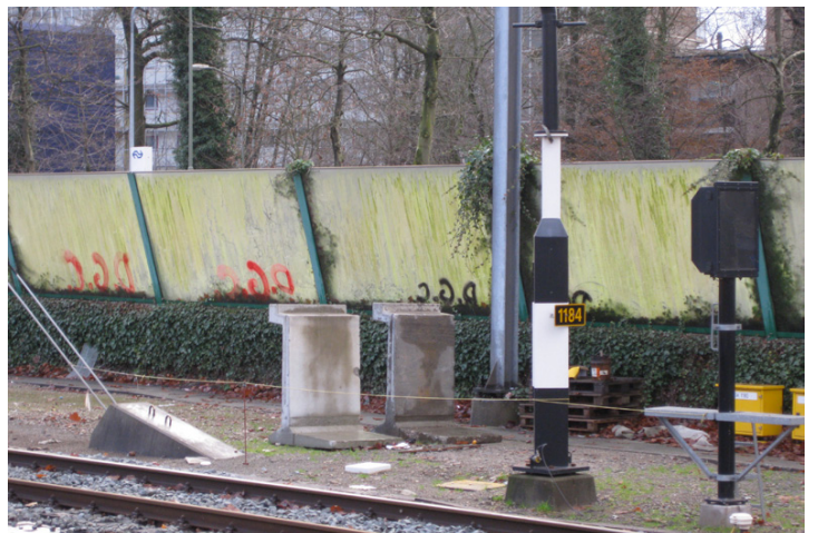
Goed onderhoud is daarbij onontbeerlijk (station Dordrecht).
