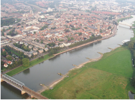
Spoorbrug over de IJssel bij Deventer
