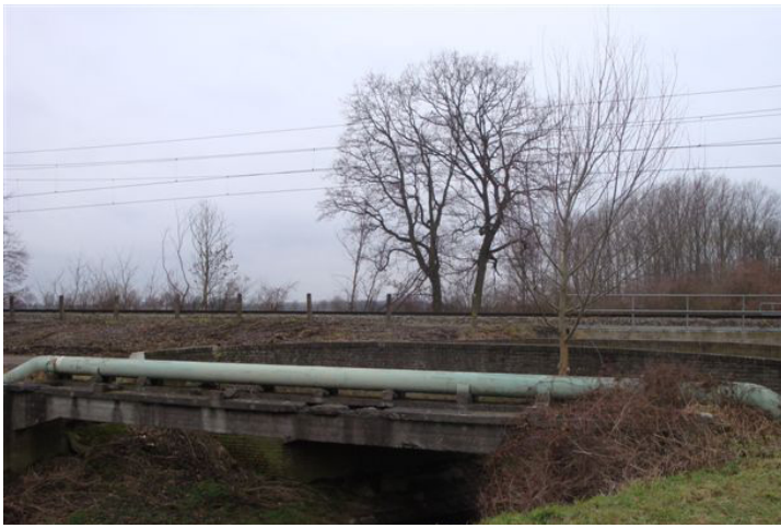
Spoorbrug over de Vloedgraaf bij Susteren, oude situatie
