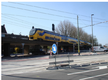
Het spoorviaduct in Delft
