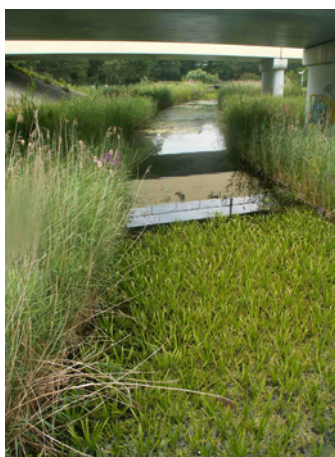
Ecologische verbinding onder het spoor bij Abcoude
