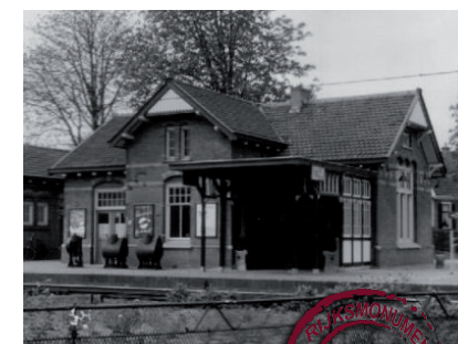
Soestdijk 1897 ULS J.F. Klinkhamer Rijksmonument
