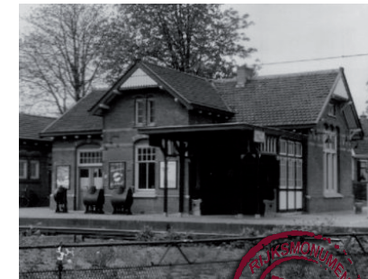
Soestdijk 1897 ULS J.F. Klinkhamer Rijksmonument
