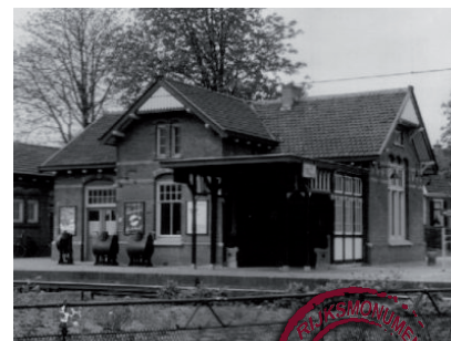
Soestdijk 1897 ULS J.F. Klinkhamer Rijksmonument
