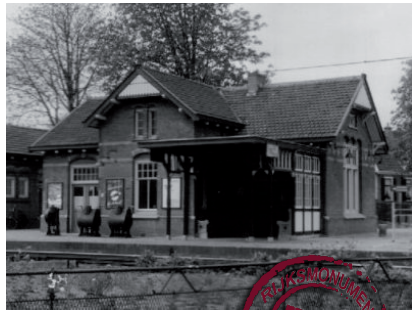
Soestdijk 1897 ULS J.F. Klinkhamer Rijksmonument
