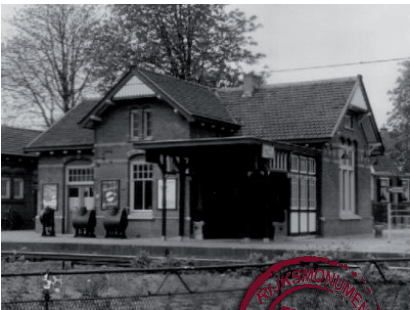
Soestdijk 1897 ULS J.F. Klinkhamer Rijksmonument
